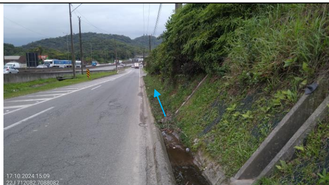
Figura 55: Drenagem da via pública, próximo a estrutura de contenção e drenagem dos taludes. Fonte: Autor, 2024
