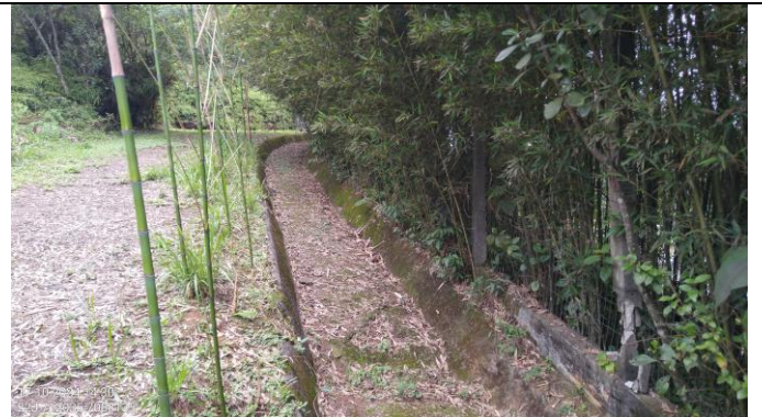
Figura 49: Trecho 23-D (Galeria pluvial). Fonte: Autor, 2024.
