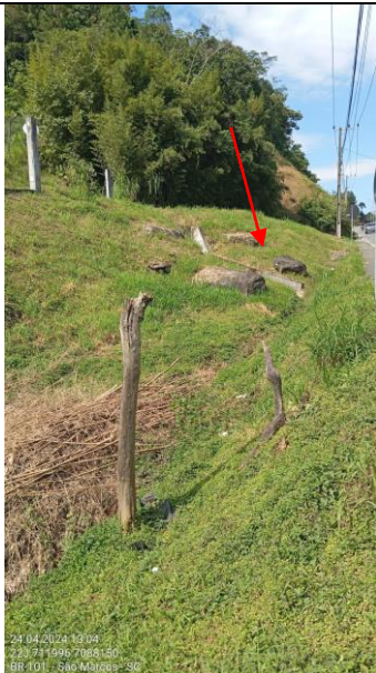
Figura 48: Trecho 23-B (Seta demonstrando a galeria pluvial) e 23-A (aberto). Fonte: Autor, 2024.
