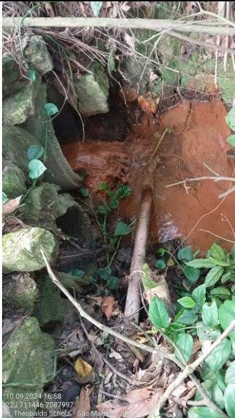
Figura 73: Trecho 51 tubulado (final do tubo). Fonte: Autor, 2024.
