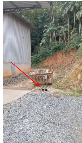
Figura 72: Trecho 50 tubulado evidenciando a caixa de passagem. Fonte: Autor, 2024
