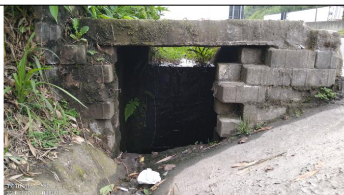
Figura 56: Caixa de inspeção da drenagem pluvial da marginal. Fonte: Autor, 2024
