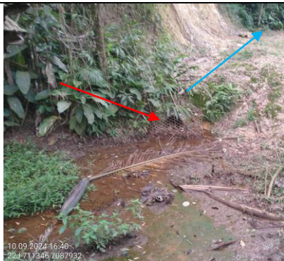
Figura 71: Trecho 49 tubulado. Fonte: Autor, 2024
