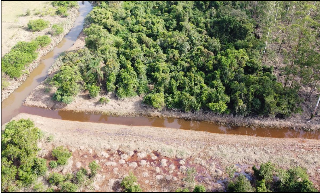
Figura 36 - Trecho 32 (Início Trecho: 7086038.97 m S, 710791.95 m E; Final Trecho: 7086049.52 m S, 710715.93 m E).
