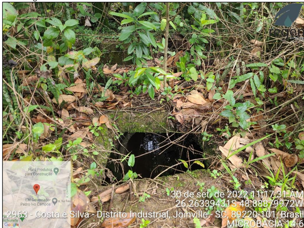
Figura 24. Registro fotográfico realizado in loco , caracterizando o acesso a galeria do trecho 29 – curso d'água tubulado. A foto foi realizada sob o trecho 29 em direção ocular ao trecho 28. A seta vermelha caracteriza a direção da "vala" fechada. Fonte: Primária, 2022.
