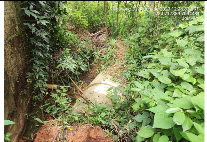
Figura 20: Trecho 8 (tubulado) Fonte: Autor, 2023
