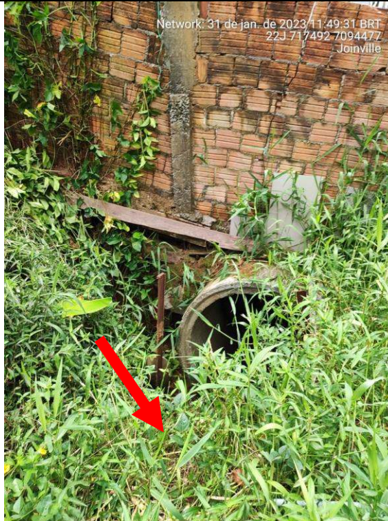
Figura 25: Limite entre os trechos 12 e 13 (tubulados); a seta indica a tubulação do trecho 13 que está coberta pela vegetação
