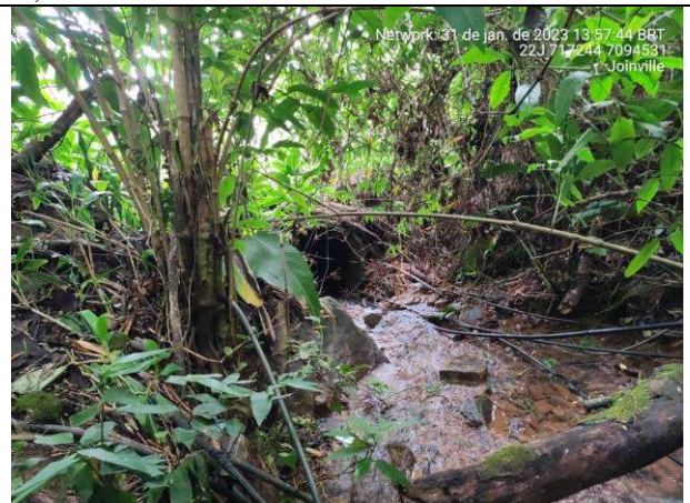
Figura 18: Limite entre os trechos 5 (aberto) e 6 (tubulado)
