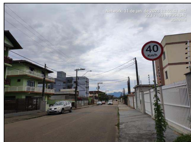
Figura 12: Distribuição de energia elétrica. Fonte: Autor, 2023.
