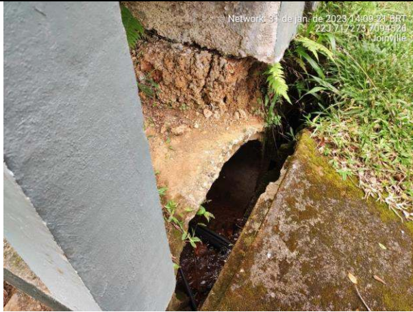
Figura 19: Trecho 6 (tubulado) Fonte: Autor, 2023
