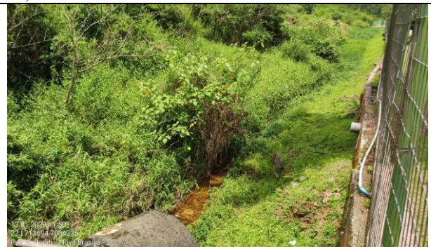
Figura 14: Trecho 3 corpo d'água, entrada para o trecho 4 tubulado. Fonte: Autor, 2023.
