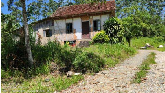
Figura 23: Edificação próxima ao trecho 08. Fonte: Autor, 2023
