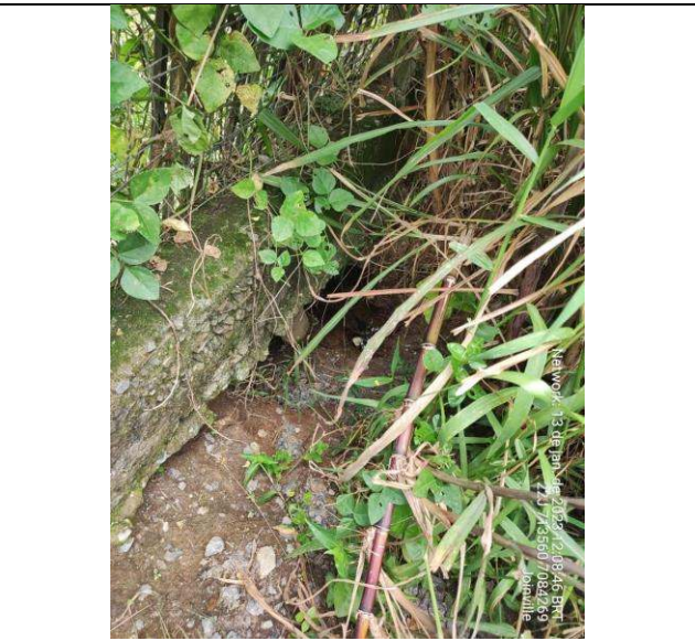
Figura 20: Trecho 7B corpo d'água tubulado sob via, para trecho 7A corpo d'água aberto. Fonte: Autor, 2023
