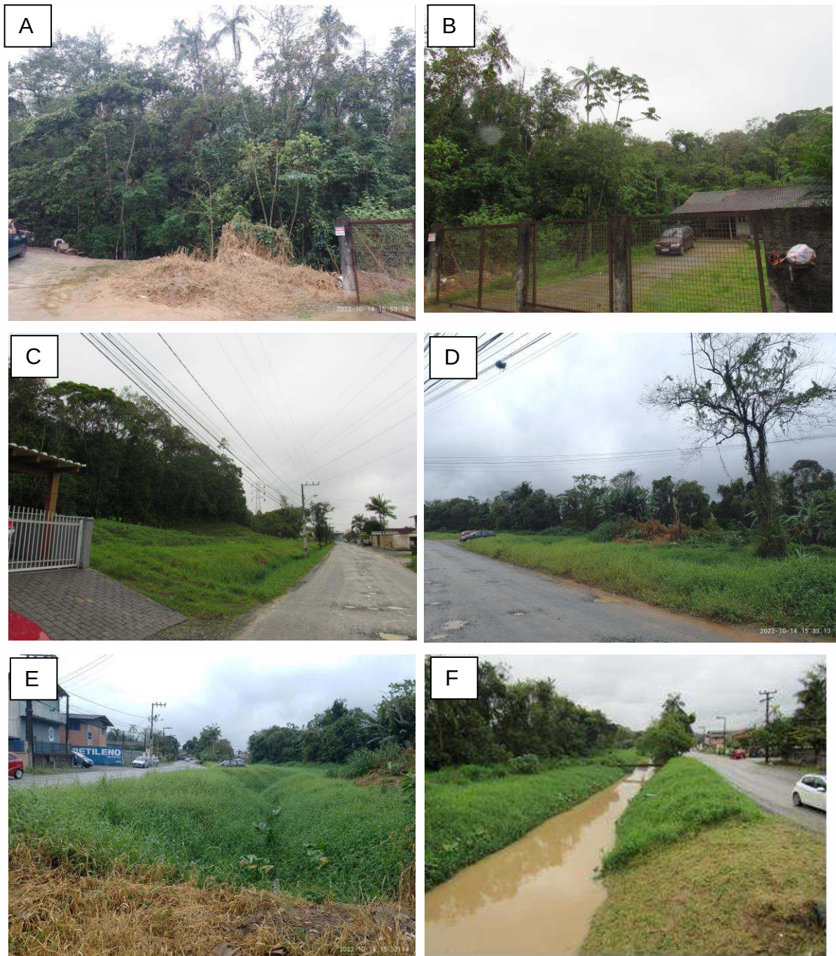
Figura 11: Contexto vegetal da MB 32-5: A) Vista do maciço florestal onde estão nascentes da MB, ao final da rua Santa Marina; B) Vegetação no entorno dos trechos 1C e 03, vista da rua Santa Marina; C) Trecho 10, vista para jusante, a partir do trecho 9 (tubulado); D) Vegetação no entorno do início do Trecho 13, vista para jusante; E) Trecho 13, vista para jusante a partir do trecho 12; F) Rio Águas Vermelhas, vista a partir do trecho 24.
