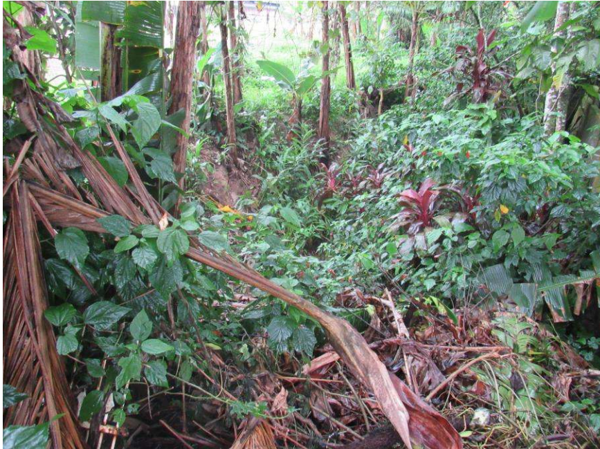
Figura 56: Leito do trecho 23, coberto com vegetação, de difícil visualização.
