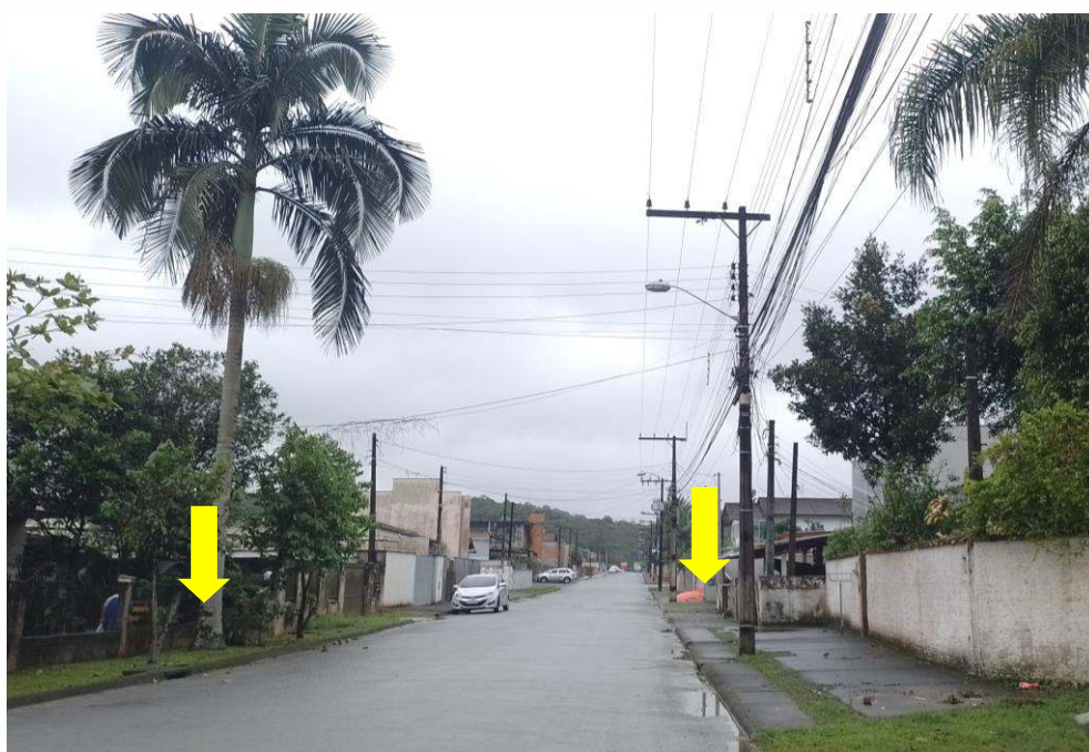
Figura 18: Vista da rua Elario Gastão Baumer com indicação das bocas de lobo. Fonte: Autores.
