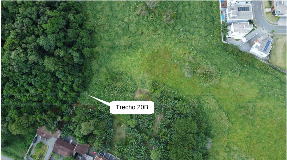
Figura 50: Imagem do entorno do trecho 20B. Fonte: Autores.
