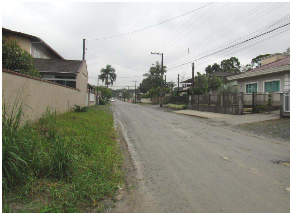
Figura 45: Vista para trecho 9 (fechado sob via) montante, rua Elario Gastão Baumer. Fonte: Autores.
