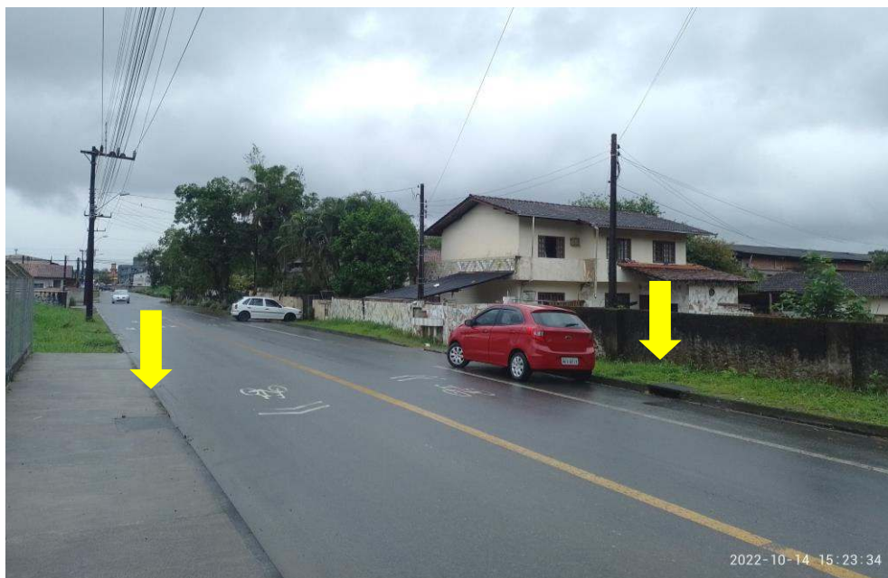
Figura 17: Vista da rua Guilherme Zilmann com indicação das bocas de lobo. Fonte: Autores.
