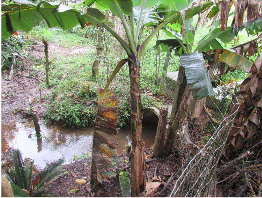
Figura 54: Final do trecho 20C para trecho 21 (tubulado). Fonte: Autores.
