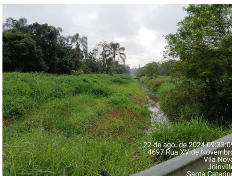
Figura 27: Trecho 27B, vista para montante. Fonte: Autores.
