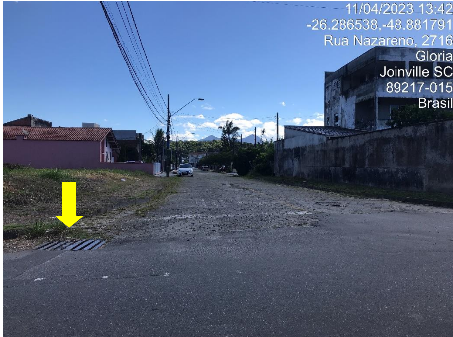
Figura 7: Boca de lobo na rua Nazareno. Fonte: Autores.
