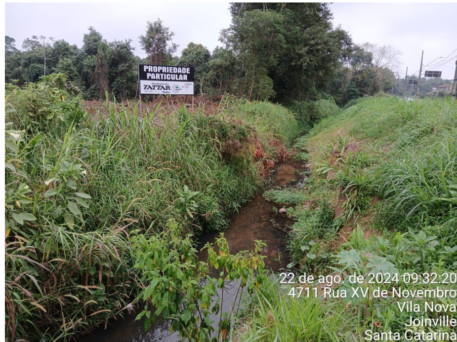
Figura 28: Trecho 29A, vista para jusante. Fonte: Autores.
