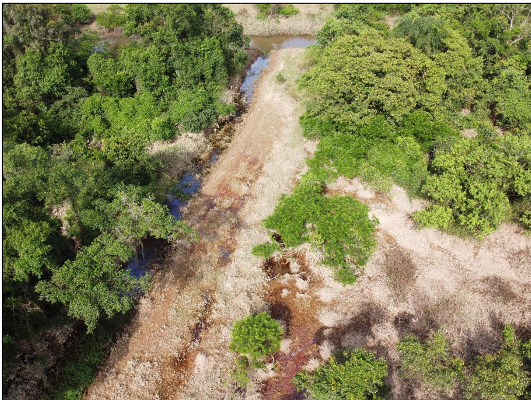
Figura 27 - Parte do trecho 3, com a margem degradada.
