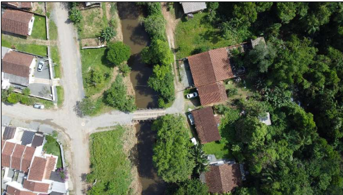
Foto 103 - Vista do Trecho 114b, com residências ocupando a margem direita do rio do Braço.
