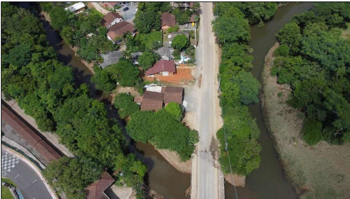
Foto 121 - Trecho 121, chegando no Rio Cubatão, com edificações na margem.
