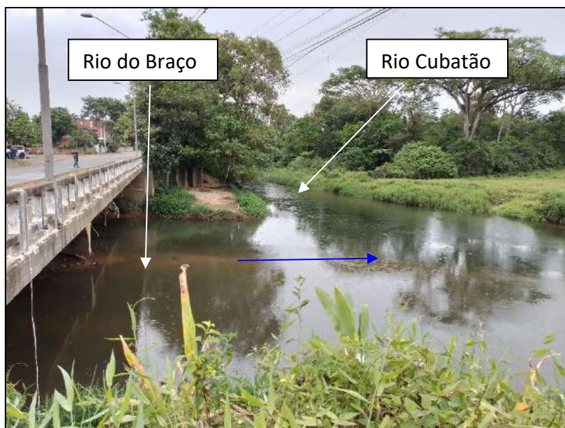
Foto 112 - Trecho final da Microbacia 26-0 (trecho aberto 121, exutório do Rio do Braço no Rio Cubatão (P35).
