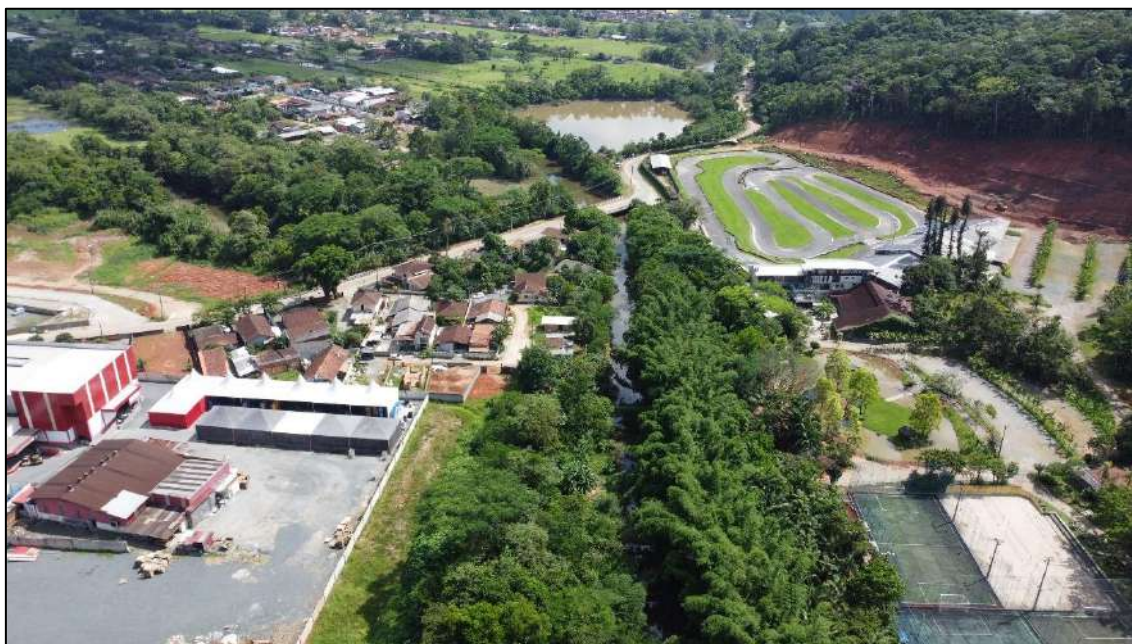
Foto 115 - Vista aérea dos trechos 115 e 121.
