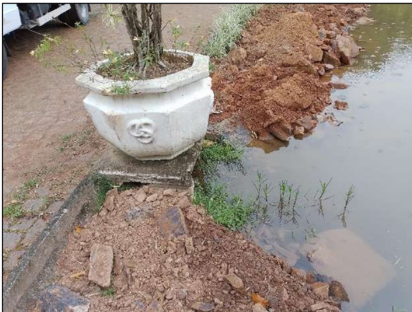
Foto 119 - Caixa extravasora do corpo hídrico do Trecho 119 (reservatório/represamento – P33), dando início ao Trecho 120a, que segue fechado.
