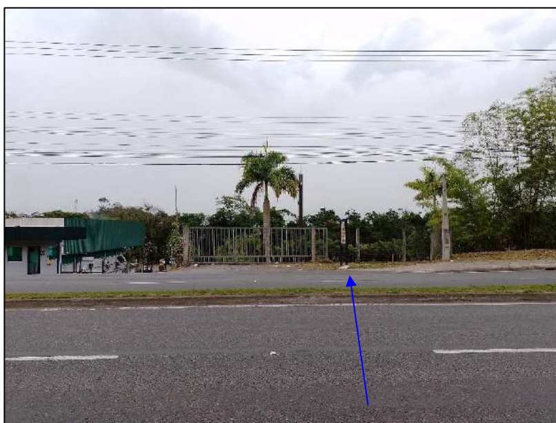
Foto 108 - Região de passagem do trecho fechado 103 sob a Av. Santos Dumont (P32).
