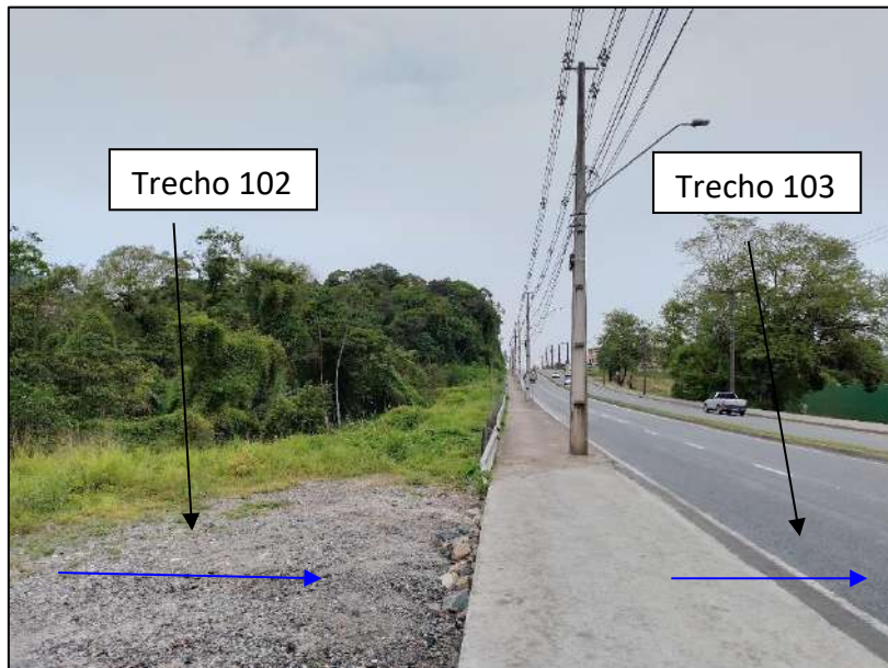
Foto 106 - Região da junção do trecho fechado 102 com o trecho fechado 103 (P32). Nota: necessita de correção da base.
