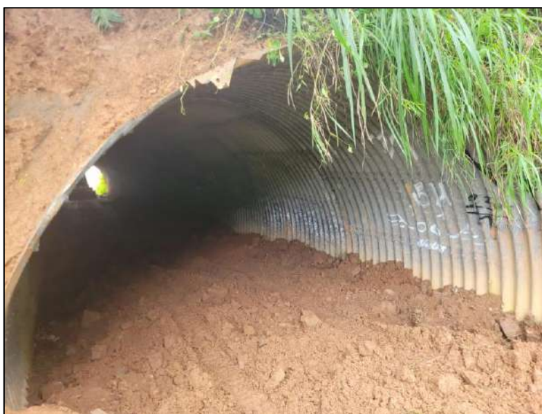
Foto 104 - Tubo metálico, com aproximadamente 3 metros de diâmetro (proximidades do P32).
