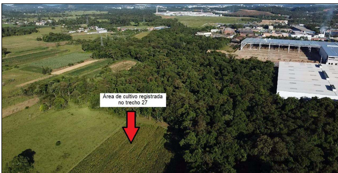
Foto 71 - Registro de área de cultivo existente na margem do trecho 27.
