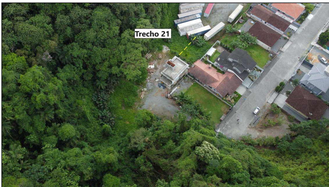
Foto 67 - Trecho fechado sob lote (Trecho 21).
