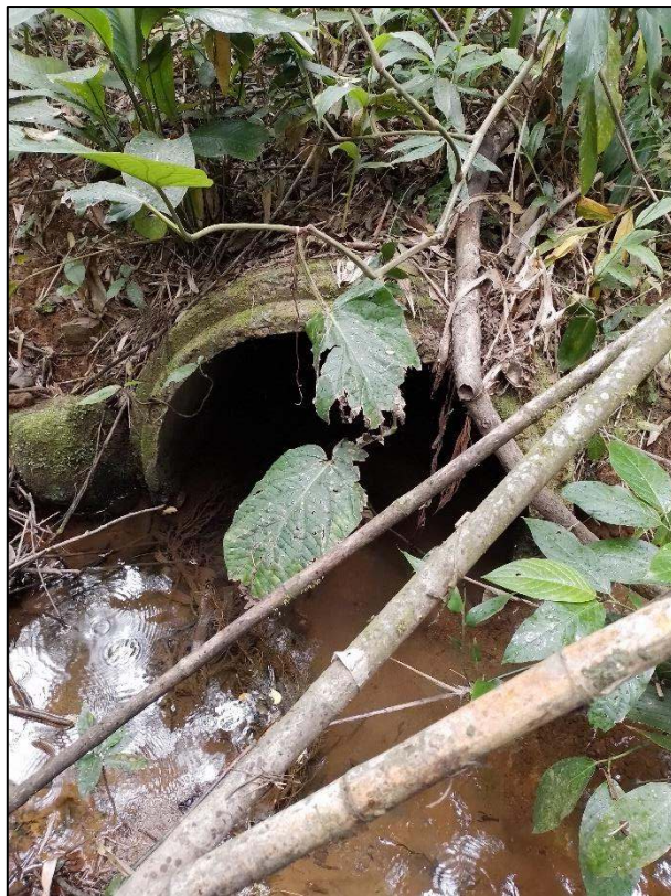
Foto 96 - Ingresso de corpo d'água aberto (Trecho 75) no trecho fechado 76 (P27).
