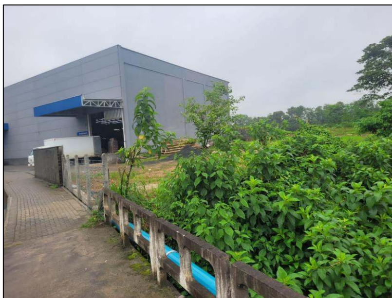
Foto 88 - Ponte atravessando o Rio do Braço entre os trechos 64b e 65a, e ocupação da margem direita.
