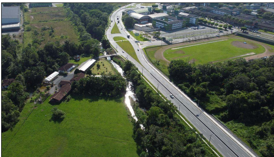
Foto 84 - Trecho da Av. Santos Dumont sobreposto à margem de 30m do Rio do Braço (margem Sul) (trecho 59).
