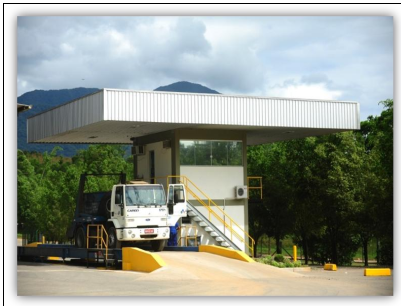
Figura 98 - Controle de recebimento de resíduos (Pesagem) Fonte: Catarinense Engenharia Ambiental S.A (2012)
