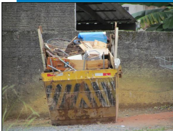
Figura 119 - Resíduos de construção misturados em caçamba
