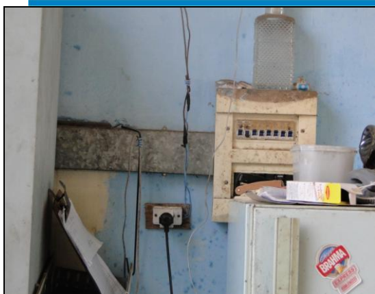
Figura 57 - Fiação improvisada
