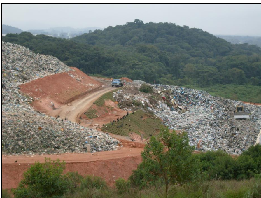
Figura 41 - Foto do aterro sanitário de Joinville - Imagem de 2011 Fonte: Arquivo pessoal – Fábio Elling Schaden
