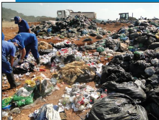
Figura 34 - Separação dos resíduos por tipo de material
