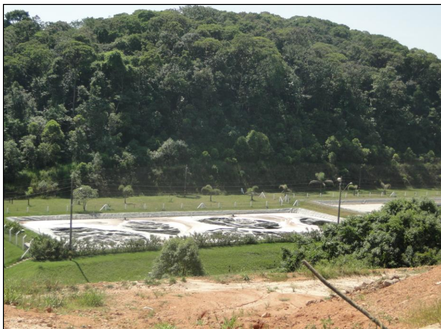
Figura 43 - Sistema de tratamento de percolados no aterro sanitário
