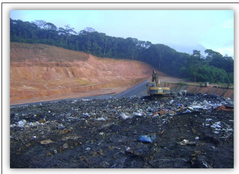
Figura 99 - Aterro de resíduos Classe I Fonte: Catarinense Engenharia Ambiental S.A (2012)
