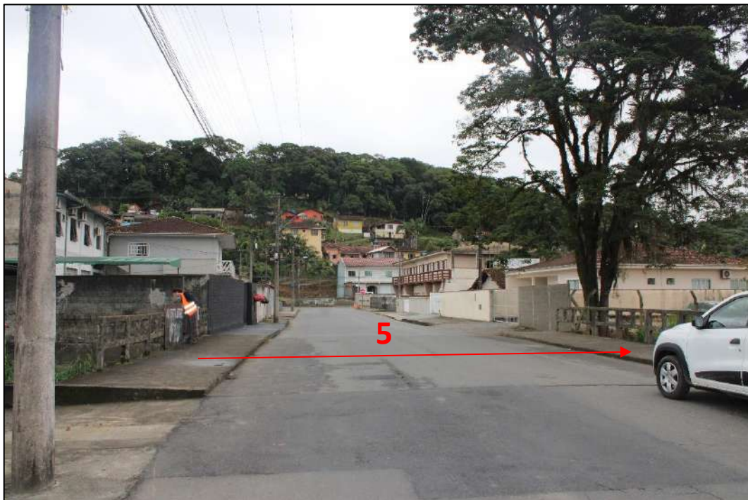
Figura 56: Indicação do trecho 5 (Corpo d'água Tubulado/galeria fechada/via), localizado no Quadrante A . Em vermelho, indicação do sentido do fluxo d'água e nº do trecho. Fonte: vistoria realizada no dia 30/05/2023 pela equipe técnica da Bioeco.
