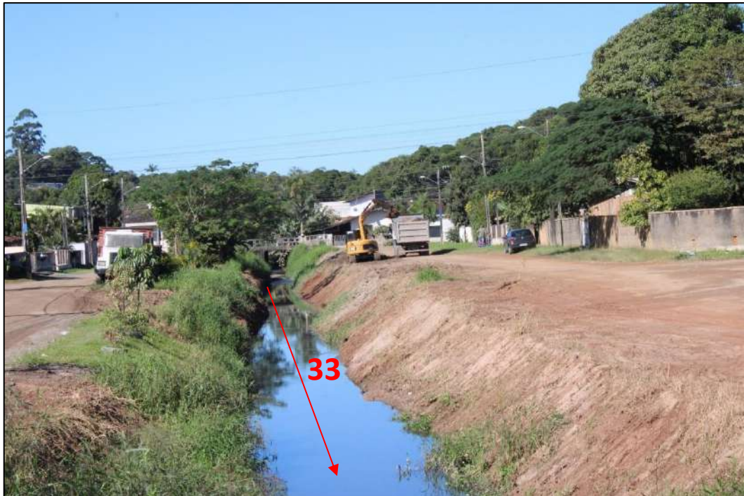
Figura 99: Vista para montante do trecho 33 (Corpo d'água aberto com vegetação isolada em meio antrópico), localizado no Quadrante H . Em vermelho, indicação do sentido do fluxo d'água e nº do trecho. Fonte: vistoria realizada no dia 01/06/2023 pela equipe técnica da Bioeco.
