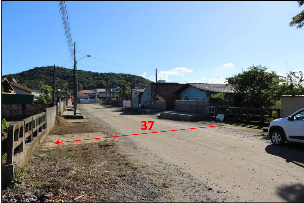
Figura 104: Indicação do trecho 37 (Corpo d'água Tubulado/galeria fechada/via), localizado no Quadrante I . Em vermelho, indicação do sentido do fluxo d'água e nº do trecho. Fonte: vistoria realizada no dia 01/06/2023 pela equipe técnica da Bioeco.
