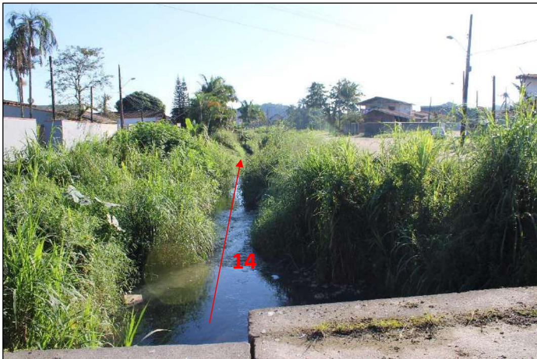
Figura 75: Vista para jusante do trecho 14 (Corpo d'água aberto com vegetação isolada em meio antrópico), localizado no Quadrante D . Em vermelho, indicação do sentido do fluxo d'água e nº do trecho. Fonte: vistoria realizada no dia 01/06/2023 pela equipe técnica da Bioeco.
