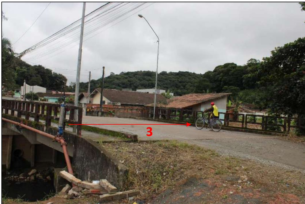
Figura 54: Indicação do trecho 3 (Corpo d'água Tubulado/galeria fechada/via), localizado no Quadrante A . Em vermelho, indicação do sentido do fluxo d'água e nº do trecho. Fonte: vistoria realizada no dia 30/05/2023 pela equipe técnica da Bioeco.
