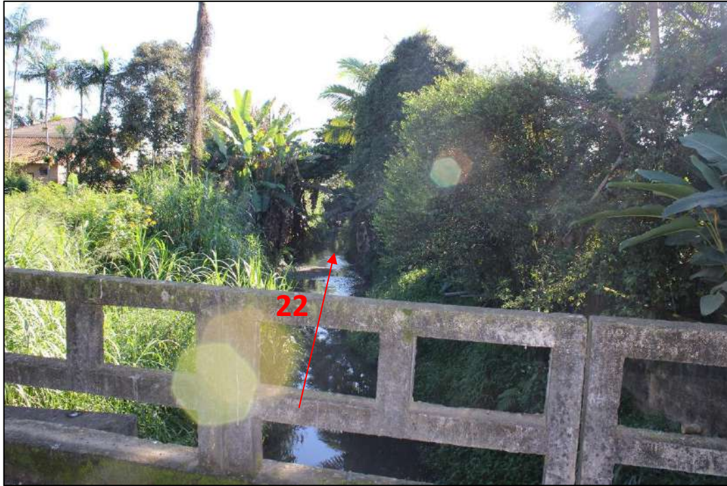
Figura 85: Vista para Jusante do trecho 22 (Corpo d'água aberto com vegetação isolada em meio antrópico), localizado no Quadrante G . Em vermelho, indicação do sentido do fluxo d'água e nº do trecho. Fonte: vistoria realizada no dia 01/06/2023 pela equipe técnica da Bioeco.
