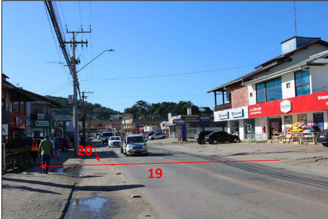
Figura 82: Indicação dos trechos 19 e 20 (Corpo d'água Tubulado/galeria fechada/via), localizado no Quadrante F . Em vermelho, indicação do sentido do fluxo d'água e nº do trecho. Fonte: vistoria realizada no dia 01/06/2023 pela equipe técnica da Bioeco.
