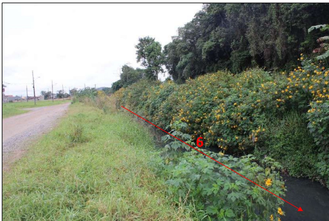
Figura 62: Vista para montante do trecho 6 (Corpo d'água aberto com vegetação isolada em meio antrópico), localizado no Quadrante B . Em vermelho, indicação do sentido do fluxo d'água e nº do trecho. Fonte: vistoria realizada no dia 30/05/2023 pela equipe técnica da Bioeco.
