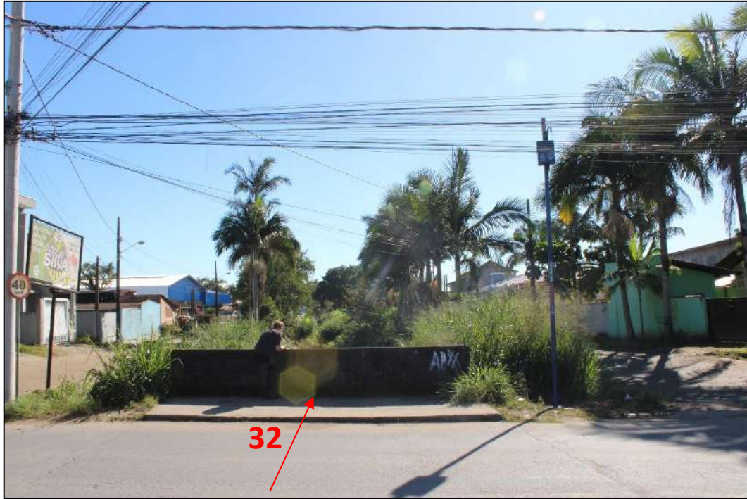
Figura 98: Indicação do trecho 32 (Corpo d'água Tubulado/galeria fechada/via), localizado no Quadrante H . Em vermelho, indicação do sentido do fluxo d'água e nº do trecho. Fonte: vistoria realizada no dia 01/06/2023 pela equipe técnica da Bioeco.
