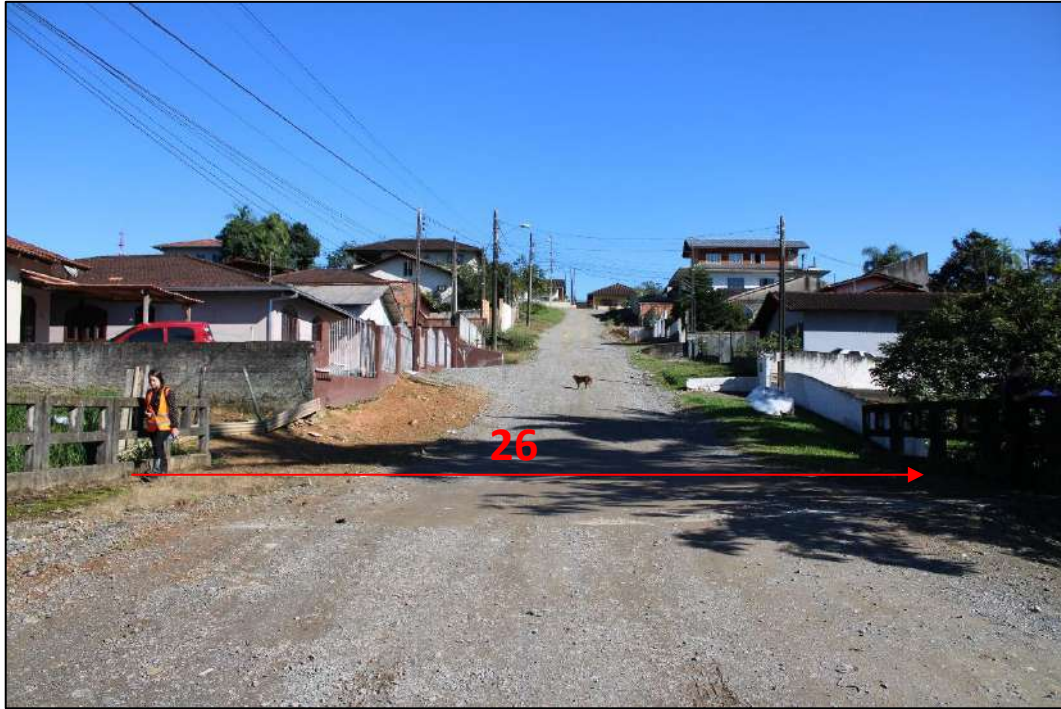
Figura 89: Indicação do trecho 26 (Corpo d'água Tubulado/galeria fechada/via), localizado no Quadrante G . Em vermelho, indicação do sentido do fluxo d'água e nº do trecho. Fonte: vistoria realizada no dia 01/06/2023 pela equipe técnica da Bioeco.
