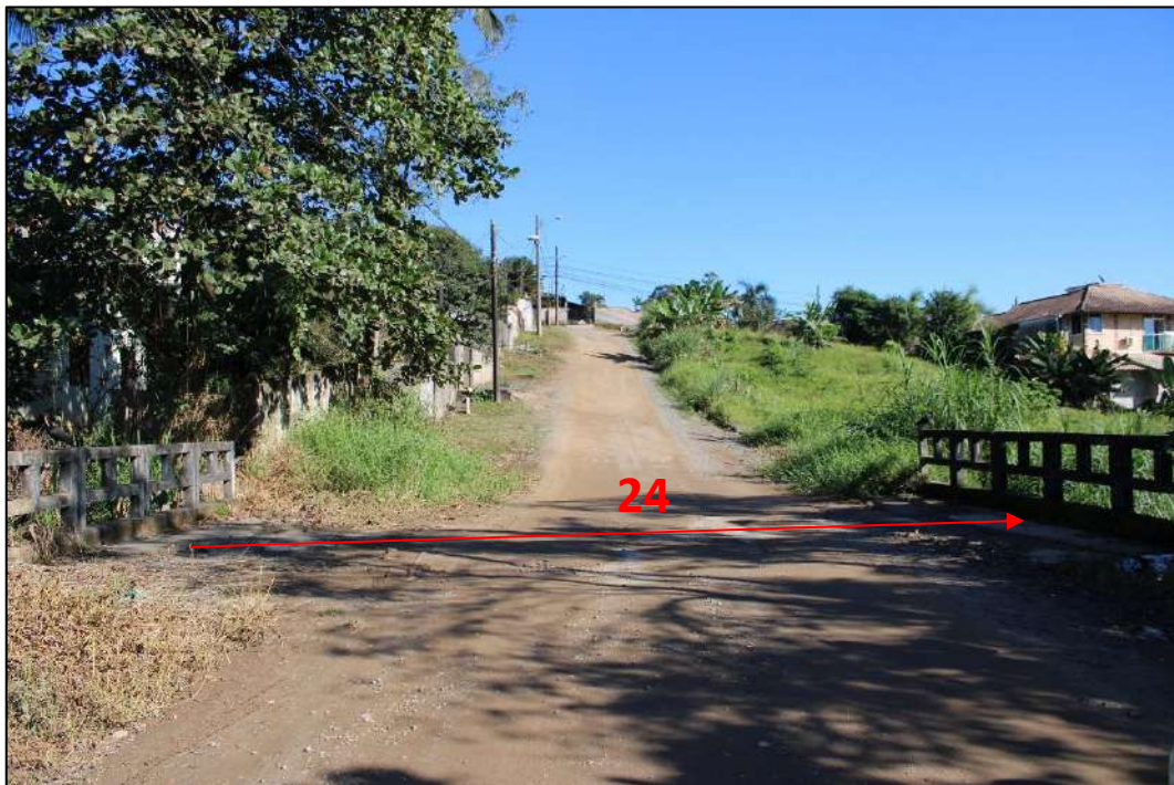
Figura 86: Indicação do trecho 24 (Corpo d'água Tubulado/galeria fechada/via), localizado no Quadrante G . Em vermelho, indicação do sentido do fluxo d'água e nº do trecho. Fonte: vistoria realizada no dia 01/06/2023 pela equipe técnica da Bioeco.
