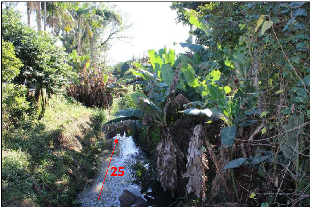
Figura 88: Vista para jusante do trecho 25 (Corpo d'água aberto com vegetação isolada em meio antrópico), localizado no Quadrante G . Em vermelho, indicação do sentido do fluxo d'água e nº do trecho. Fonte: vistoria realizada no dia 01/06/2023 pela equipe técnica da Bioeco.
