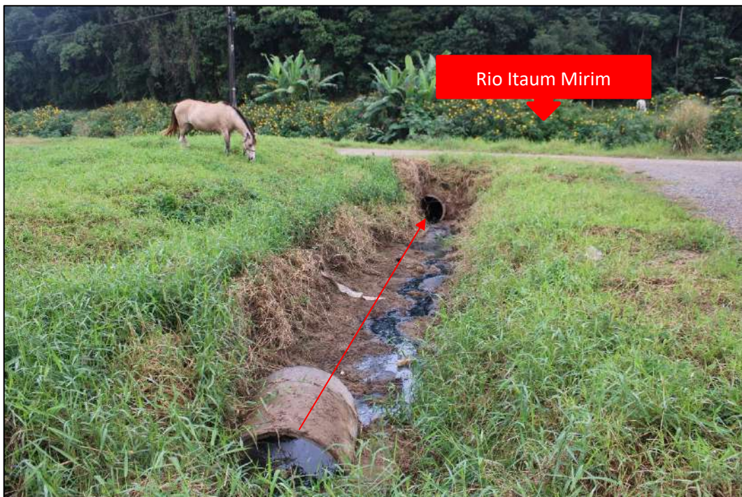
Figura 68: Efluente doméstico em vala de drenagem que desemboca em corpo hídrico (Rio Itaum Mirim) (Trecho 6). Fonte: vistoria realizada no dia 30/05/2023 pela equipe técnica da Bioeco.
