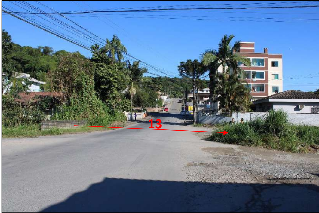
Figura 74: Indicação do trecho 13 (Corpo d'água Tubulado/galeria fechada/via), localizado no Quadrante D . Em vermelho, indicação do sentido do fluxo d'água e nº do trecho. Fonte: vistoria realizada no dia 01/06/2023 pela equipe técnica da Bioeco.
