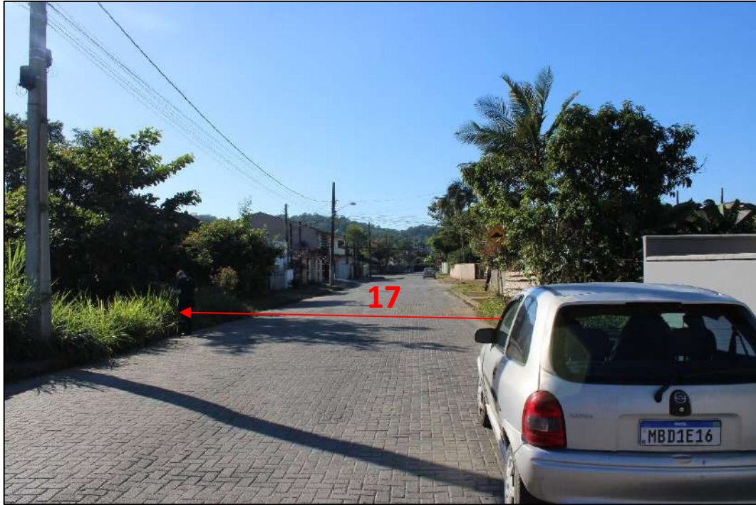
Figura 79: Indicação do trecho 17 (Corpo d'água tubulado/galeria fechada/via), localizado no Quadrante E . Em vermelho, indicação do sentido do fluxo d'água e nº do trecho. Fonte: vistoria realizada no dia 01/06/2023 pela equipe técnica da Bioeco.
