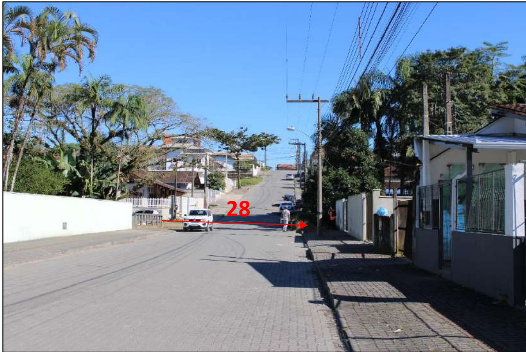
Figura 92: Indicação do trecho 28 (Corpo d'água Tubulado/galeria fechada/via), localizado no Quadrante H . Em vermelho, indicação do sentido do fluxo d'água e nº do trecho. Fonte: vistoria realizada no dia 01/06/2023 pela equipe técnica da Bioeco.
