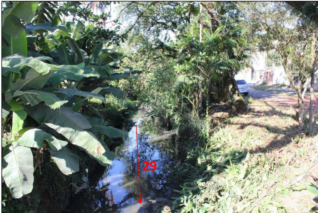
Figura 93: Vista para montante do trecho 29 (Corpo d'água aberto com vegetação isolada em meio antrópico), localizado no Quadrante H . Em vermelho, indicação do sentido do fluxo d'água e nº do trecho. Fonte: vistoria realizada no dia 01/06/2023 pela equipe técnica da Bioeco.
