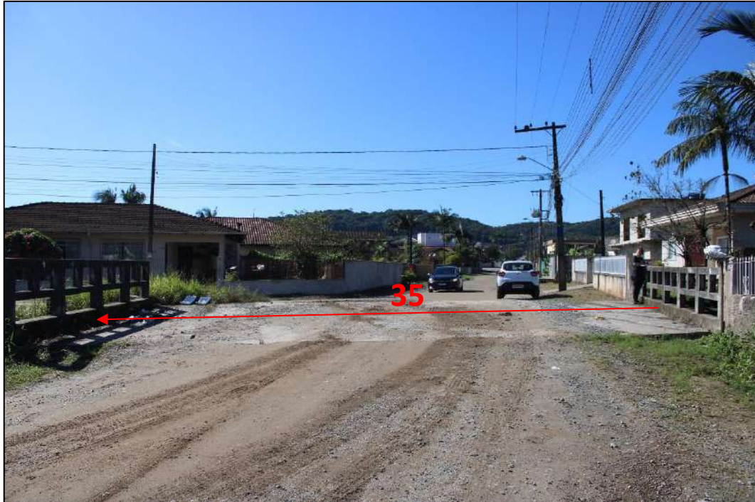
Figura 102: Indicação do trecho 35 (Corpo d'água Tubulado/galeria fechada/via), localizado no Quadrante I . Em vermelho, indicação do sentido do fluxo d'água e nº do trecho. Fonte: vistoria realizada no dia 01/06/2023 pela equipe técnica da Bioeco.
