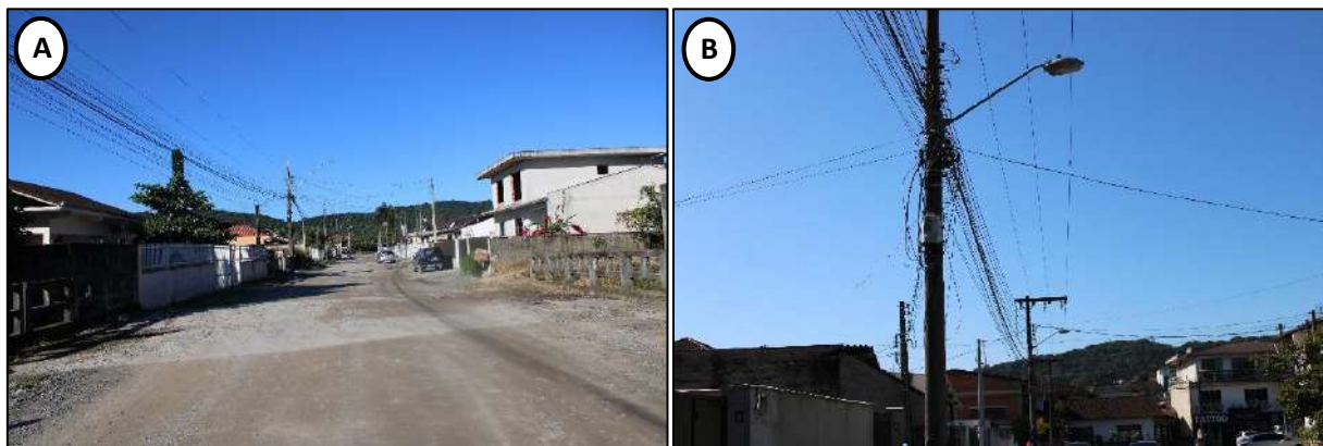
Figura 32: Postes e fiação elétrica presentes na área de estudo. Legenda: A – Rua Tenente Ayres Zacarias; B – Rua Constantino Caetano). Fonte: vistoria realizada no dia 01/06/2023 pela equipe técnica da Bioeco.
