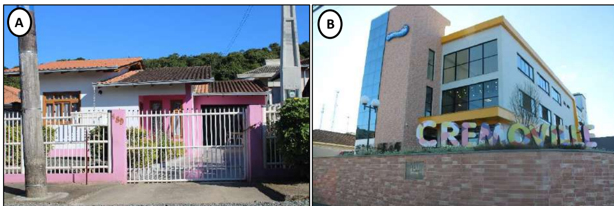
Figura 44: Residência e Comércio localizados na área de estudo. Legenda: A – Rua Walfrido de Lima; B – Rua Afonso Moreira. Fonte: vistoria realizada no dia 01/06/2023 pela equipe técnica da Bioeco.
