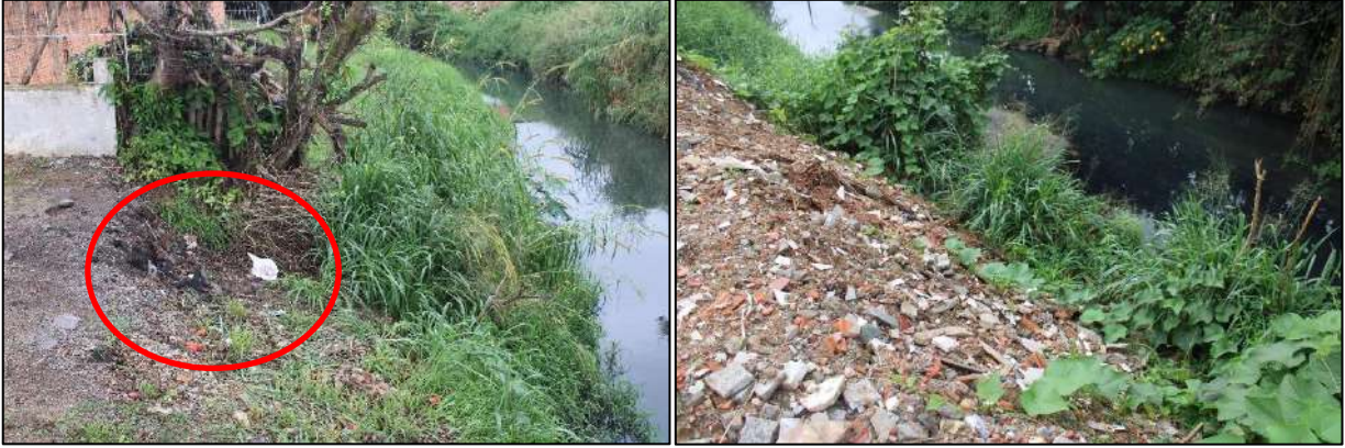
Figura 59: Despejo de resíduos em APP de corpo d'água (Trecho 2). Fonte: vistoria realizada no dia 30/05/2023 pela equipe técnica da Bioeco.
