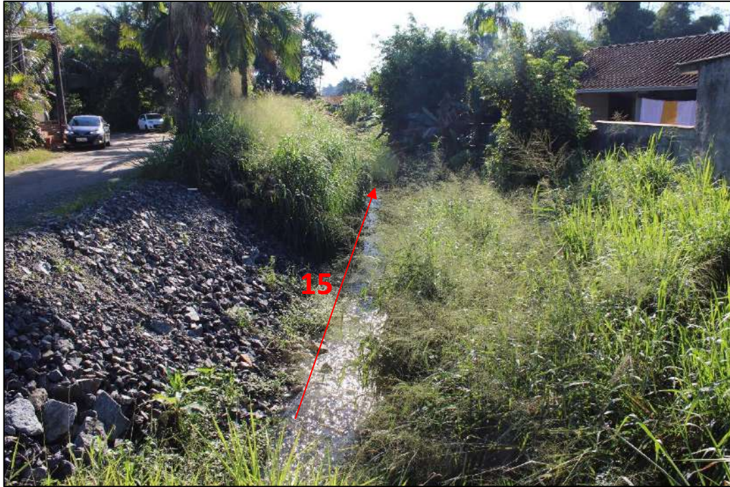
Figura 77: Vista para jusante do trecho 15 (Corpo d'água aberto com vegetação isolada em meio antrópico), localizado no Quadrante E . Em vermelho, indicação do sentido do fluxo d'água e nº do trecho. Fonte: vistoria realizada no dia 01/06/2023 pela equipe técnica da Bioeco.
