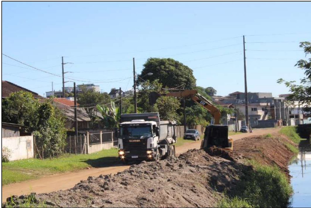
Figura 100: Serviços de Manutenção de canal do rio Itaum Mirim (Trecho 33). Fonte: vistoria realizada no dia 01/06/2023 pela equipe técnica da Bioeco.
