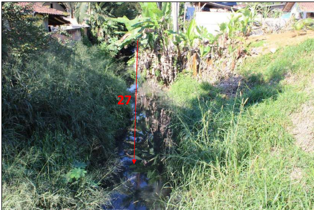
Figura 90: Vista para montante do trecho 27 (Corpo d'água aberto com vegetação isolada em meio antrópico), localizado no Quadrante G . Em vermelho, indicação do sentido do fluxo d'água e nº do trecho. Fonte: vistoria realizada no dia 01/06/2023 pela equipe técnica da Bioeco.
