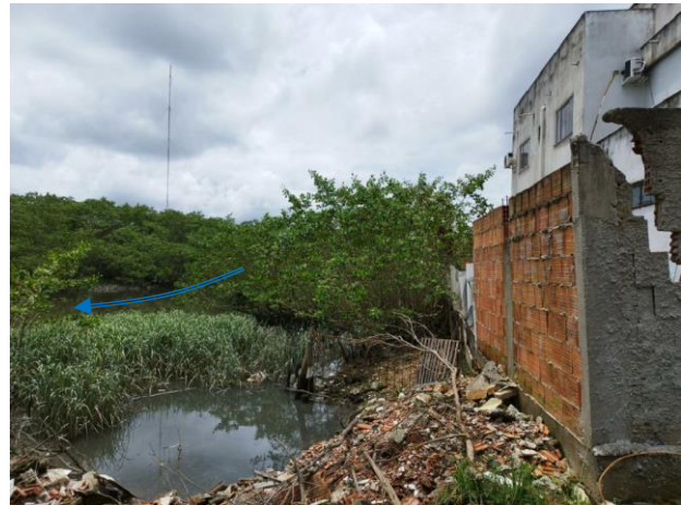
Figura 52 (TR21): Vista para ocupação urbana de vegetação de mangue nas faixas marginais do trecho 35 – aberto misto (mangue/meio antropizado).
