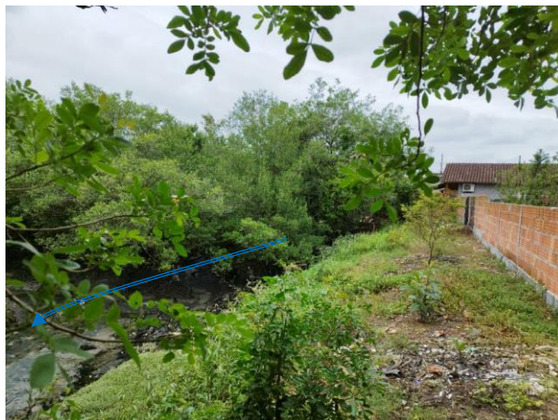
Figura 39 (TR15): Vista para ocupação urbana nas faixas marginais ao trecho 15 – aberto misto (mangue/meio antropizado).
