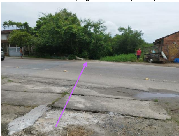
Figura 36 (TR13): Vista para ocupação urbana nas faixas marginais ao trecho 11 – fechado sob via pública.
