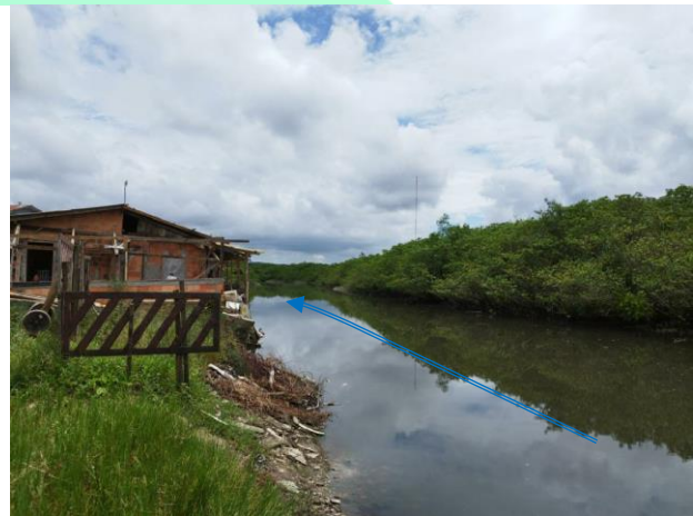
Figura 50 (TR19): Vista para ocupação urbana de vegetação de mangue nas faixas marginais do trecho 35 – aberto misto (mangue/meio antropizado).
