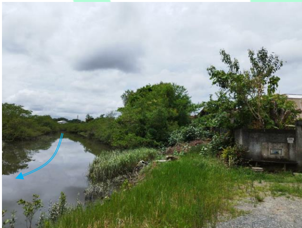
Figura 49 (TR19): Vista para ocupação urbana de vegetação de mangue nas faixas marginais do trecho 34 – aberto misto (mangue/meio antropizado).
