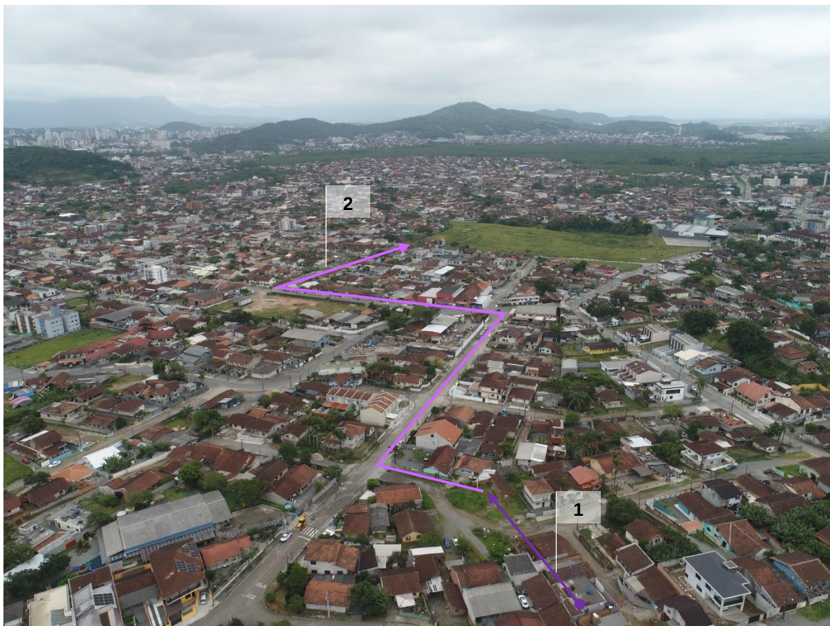
Figura 12 (AR01): Vista aérea para ocupação urbana das faixas marginais aos corpos d'água do quadrante A, trecho fechado em meio antropizado (1) e trecho fechado sob via pública (2).
