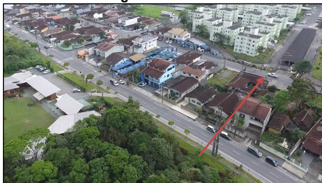
Figura 46 - Localização em campo dos trechos 13 e 14, evidenciando a localização do corpo d'água tubulado.
