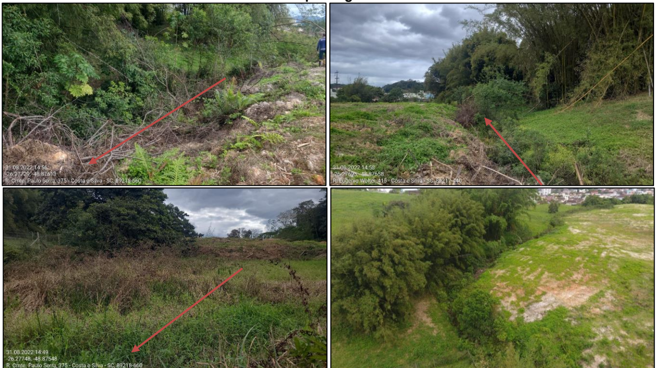
Figura 27 - Aspecto geral dos trechos 15A, 15B e 16 evidenciando a vegetação isolada na margem do corpo d'água.
