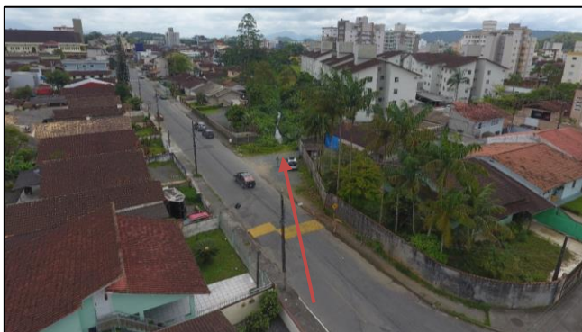
Figura 45 - Localização em campo do trecho 9H, evidenciando a localização do corpo d'água tubulado.
