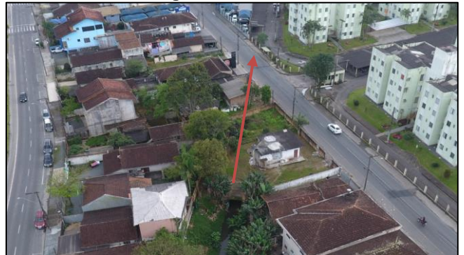
Figura 42 - Localização em campo dos trechos 9A e 9B, evidenciando a localização do corpo d'água tubulado.
