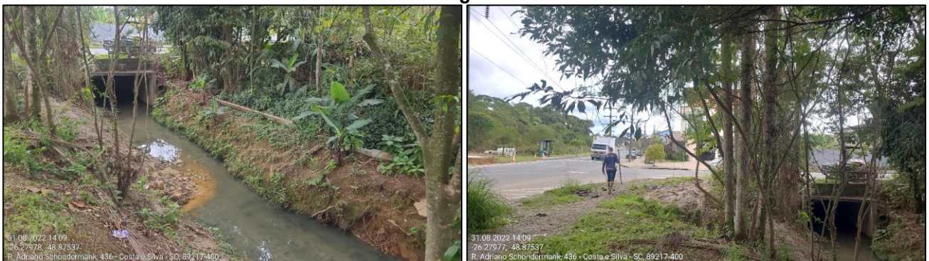
Figura 25 - Aspecto geral dos trechos 8A e 8B, evidenciando a vegetação isolada na margem do corpo d'água.
