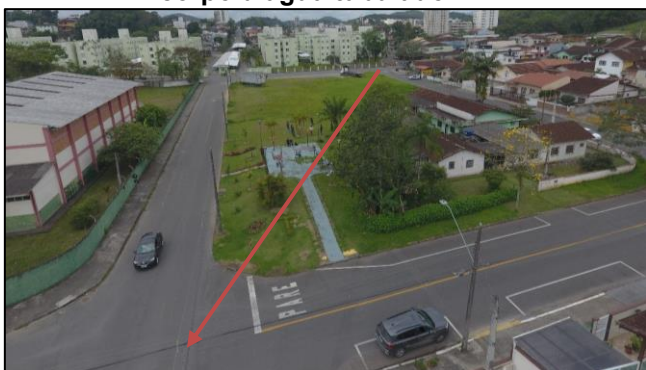
Figura 44 - Localização em campo dos trechos 9E, 9F e 9G, evidenciando a localização do corpo d'água tubulado.
