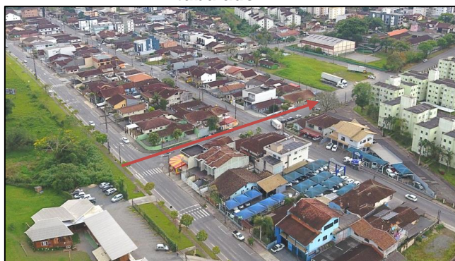
Figura 47 - Localização em campo do trecho 18, evidenciando a localização do corpo d'água tubulado.
