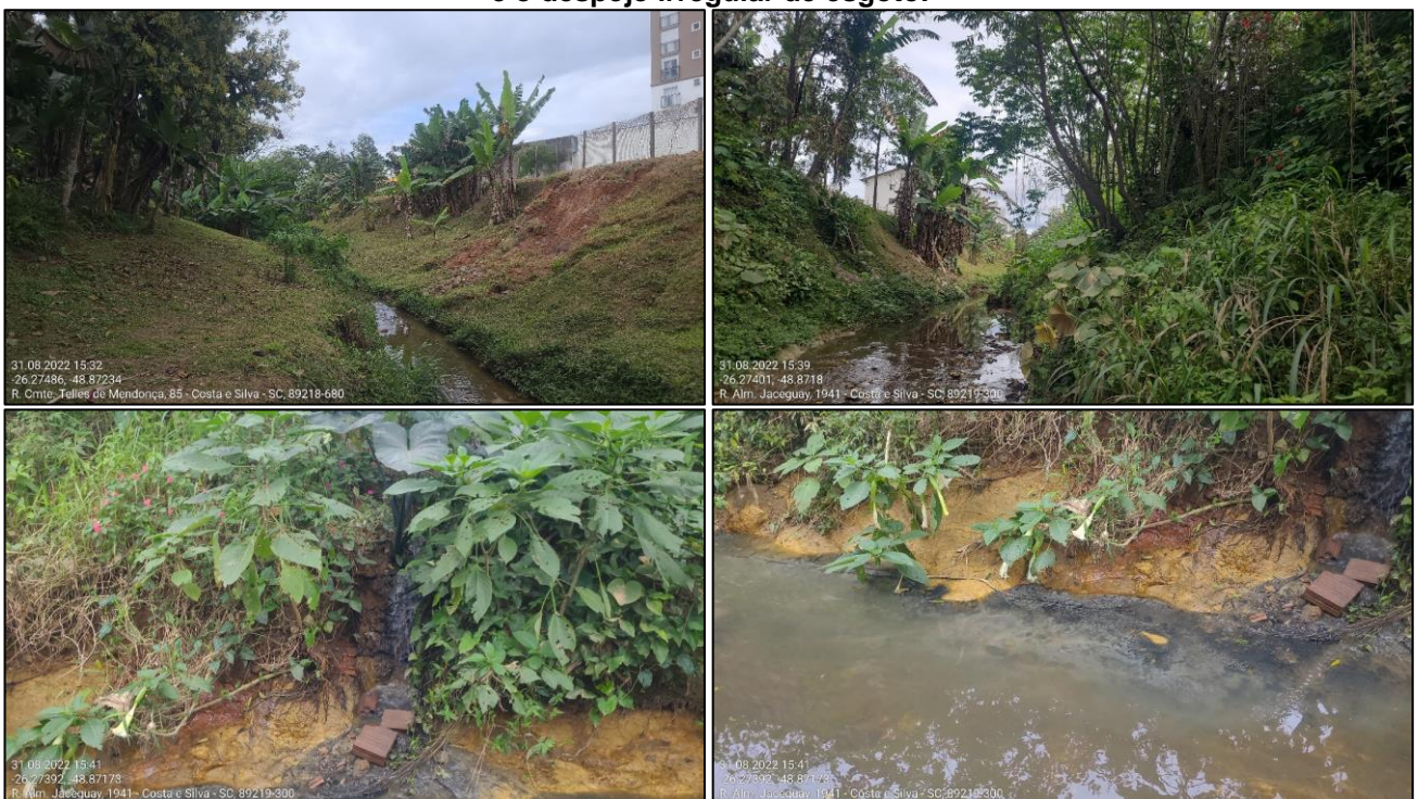
Figura 29 - Aspecto geral do trecho 19, evidenciando a vegetação isolada na margem do corpo d'água e o despejo irregular de esgoto.
