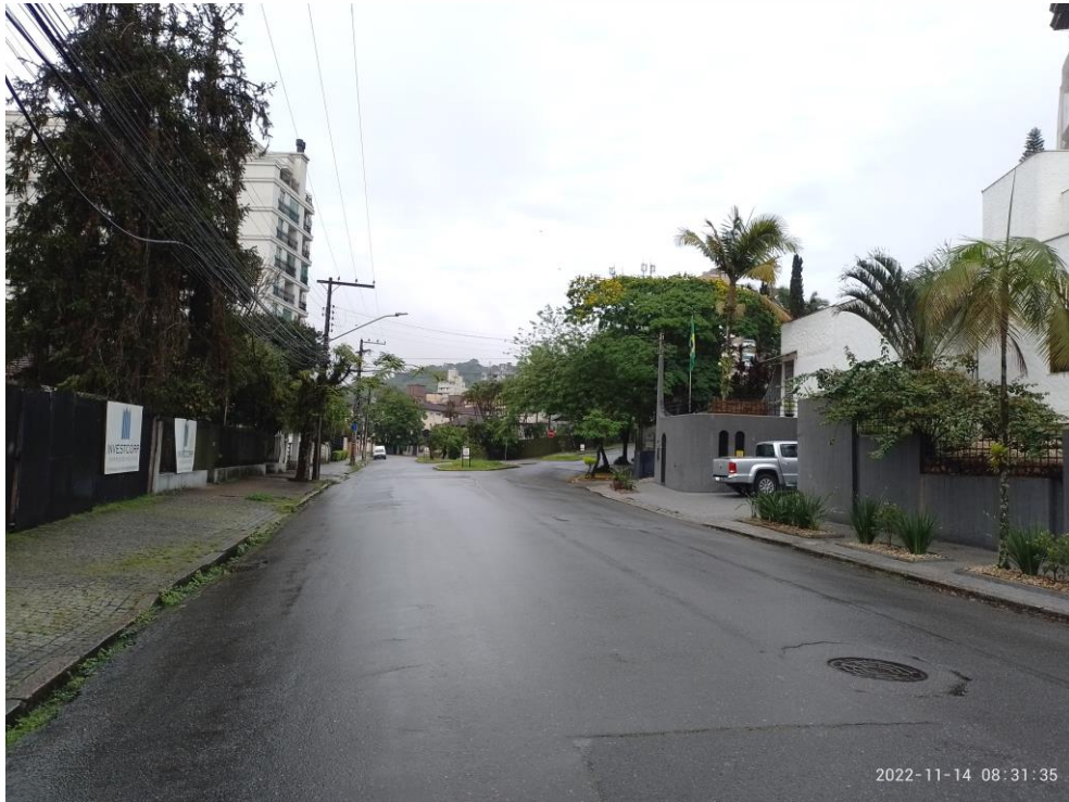
Figura 23: Rua Desembargador Nelson Nunes Guimarães, trecho 5, vista para montante. Fonte: Autores.
