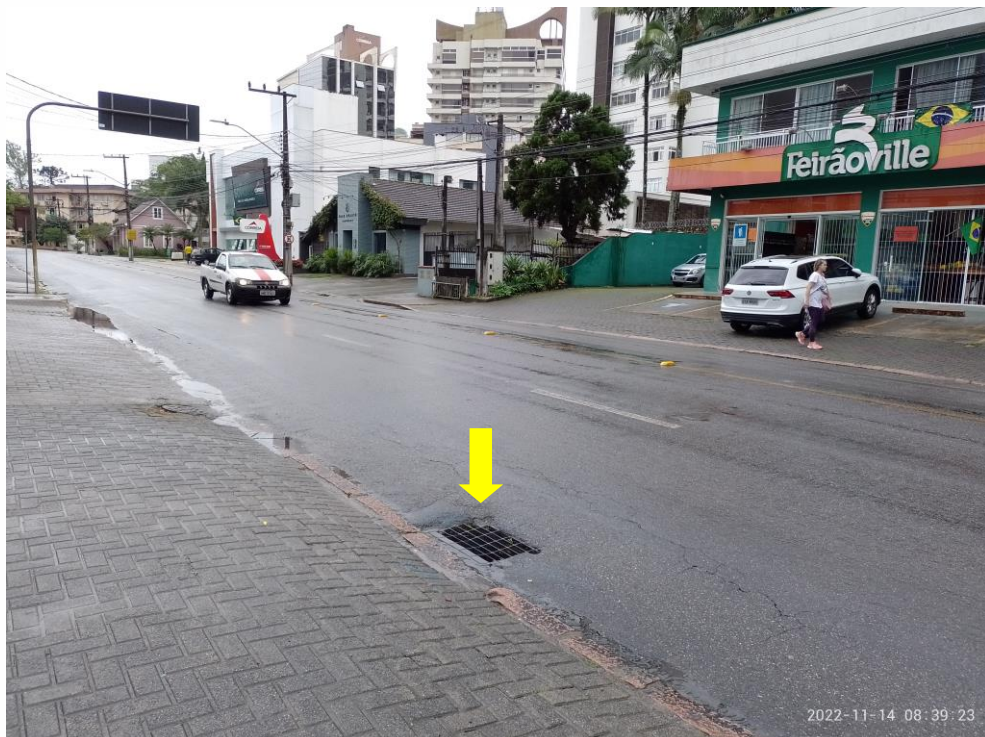
Figura 7: Vista da rua Expedicionário Holz com indicação da boca de lobo. Fonte: Autores.
