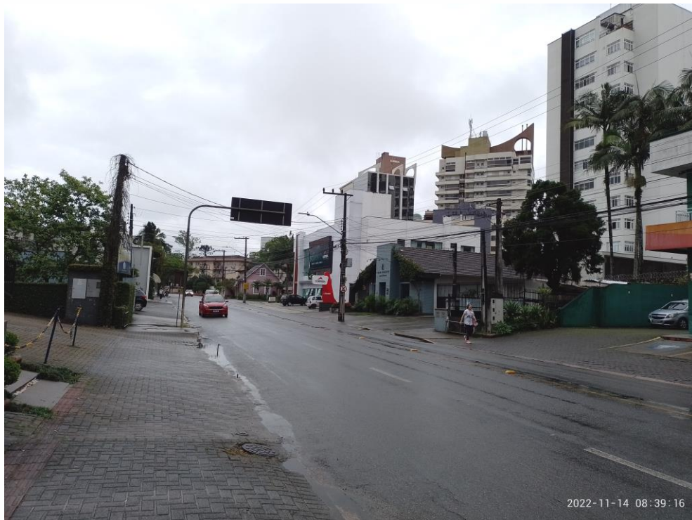
Figura 25: Rua Expedicionário Holz, trecho 7, vista para montante. Fonte: Autores.
