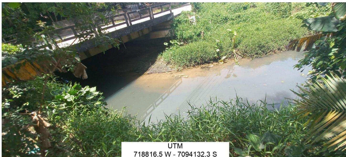
Figura 37: trecho 24 - curso d'água fechado sob ponte
