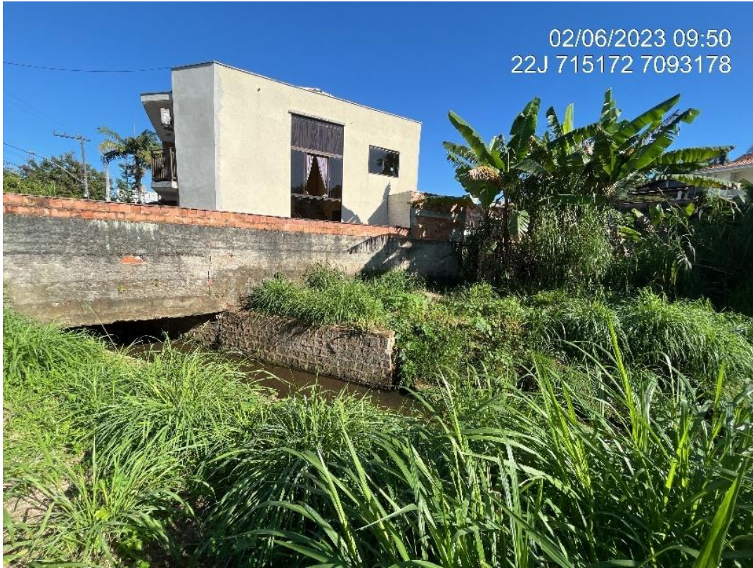
Figura 28: Trecho 28, vista para jusante. Fonte: Autores.
