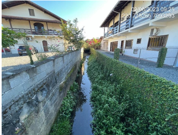
Figura 22: Trecho 19, vista para montante a partir da rua Avaí. Fonte: Autores.
