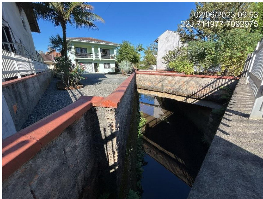
Figura 30: Trecho 40, vista para jusante. Fonte: Autores.
