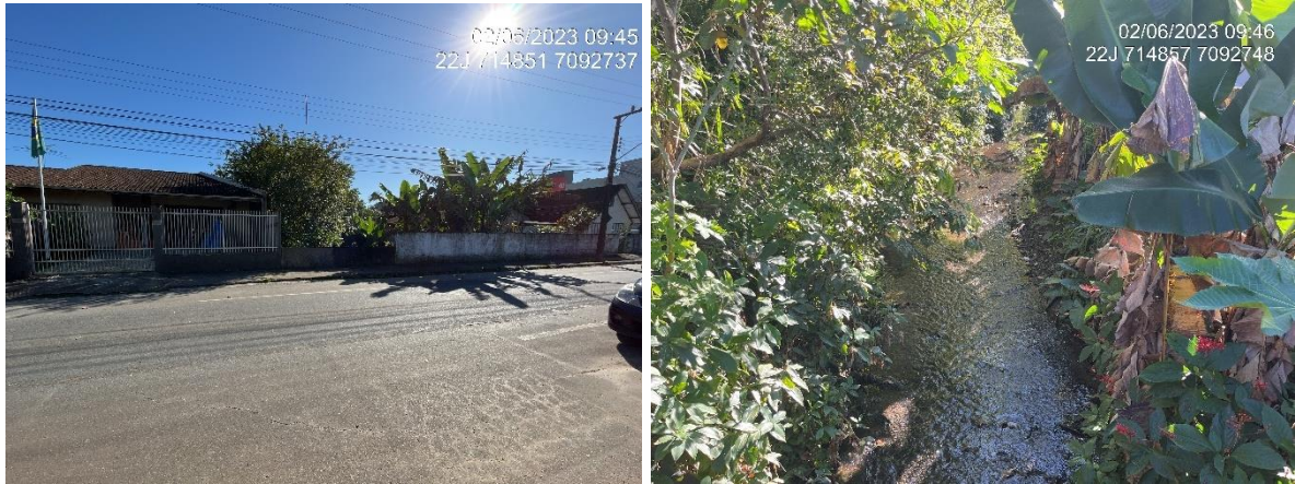
Figura 31: Trecho 40, vista para montante, a partir do trecho 41 (esq.) e detalhe do trecho 40 (dir.) Fonte Autores.
