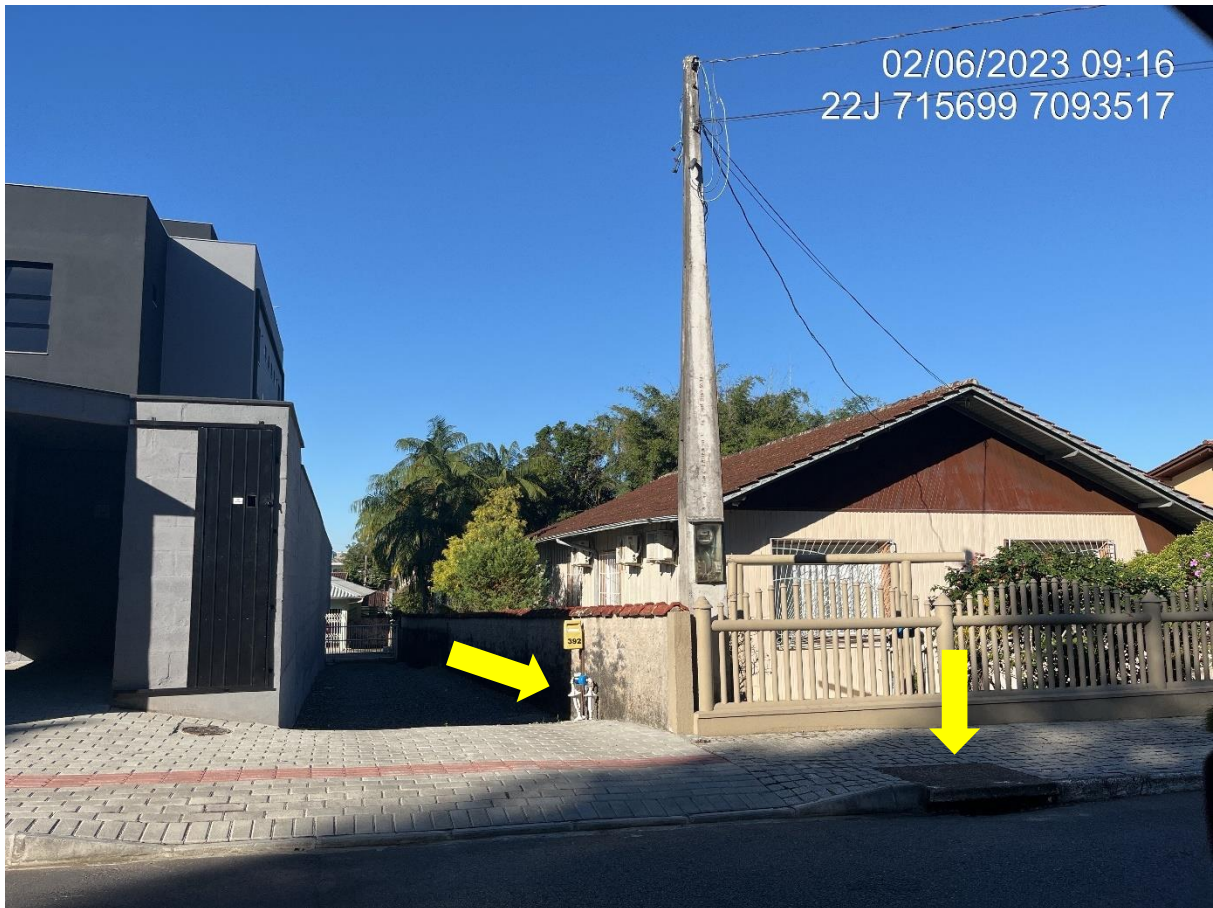
Figura 10: Rua Riachuelo, pavimentada. Observa-se rede de distribuição de energia elétrica, boca de lobo para coleta de água pluvial e registros de água. Fonte: Autores.
