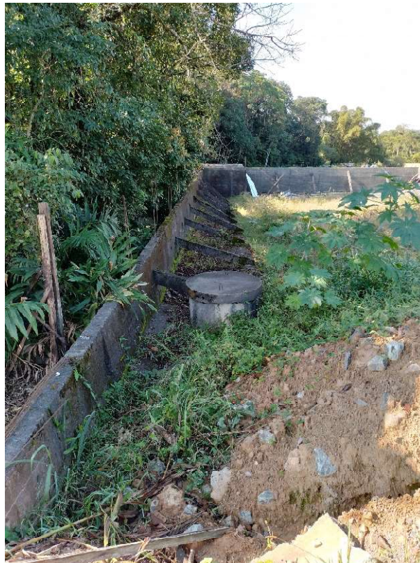
Foto 36 - Caixa de passagem hídrica próxima ao P16, por onde o Trecho 25 corre tubulado.
