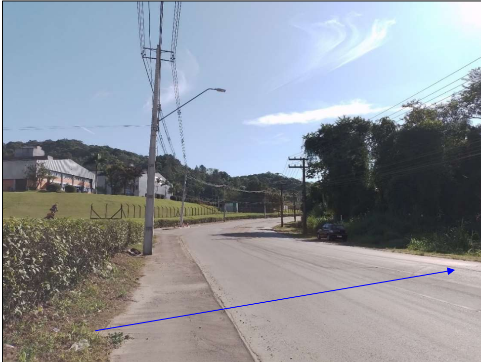
Foto 25 - Trecho fechado 20c (sob Rua Dona Francisca - entre P5 e P6). Nota: necessita de correção da base.
