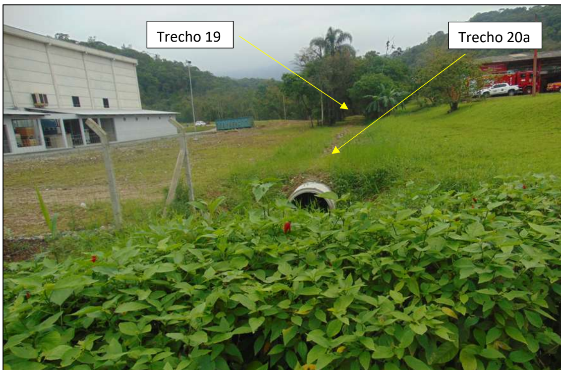
Foto 22 - Vista para o trecho fechado 19 a partir do P5. Nota: Percebe-se a presença da edificação dos Bombeiros Voluntários de Joinville, ao lado do Trecho 19.
