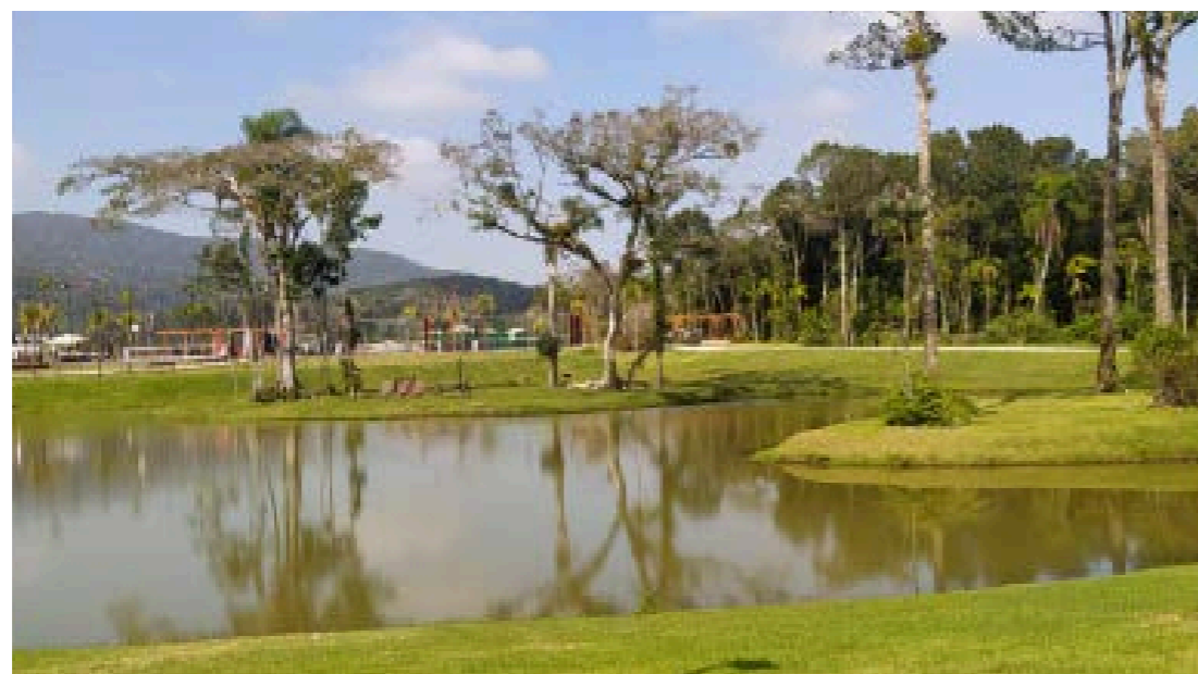
Figura 30 - Lagoas de contenção
