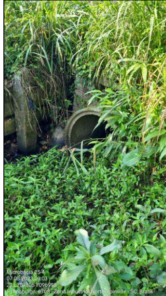
Figura 34: Início do trecho 2 (tubulado sob via). Fonte: Autor, 2023.
