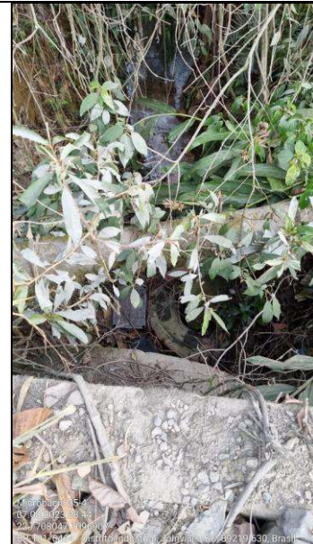
Figura 36: Fim do trecho 4 (aberto), início do trecho 5 (fechado). Fonte: Autor, 2023.
