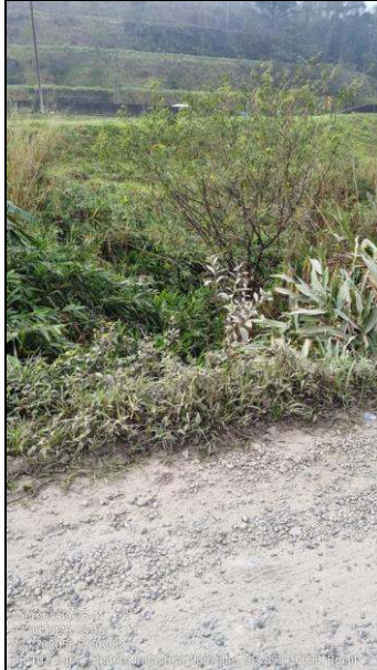
Figura 37: Fim do trecho 5 (fechado), início do trecho 6 (aberto). Fonte: Autor, 2023.
