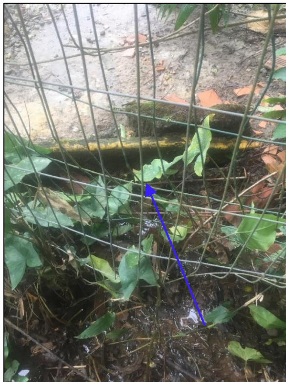
Foto 16 - Junção do Trecho 1 (aberto em vegetação densa) com a tubulação do Trecho 2a (fechado entre lotes). Nota: a partir desse ponto todo o restante dos trechos da microbacia estão fechados.
