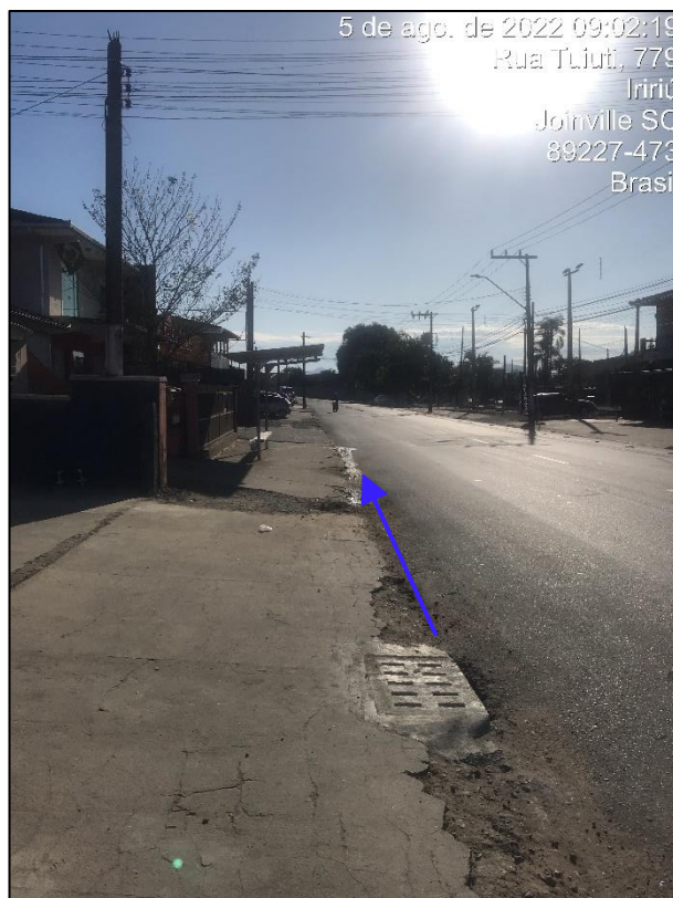
Foto 19 - Trecho 4 fechado sob a Rua Tuiuti.
