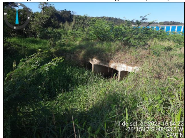
Figura 24: (R9) Vista para o trecho 43 com destaque para o início da galeria fechada (Fonte: Carbono Engenharia, 2023).
