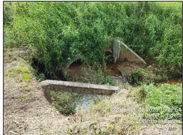
Figura 36: (R16) Vista para trecho 58 com destaque para a saída da tubulação (Fonte: Carbono Engenharia, 2023).
