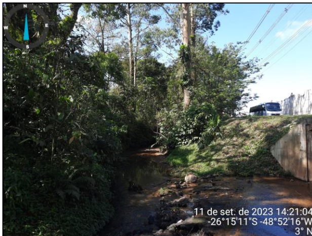
Figura 43 – (R21) Vista para o trecho 61 com destaque para a proximidade da via ao corpo hídrico (Fonte: Carbono Engenharia, 2023).
