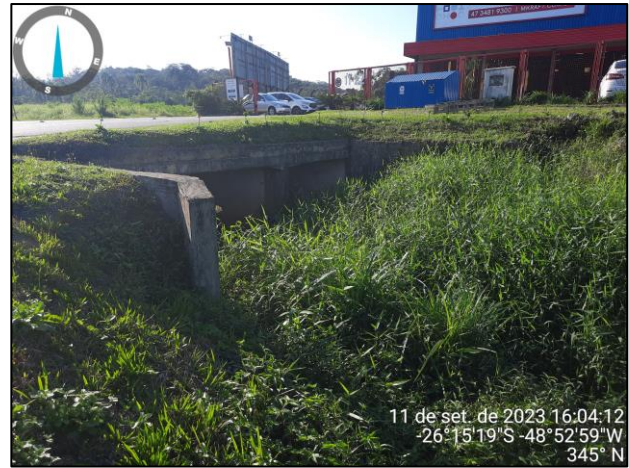
Figura 28 – (R12) Vista para o trecho 45 com destaque para a saída da galeria fechada (Fonte: Carbono Engenharia, 2023).
