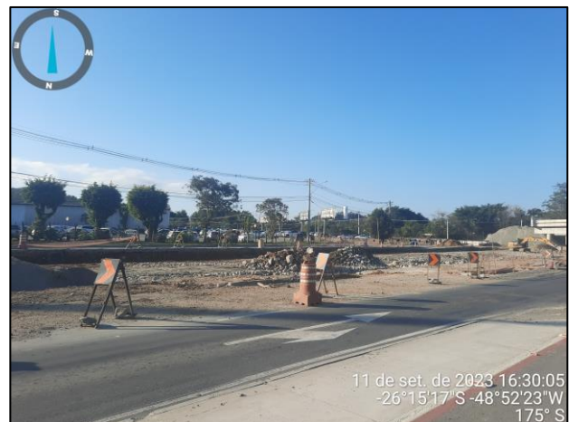
Figura 40: (R19) Vista para o trecho 60 com destaque para as obras do elevador que estão ocorrendo sobre o trecho (Fonte: Carbono Engenharia, 2023).
