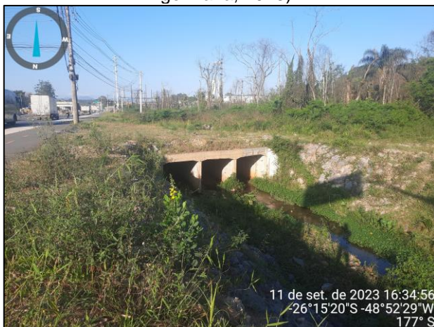
Figura 39: (R18) Vista para o trecho 60 com destaque para o início da galeria fechada (Fonte: Carbono Engenharia, 2023).
