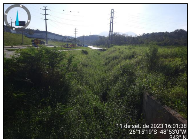
Figura 26: (R11) Vista para o trecho 44 com destaque para a antropização nas margens do corpo hídrico (Fonte: Carbono Engenharia, 2023).
