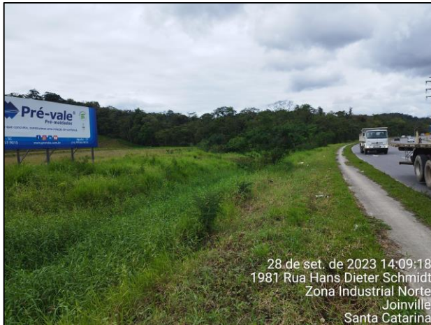
Figura 17 - (R4) Vista para o trecho 31 com destaque para a antropização nas margens do corpo hídrico (Fonte: Carbono Engenharia, 2023)
