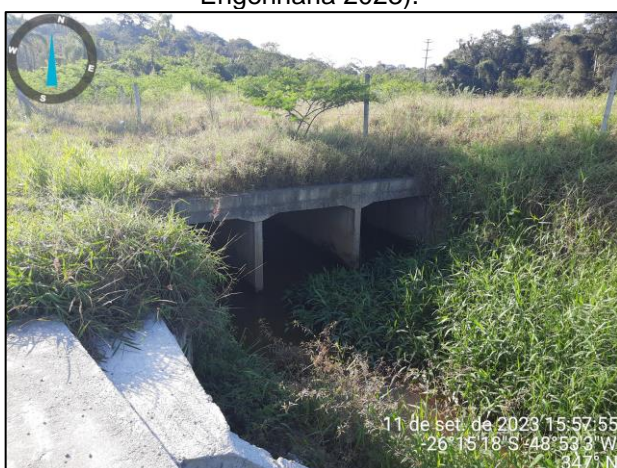
Figura 25: (R10) Vista para o trecho 43 com destaque para a saída da galeria fechada (Fonte: Carbono Engenharia, 2023).
