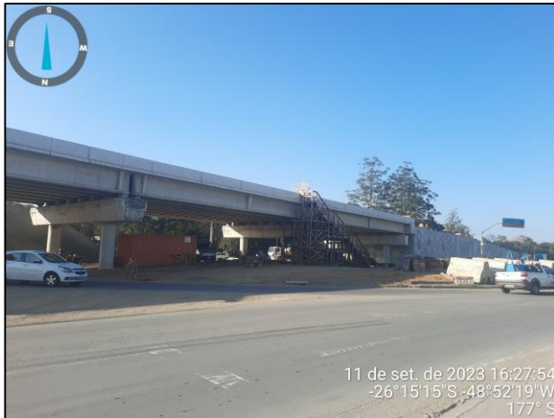
Figura 41 - (R20) Vista para o trecho 60 com destaque para as obras do elevador que estão acontecendo sobre o trecho (Fonte: Carbono Engenharia, 2023)
