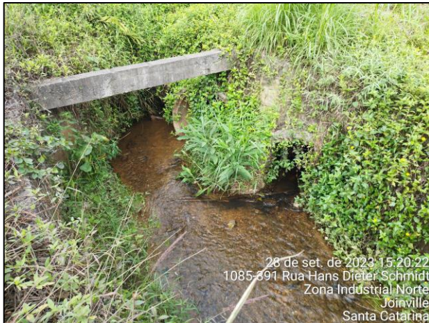
Figura 35: (R15) Vista para o trecho 58 com destaque para o início da tubulação (Fonte: Carbono Engenharia, 2023).
