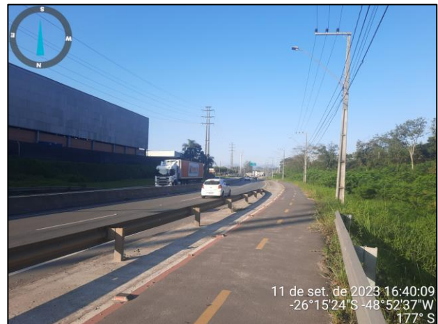
Figura 38: (R17) Vista para o trecho 59 com destaque para a via pública (Fonte: Carbono Engenharia, 2023).
