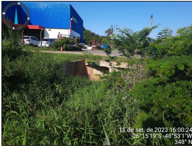
Figura 27 – (R11) Vista para o trecho 45 com destaque para o início da galeria fechada (Fonte: Carbono Engenharia, 2023).
