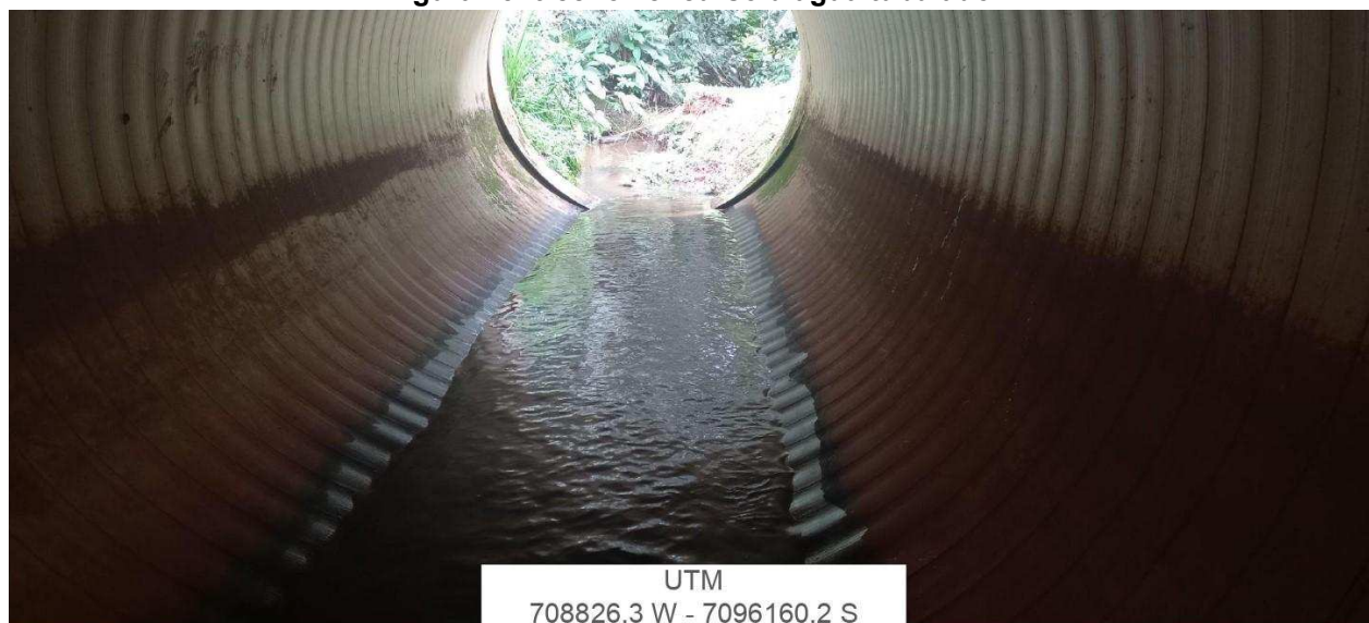
Figura 25: trecho 78- curso d'água tubulado
