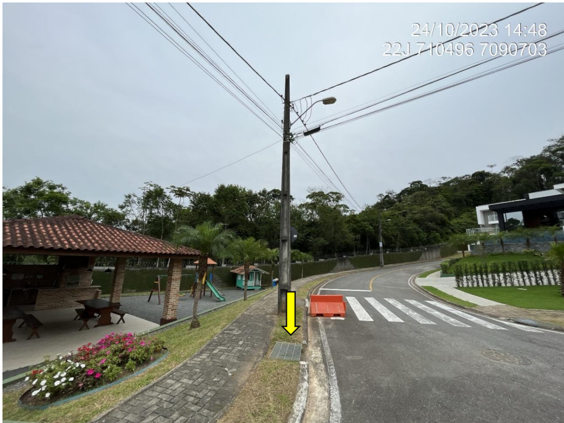
Figura 9: Rua das rosas, pavimentada com asfalto. Observa-se rede de distribuição de energia elétrica e boca de lobo para coleta de água pluvial. Fonte: Autores.
