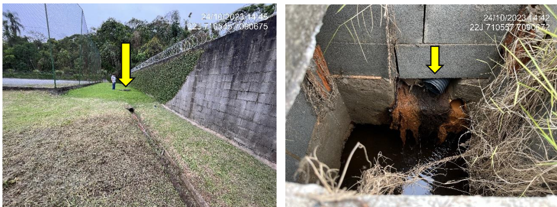
Figura 10: Rede de drenagem na lateral da rua primavera, inserida no condomínio Quinte Essence. Fonte: Autores.
