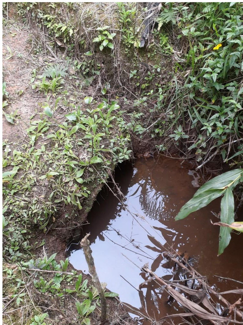
Figura 19: Final do trecho 02 (tubulado) e início do trecho 03. Fonte: Autores.
