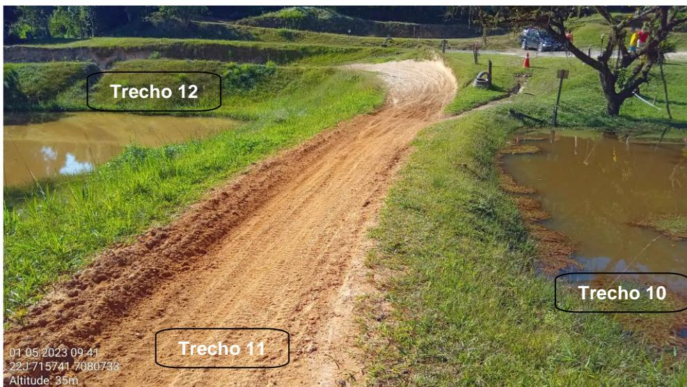
Figura 27: Trecho 11, tubulado, entre os reservatórios dos trechos 10 e 12. Fonte: Autores.
