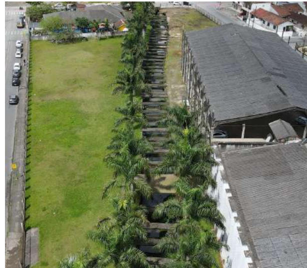
Figura 33: Trecho 5 visto de cima, foto com drone, mostrando todo o caminho do Rio nas galerias abertas ao lado da igreja.
