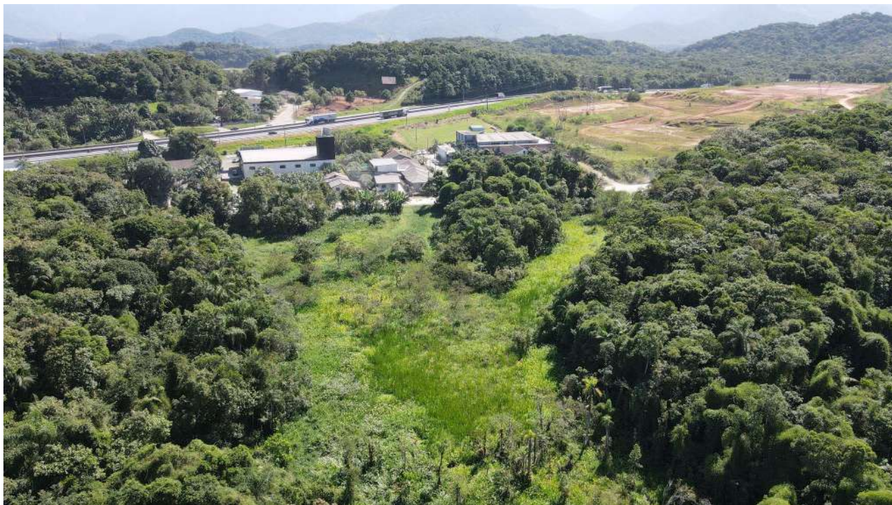
Figura 18: Vista dos trechos 41A, 41B,, 35, 31A e 31B.
