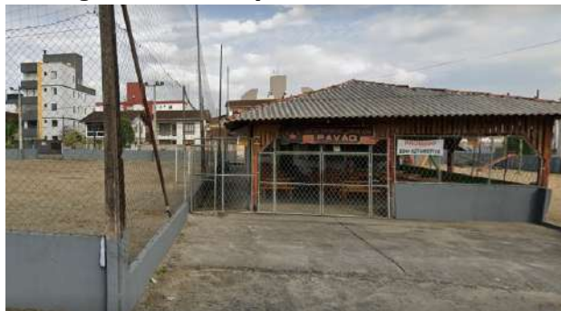
Figura 23: Centro Esportivo Comunitário Pavão.
