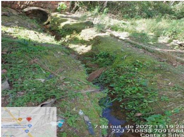
Figura 57: Trecho 48C, Foto tirada de ponto onde ainda é observado corpo hídrico aberto em vegetação densa antropizada.
