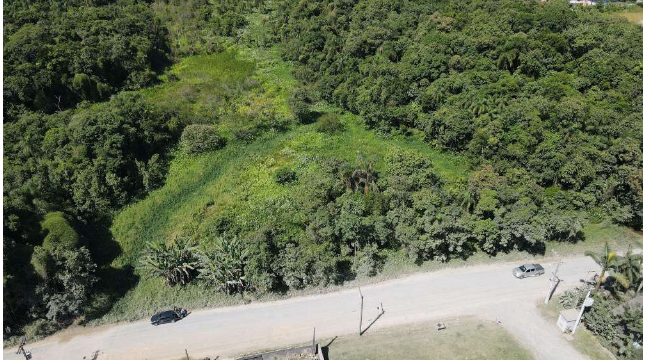
Figura 54: Vista dos trechos 36 e 42, tubulados sob via. Trechos 41, 35 e 31B em meio a vegetação antropizada.
