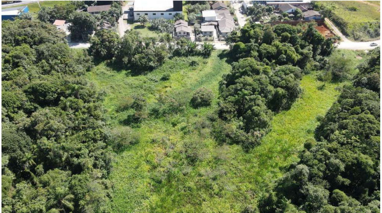
Figura 55: Vista dos trechos 36 e 42, tubulados sob via. Trechos 41, 35 e 31B em meio a vegetação antropizada.
