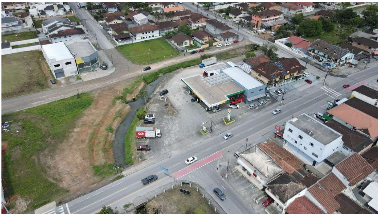
Figura 08: Destaque para trechos desprovidos de cobertura vegetal.
