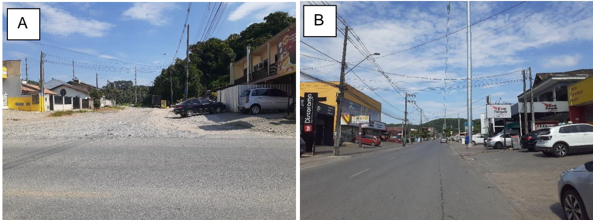
Figura 38: A: Vista para trecho 18, rua Maria Lucimar Fritz, vista a partir da rua 6 de janeiro; B: Contexto do trecho 18 tubulado sob via, rua Seis de Janeiro. Fonte: Autores.
