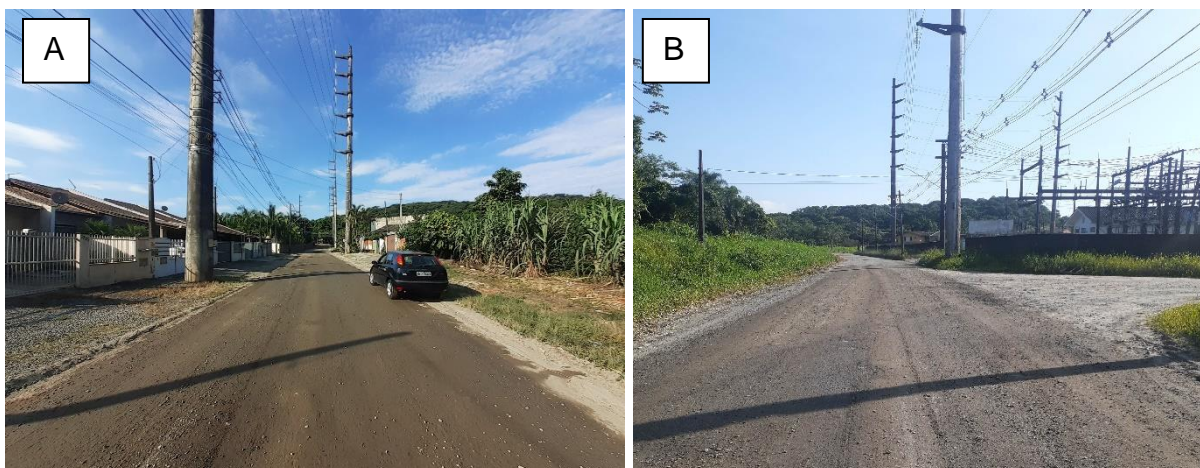
Figura 37: A: Contexto do trecho 12, tubulado sob via, com vista para as nascentes; B: Vista para o final do trecho 12, tubulado sob via. Fonte: Autores.
