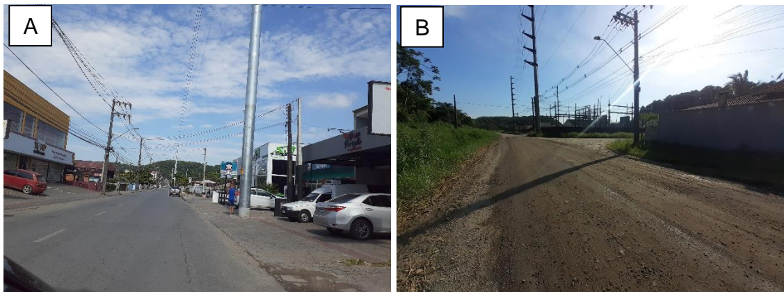
Figura 14: A: Rua 6 de Janeiro foz da microbacia, trecho 18. B: Vista para subestação Joinville Paranaguamirim, próximo ao trecho 17-B e 18. Fonte: Autores.
