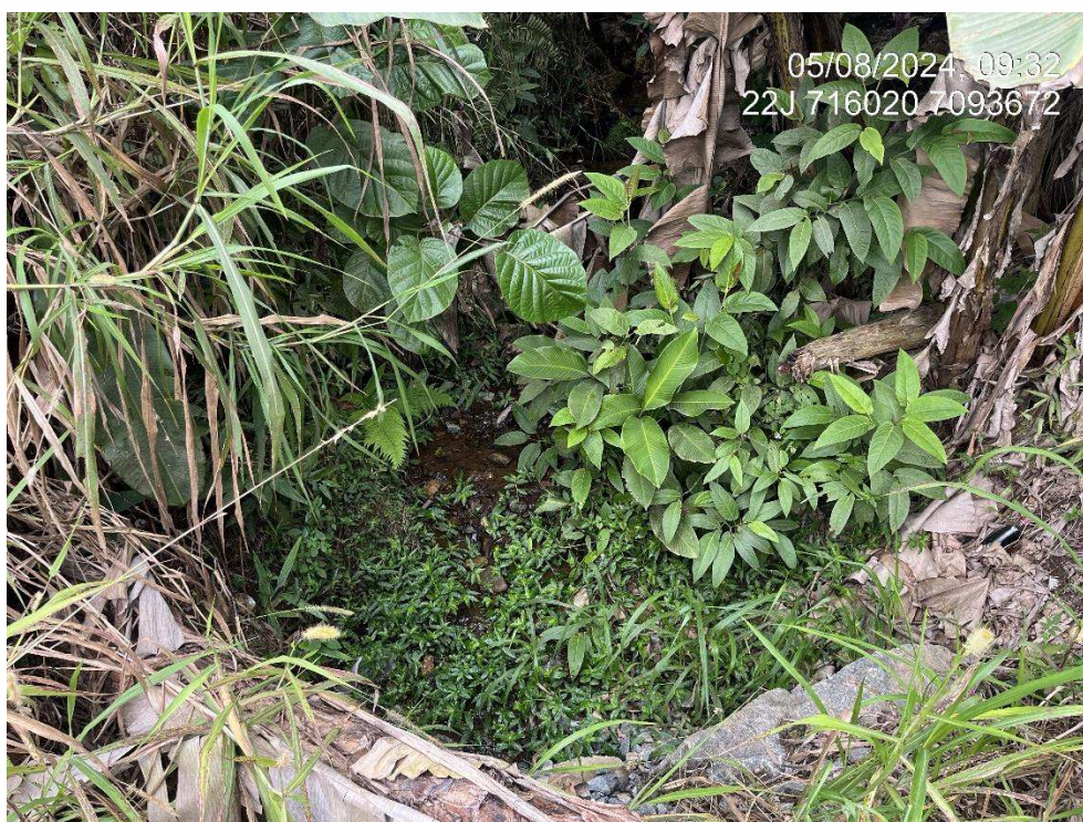
Figura 24: Vista para trecho 01E (Jusante). Fonte: Autores.
