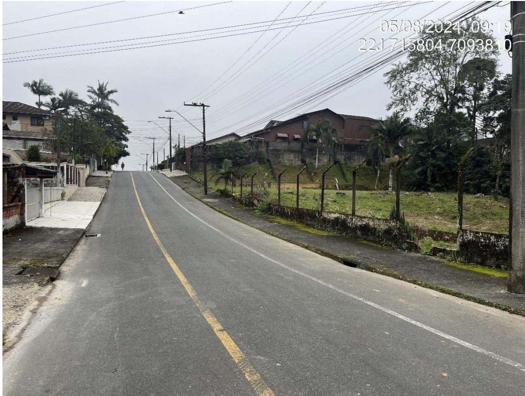
Figura 19: Postes de luz e boca de lobo na rua Itá. Fonte: Autores.
