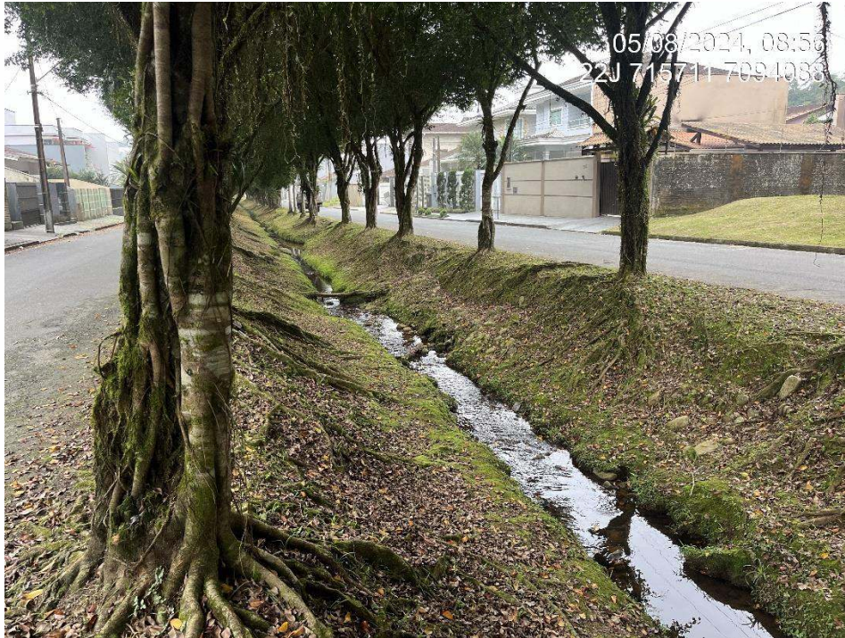
Figura 35: Trecho 37. Fonte: Autores.
