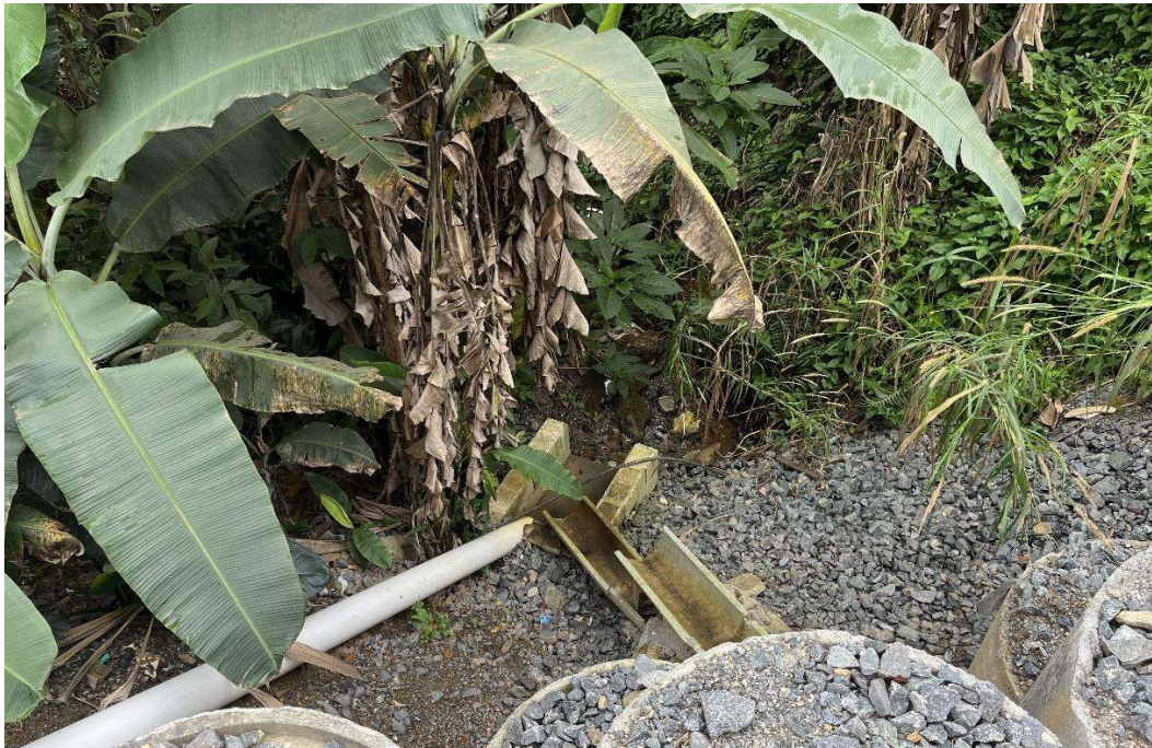
Figura 25: Fim do trecho 02 e início do trecho 03 (Vista a montante). Fonte: Autores.
