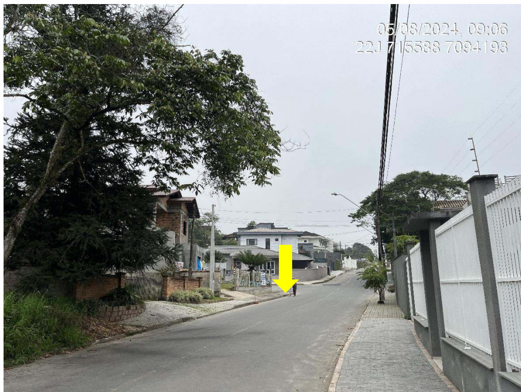
Figura 18: Postes de luz e boca de lobo na rua Leão XIII. Fonte: Autores.
