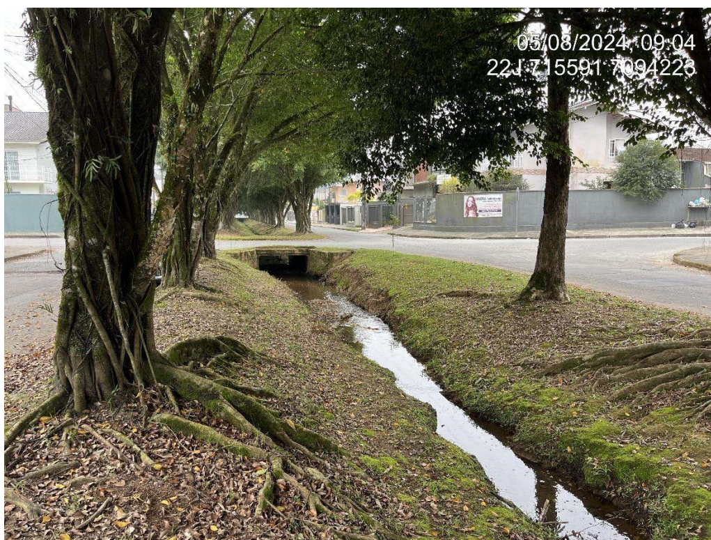
Figura 41: Trecho 41. Fonte: Autores.
