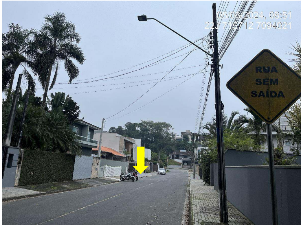
Figura 17: Rua Pedro Gervásio Bernardes, Postes de luz e boca de lobo. Fonte: Autores.
