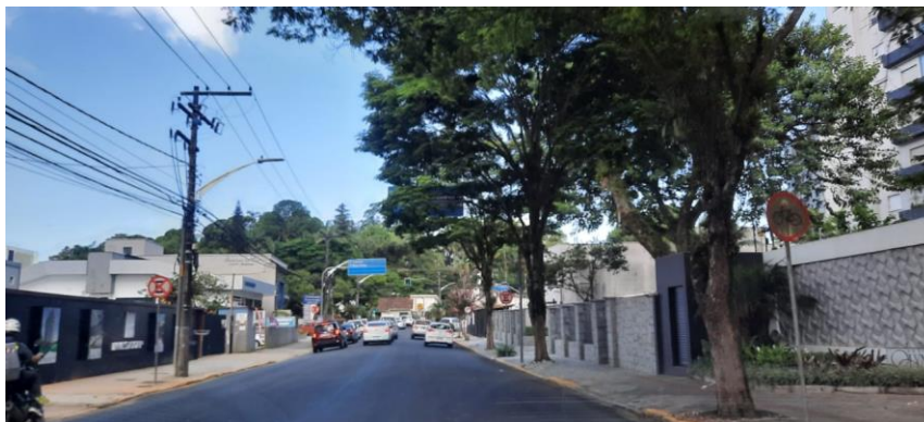
Figura 10. Placa de sinalização encoberta por árvores.
