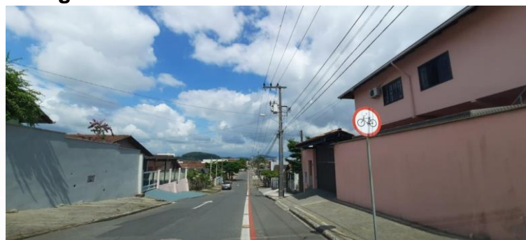
Figura 11. Trecho de ciclovia existente em Joinville.
