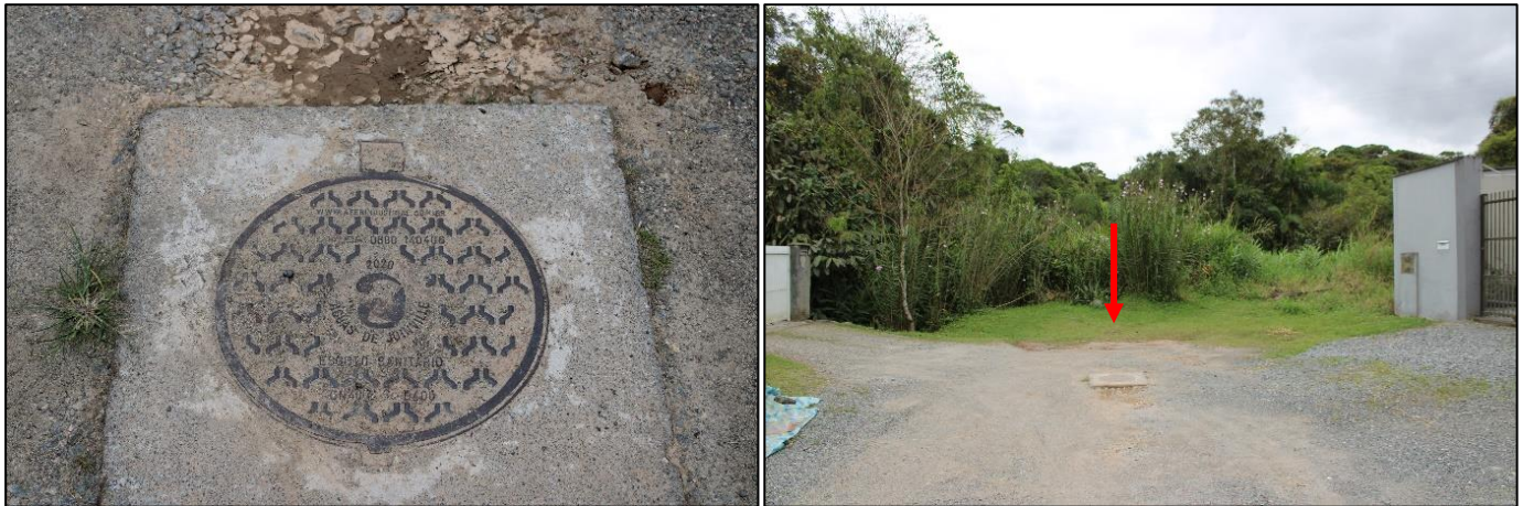
Figura 47: Poço de Inspeção de rede coletora de esgoto sanitário localizado na Rua Elário Gastão Baumer. Fonte: vistoria realizada no dia 25/10/2022 pela equipe técnica da Bioeco.
