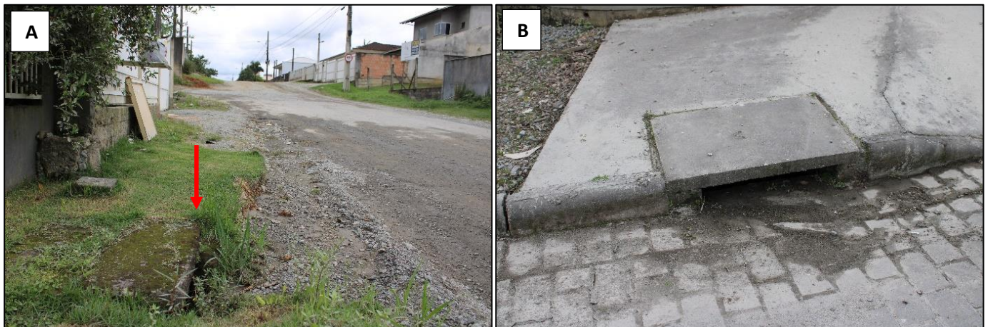
Figura 49: Bocas de lobo tipo guia registradas na área objeto de estudo. Legenda: A – Registro boca de lobo tipo guia localizada na Rua Alberto Vinci, no quadrante C. B – Boca de lobo tipo guia localizada na Rua Gerhard Dietrich Barkemeyer, no quadrante C. Fonte: vistoria realizada no dia 25/10/2022 pela equipe técnica da Bioeco.
