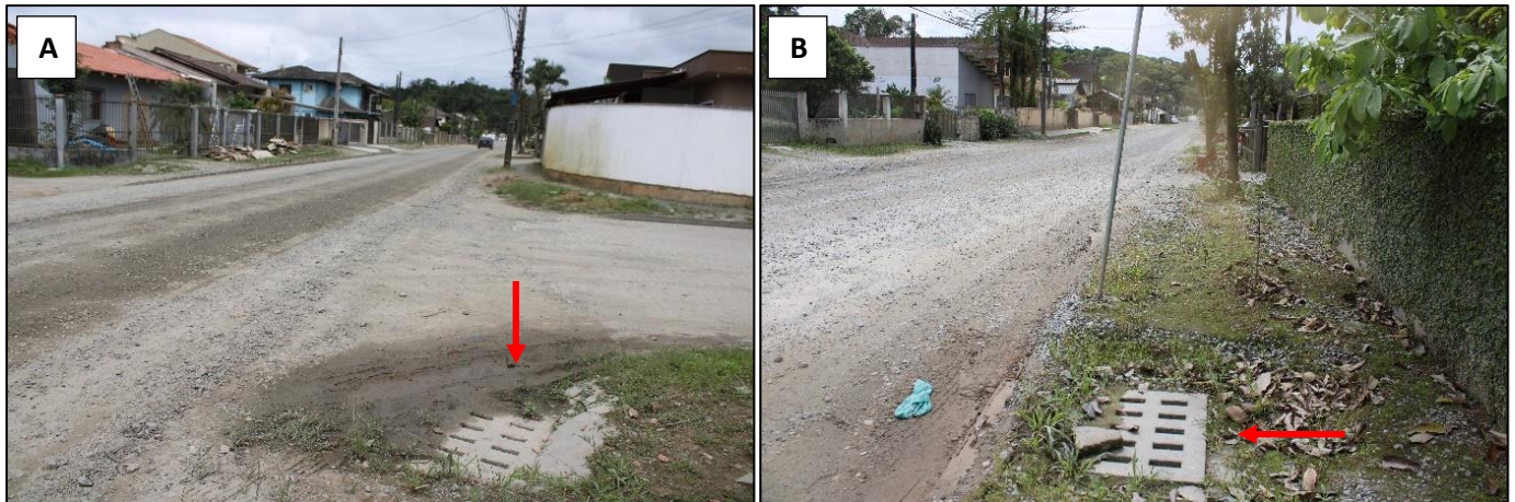
Figura 48: Bocas de lobo tipo grelha registrado na área objeto de estudo. Legenda: A – Registro boca de lobo localizada na esquina das Ruas Sebastião Jonck e Pascoal Filippi, no quadrante B. B – Boca de lobo localizada na Rua Sebastião Jonck, no quadrante B. Fonte: vistoria realizada no dia 25/10/22 pela equipe técnica da Bioeco.
