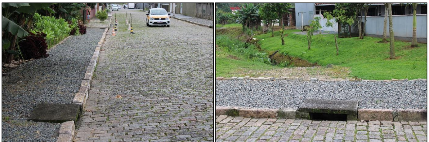
Figura 50: Bocas de lobo tipo guia. Registro boca de lobo tipo guia localizada na Rua Adolfo Kluver, no quadrante C. Fonte: vistoria realizada no dia 31/10/2022 pela equipe técnica da Bioeco.
