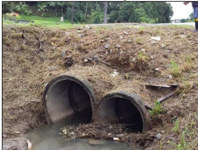
Figura 37 - Aspecto geral do trecho 42 evidenciando passagem por baixo da rua Adolfo da Veiga.
