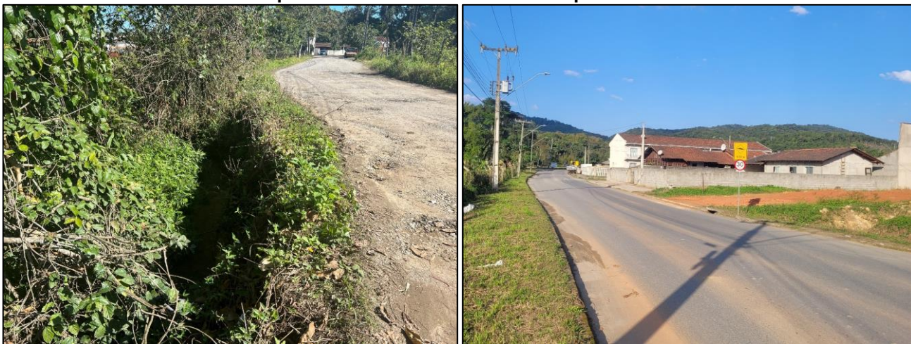
Figura 42 - Localização em campo do trecho 41 evidenciando que o corpo d'água inicialmente aberto e posteriormente tubulado sob via pública.
