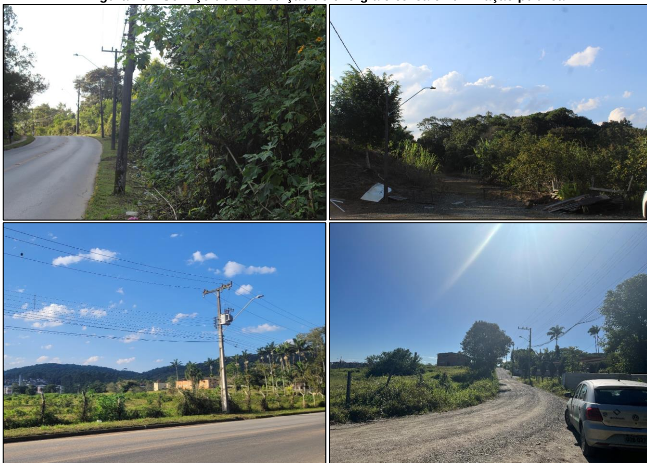
Figura 28 – Serviço de distribuição de energia elétrica e iluminação pública.
