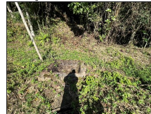
Imagem 13 – Saída de canal tubulado.
