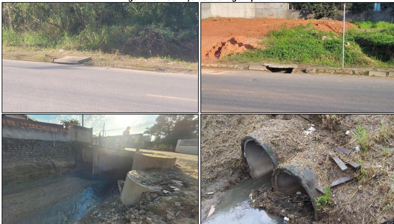
Figura 29 – Serviço de drenagem pluvial.
