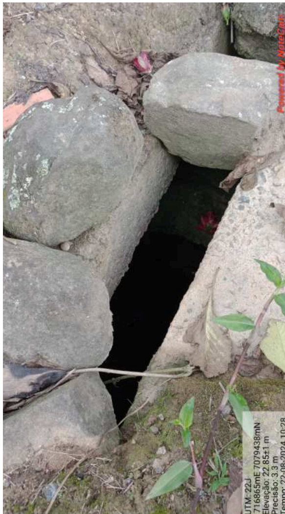
Figura 22: Boca de lobo no encontro do trecho 19 com o 20.
