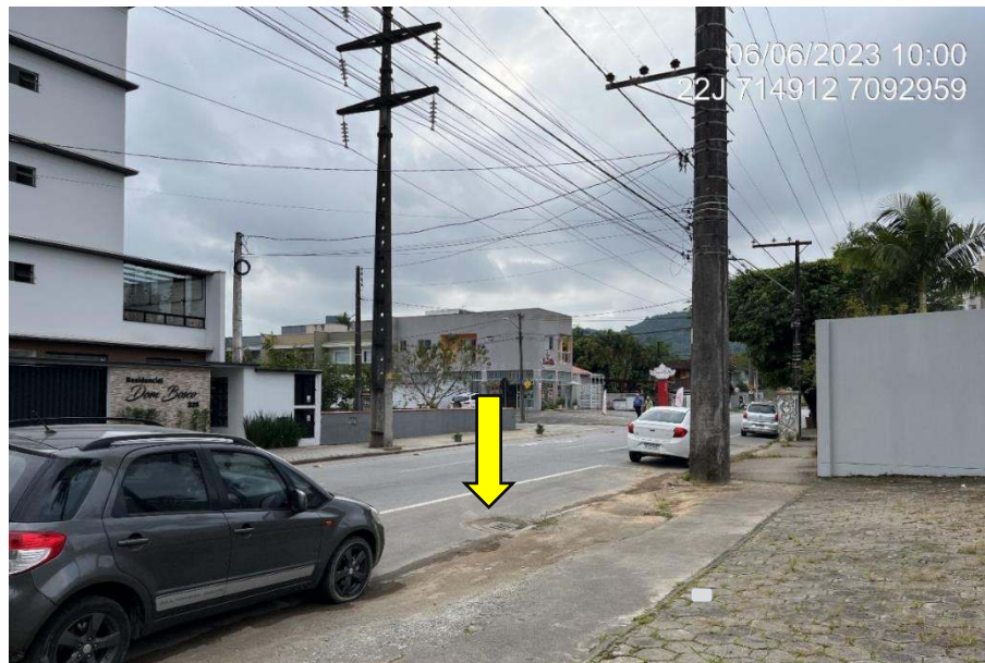
Figura 12: Rua Dom Bosco, pavimentada. Contém rede de distribuição de energia elétrica e boca de lobo para coleta de água pluvial. Fonte: Autores.
