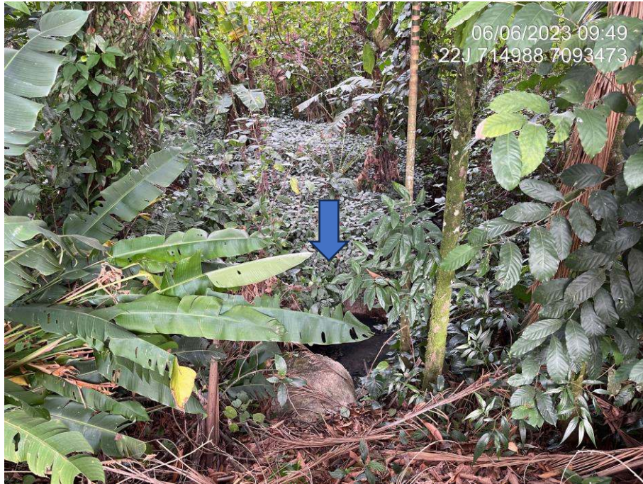
Figura 19: Trecho 3, tubulado, para trecho 4, aberto. Fonte: Autores.
