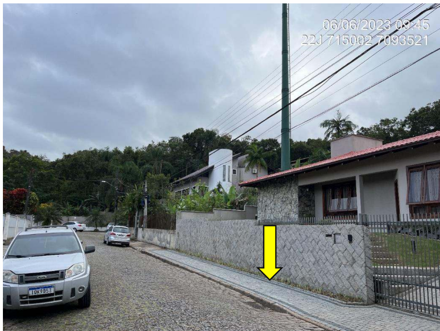
Figura 10: Rua Fortunata Zanella, pavimentada por lajotas e paralelepípedos. Observa-se rede de distribuição de energia elétrica e boca de lobo para coleta de água pluvial. Fonte: Autores.
