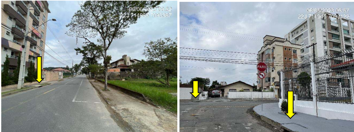
Figura 11: Rua Germano Wetzel (esq), pavimentação: contém rede de distribuição de energia elétrica e boca de lobo para coleta de água pluvial. Rua Waldemar C. Richter (dir.) pavimentação, com rede de distribuição de energia elétrica e boca de lobo para coleta de água pluvial. Fonte: Autores.
