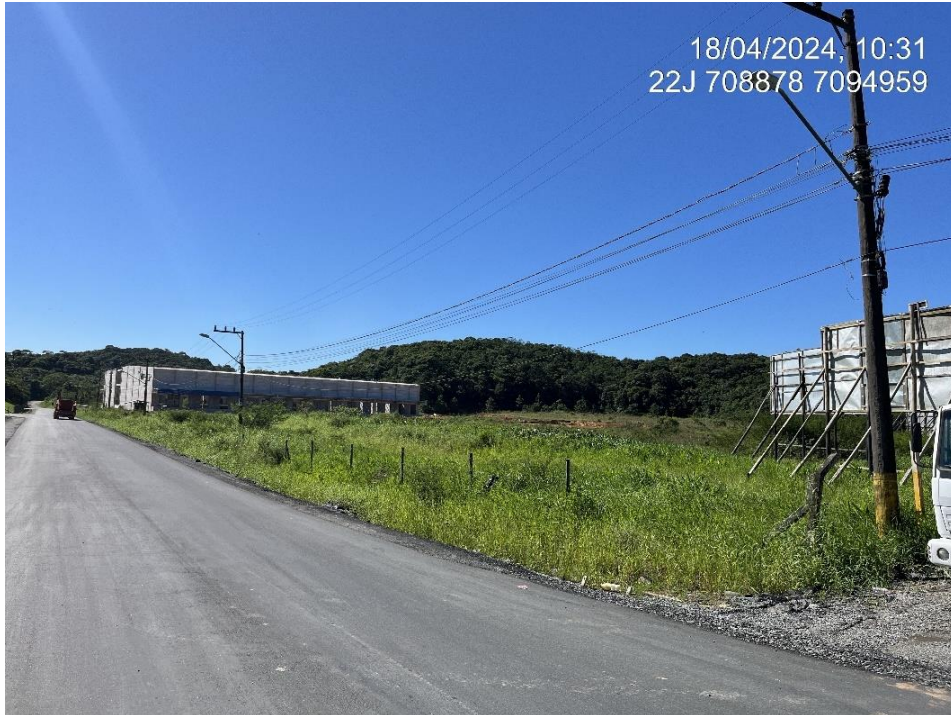
Figura 18: Postes de luz na Rua dos Bororos. Fonte: Autores.
