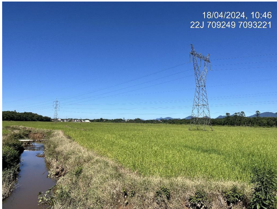
Figura 20: Linhas de alta tensão próximas ao trecho 59A e 59B.
