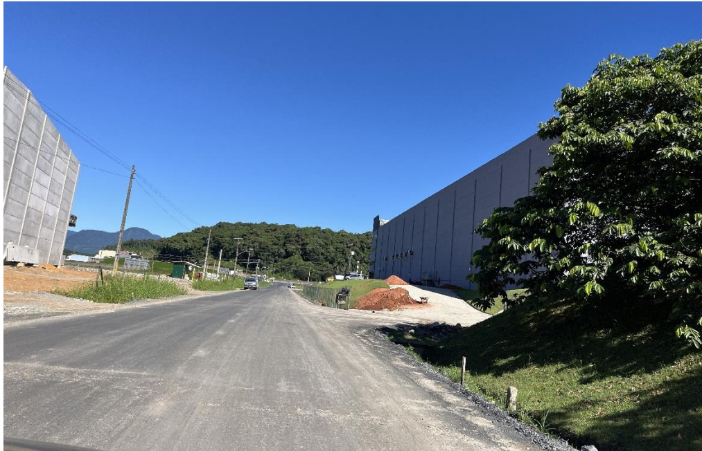
Figura 11: Região do trecho 10 –jusante.
