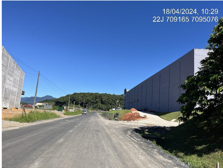
Figura 25: Trecho 10 (Vista de montante). Fonte: Autores.
