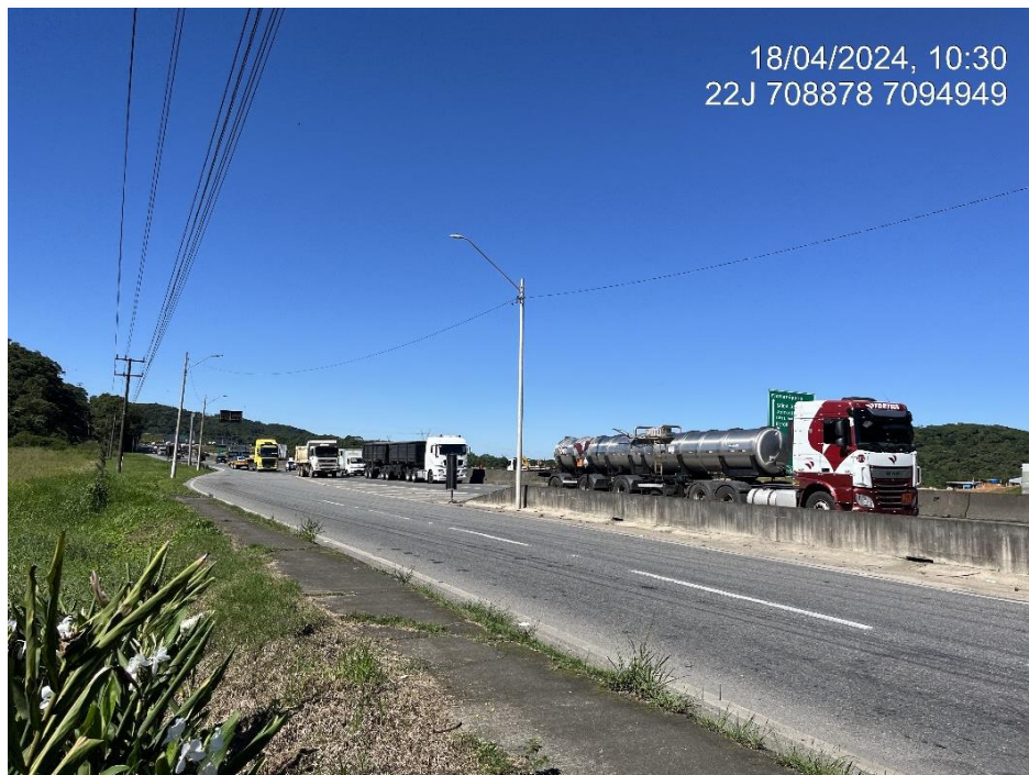
Figura 17: Postes de luz a marginal do Posto Buffon. Fonte: Autores.
