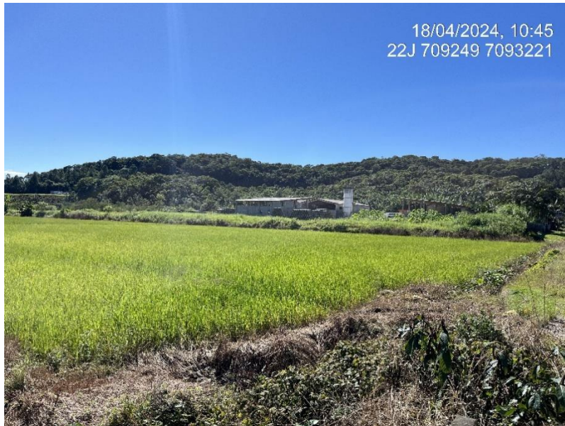
Figura 37: Trecho 43, vista do trecho 44. Fonte: Autores.
