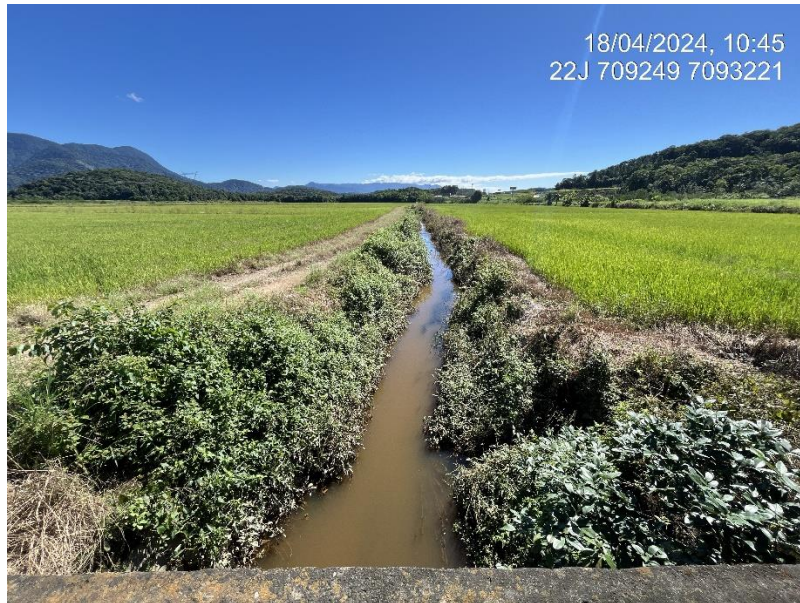
Figura 33: Trecho 40, vista do trecho 44. Fonte: Autores.
