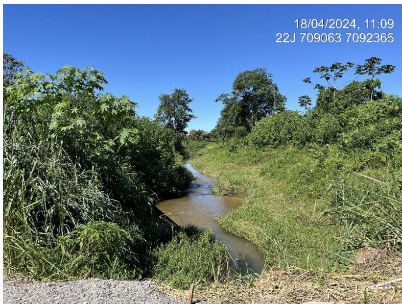
Figura 51: Trecho 75 (Foz da MB – Tubulado), desaguando no Rio Águas Vermelhas. Fonte: Autores.
