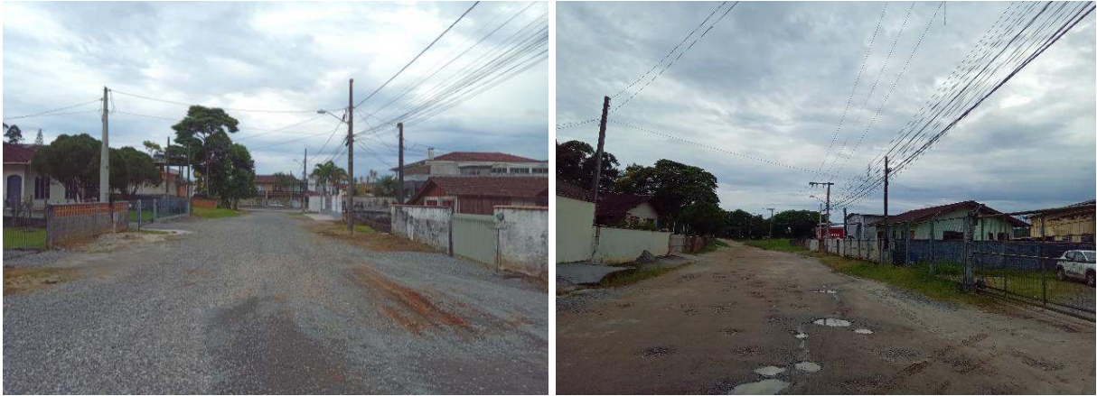
Figura 12: Rua Frei Vicente (esq.) e rua João Basílio Corrêa (dir.) sem pavimentação, com rede de distribuição de energia elétrica. Fonte: Autores.
