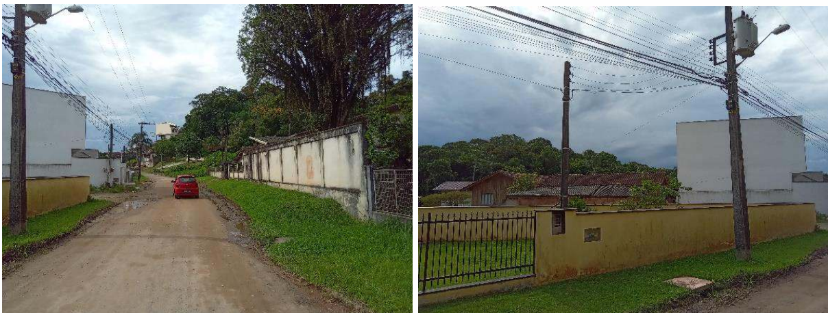
Figura 11: Rua Israel, não pavimentada. Observa-se rede de distribuição de energia elétrica, boca de lobo para coleta de água pluvial e registros de água. Fonte: Autores.
