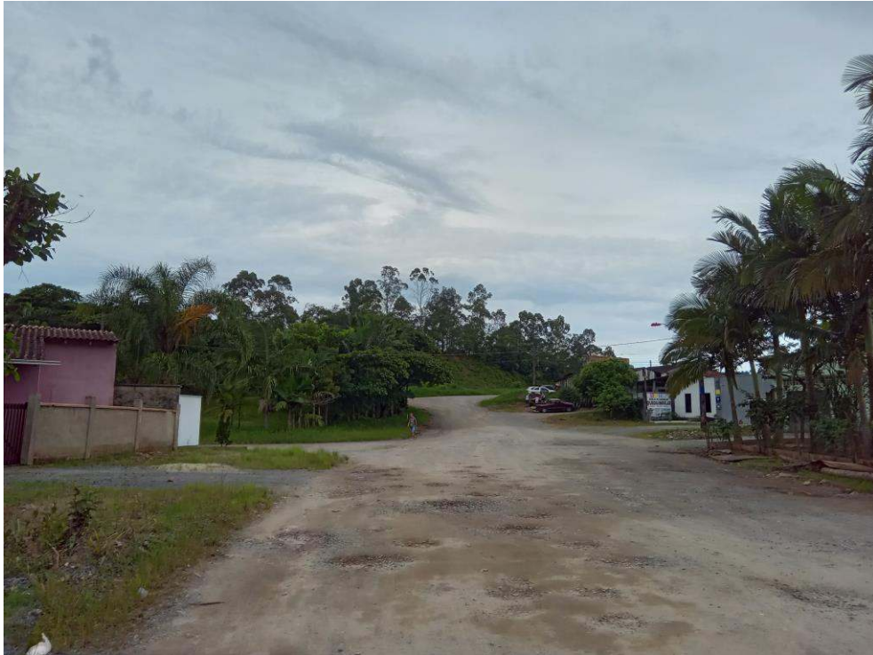
Figura 26: Trecho 13, sob via, vista para montante, av. Francisco Alves. Fonte: Autores.
