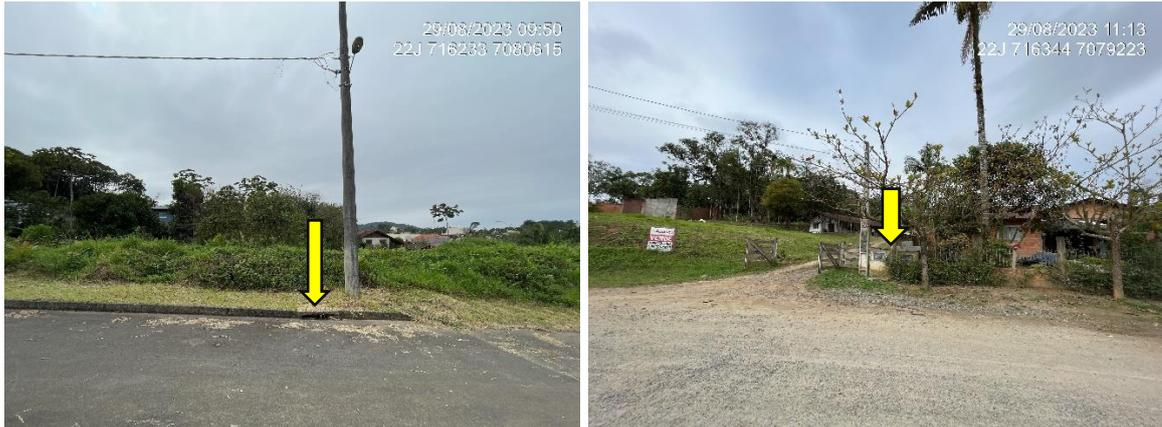
Figura 11: Rua Sebastião Pereira dos Santos (esq), pavimentação. Contém rede de distribuição de energia elétrica e boca de lobo para coleta de água pluvial. Rua Cidade de Luziânia (dir.) sem pavimentação, com rede de distribuição de energia elétrica e registros de água. Fonte: Autores.
