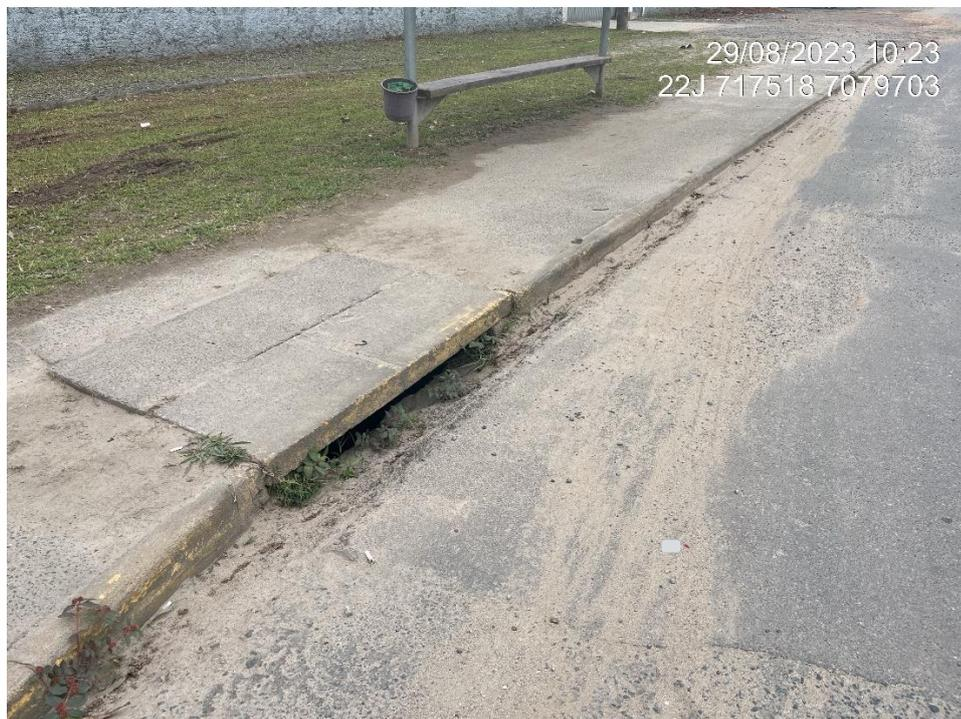
Figura 12: Rua Waldemiro José Borges, pavimentada. Contém boca de lobo para coleta de água pluvial. Fonte: Autores.
