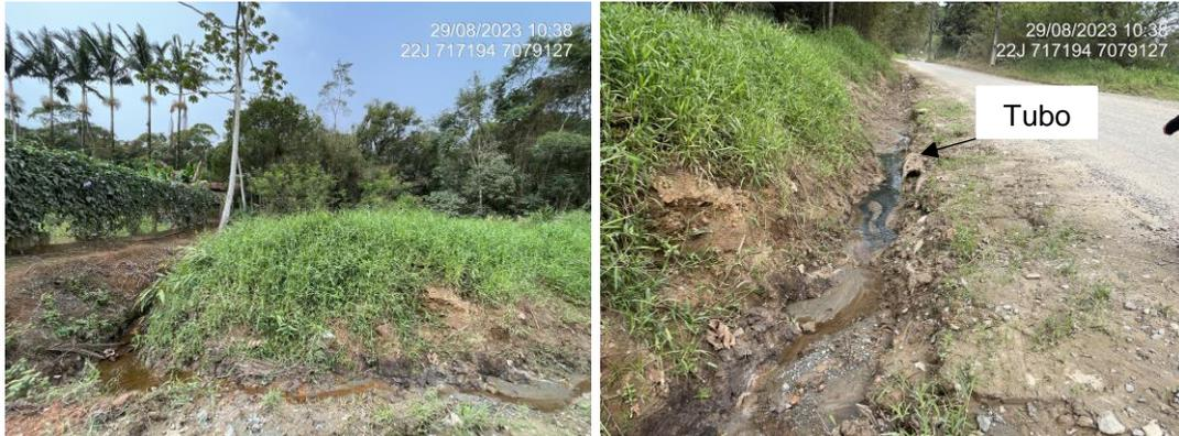
Figura 31: Trecho 35, aberto, para trecho 36, tubulado. Fonte: Autores.
