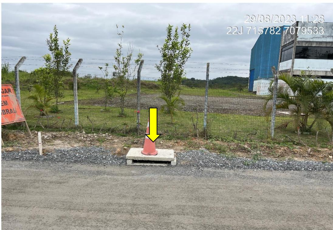
Figura 10: Rua Santa Catarina, em obras para pavimentação. Observa-se a boca de lobo para coleta de água pluvial. Fonte: Autores.
