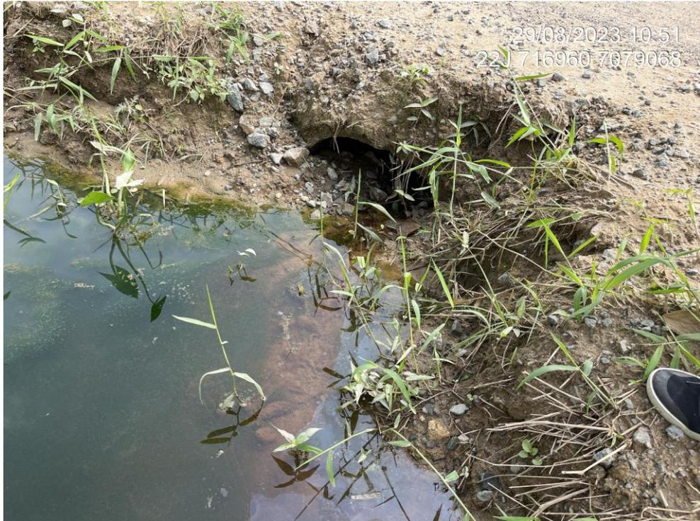
Figura 36: Trecho 45, aberto, para trecho 46, tubulado sob via. Fonte: Autores.
