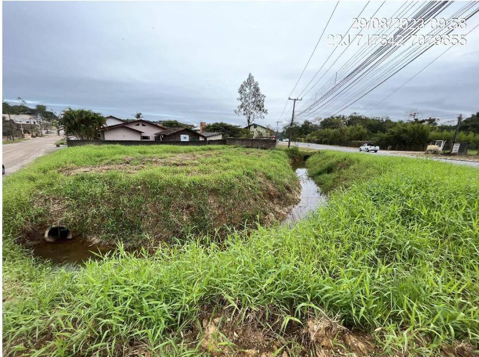
Figura 24: Contexto do trecho 22 (vista para montante); tubulação do trecho 21 na direita e tubulação do trecho 23 na esquerda da imagem. Fonte: Autores.
