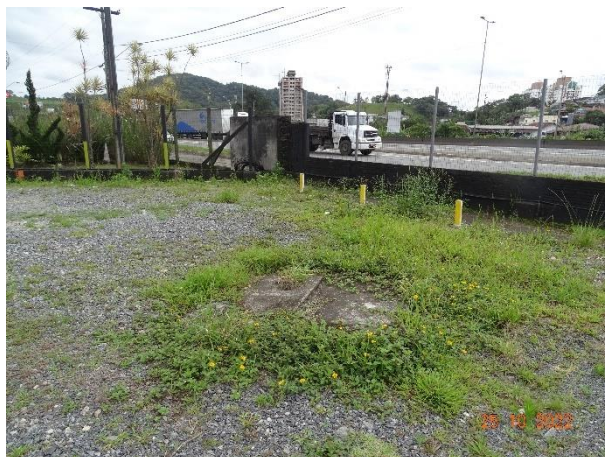
Trecho 4D (R11): Dentro do imóvel com inscrição imobiliária 13-20-01-23-1856, próximo a BR-101. Trecho fechado sob via pública.
