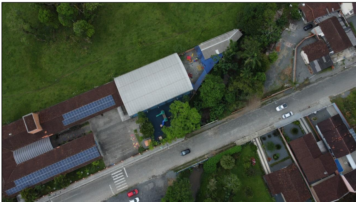
Foto 63 - Foto aérea da escola instalada na margem do curso hídrico (Trecho 18).
