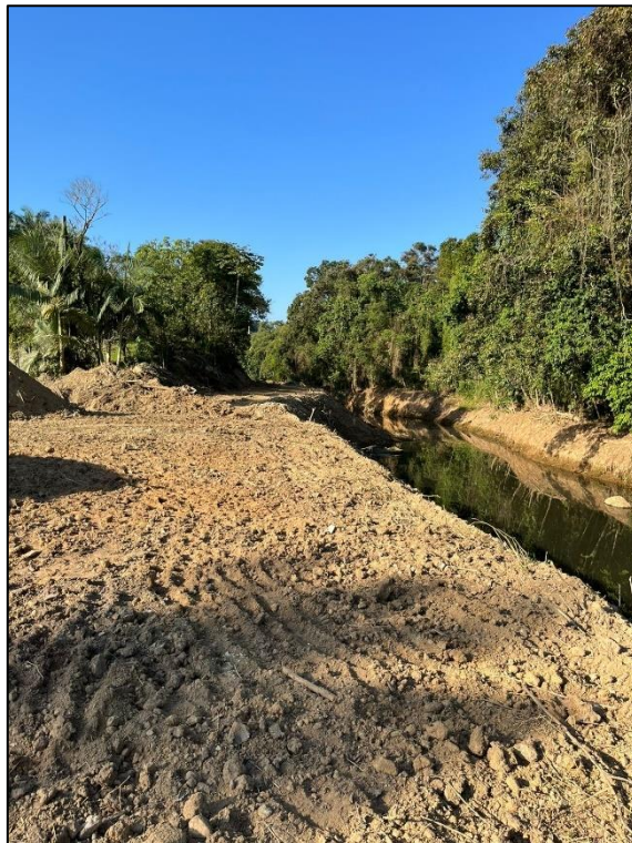
Foto 35 - Vista da margem do Rio do Braço, paralela à R. Manoel Calixto Rodrigues, com deposição de material de desassoreamento.
