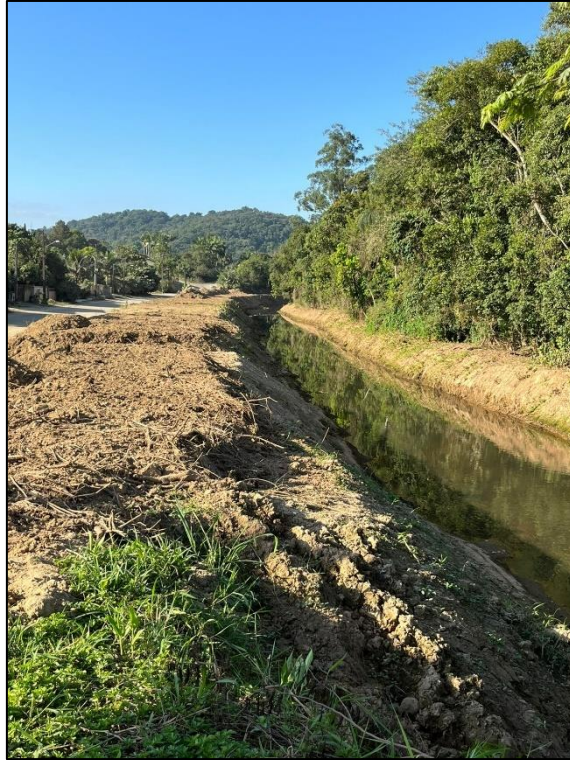
Foto 34 - Vista da margem do Rio do Braço, paralela à R. Manoel Calixto Rodrigues, com deposição de material de desassoreamento.
