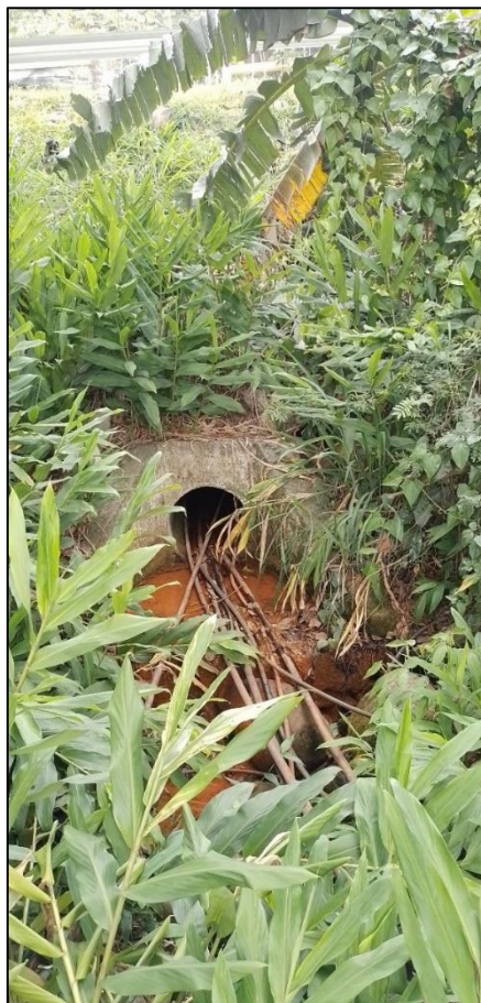
Foto 44 - Trecho 9, saída do corpo d'água sob a BR-101 (fotografia a partir do P6), início de pequeno trecho aberto. Nota: necessita de correção da base.
