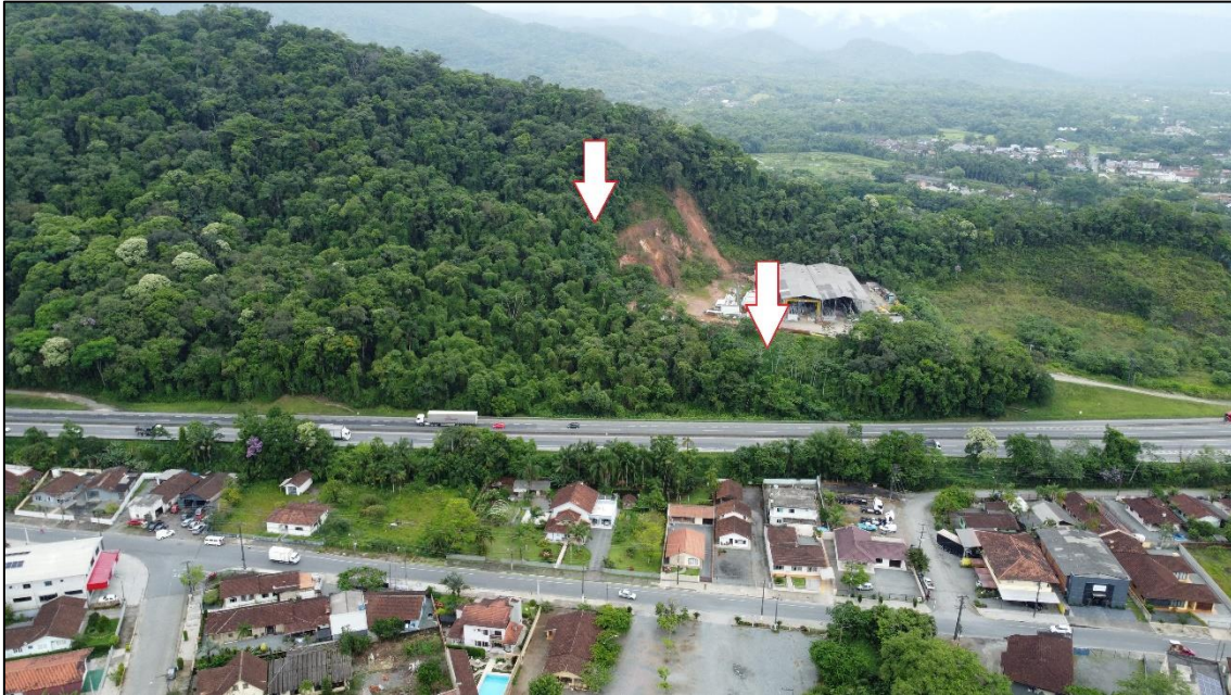
Foto 37 - Localização aproximada das nascentes inseridas em vegetação densa, com os respectivos cursos d'água tubulados atravessando a Rod. BR-101.
