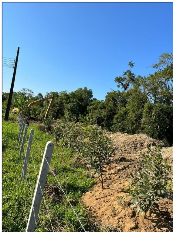
Foto 36 - Vista da margem do Rio do Braço, paralela à R. Manoel Calixto Rodrigues, com deposição de material de desassoreamento.
