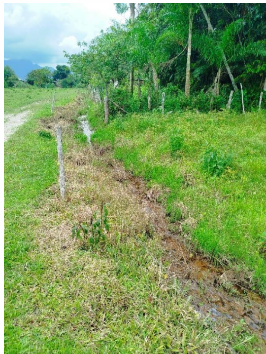
Figura 32: Vista para montante, trecho 03B, detalhe do cercamento. Fonte: Autores.
