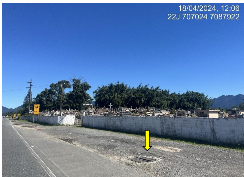
Figura 21: Rodovia Rodolfo Jahn, pavimentada por asfalto, em frente ao cemitério Cristo Rei, com boca de lobo para sistema de drenagem pluvial, e distribuição de energia elétrica.
