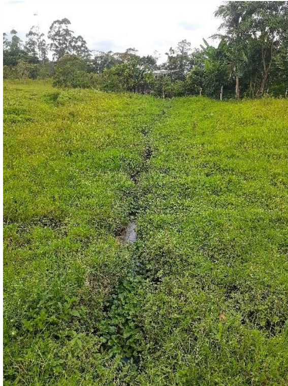
Figura 28: Vista de montante trecho 01B para trecho 01C. Fonte: Autores.
