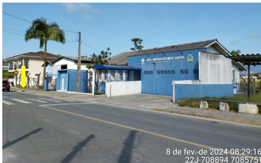
Figura 23: Rua Lagoinha, com pavimentação com asfalto. Apresenta rede de energia elétrica, boca de lobo e Unidade Básica de Saúde Bucal.
