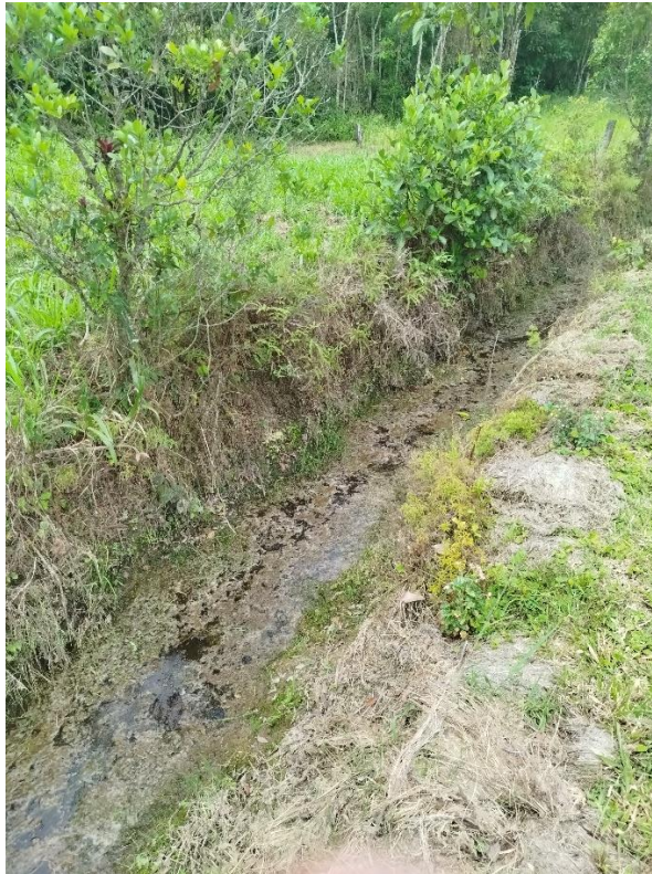
Figura 35: Trecho 06A, vista de jusante. Fonte: Autores.
