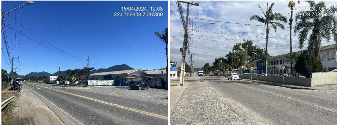
Figura 22: Rua Conselheiro Pedreira (esq.) pavimentação com asfalto: contém rede de distribuição de energia elétrica e a Escola Professora Senhorinha Soares. Rua Minas Gerais (dir.) contém pavimentação com asfalto, com rede de distribuição de energia elétrica e Escola Professora Elizabeth Von Dreifuss. Fonte: Autores.
