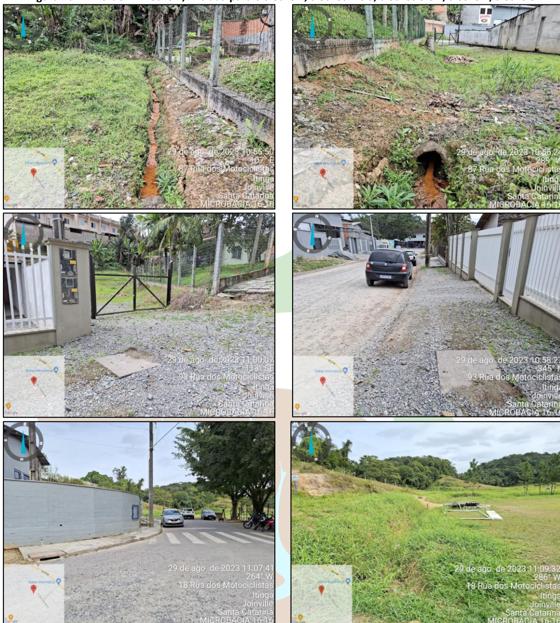
Figura 16 - Em ordem: Trecho 1, Entrada para o trecho 2, trechos 2 e 3, trechos 3 e 4, trecho 4, trecho 5.
