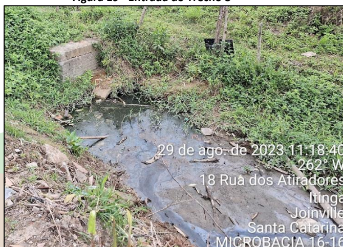
Figura 19 - Entrada do Trecho 8
