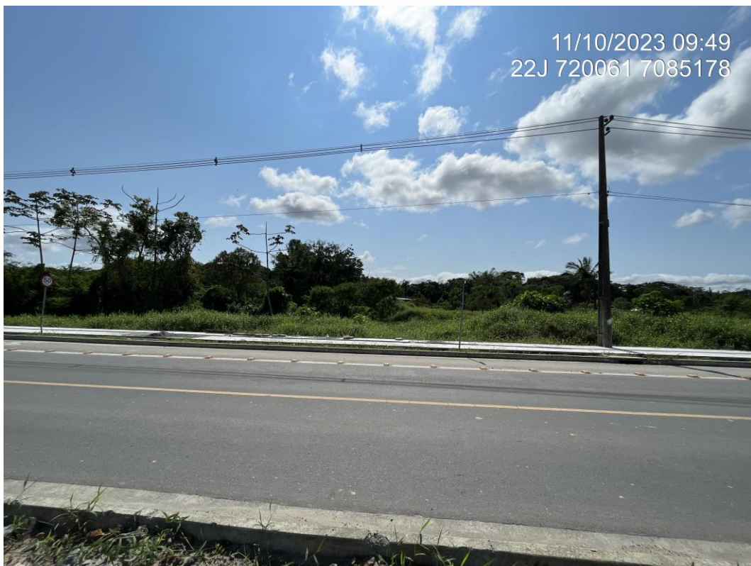
Figura 24: Vista para trechos 02 (tubulado sob via) e 03A. Fonte: Autores.
