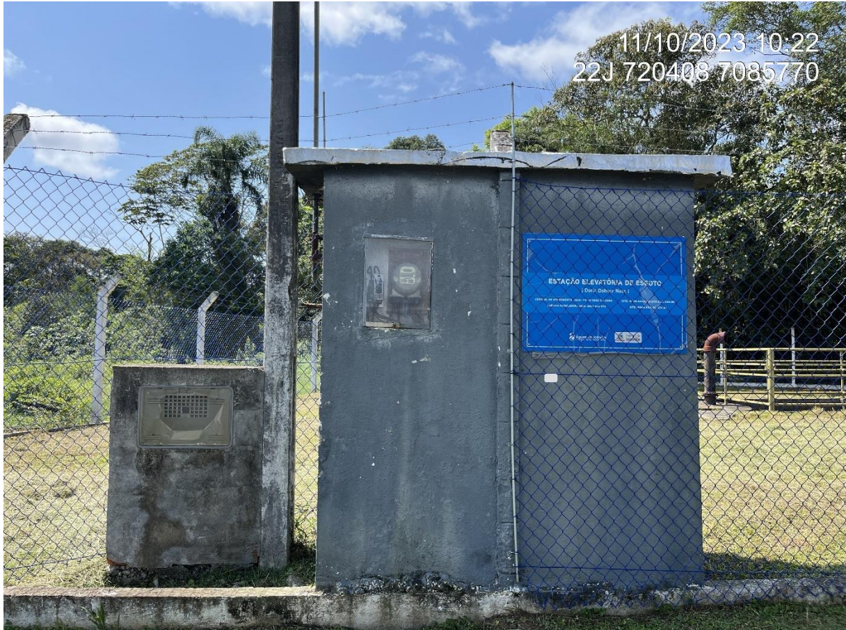
Figura 14: Rua Doris Dobner Nass, sem pavimento. Contém rede de distribuição de energia elétrica e estação elevatória de esgoto. Fonte: Autores.
