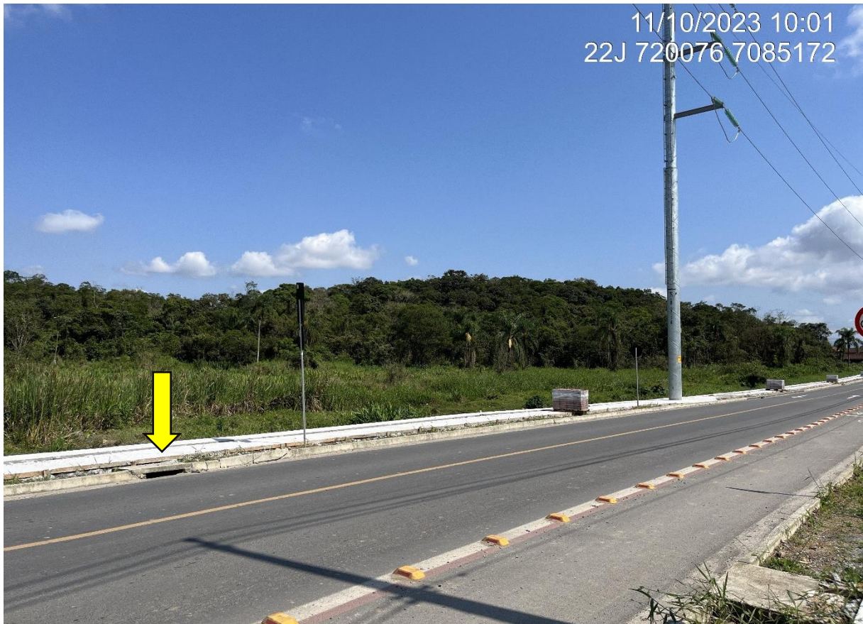
Figura 12: Rua Eurides Francisco Tomasoni, pavimentada com asfalto. Observa-se rede de distribuição de energia elétrica e boca de lobo para coleta de água pluvial. Fonte: Autores.
