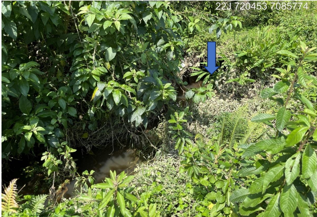
Figura 30: Fim do trecho 04 (tubulado) e início do trecho 05 (aberto) (vista a montante). Fonte: Autores.
