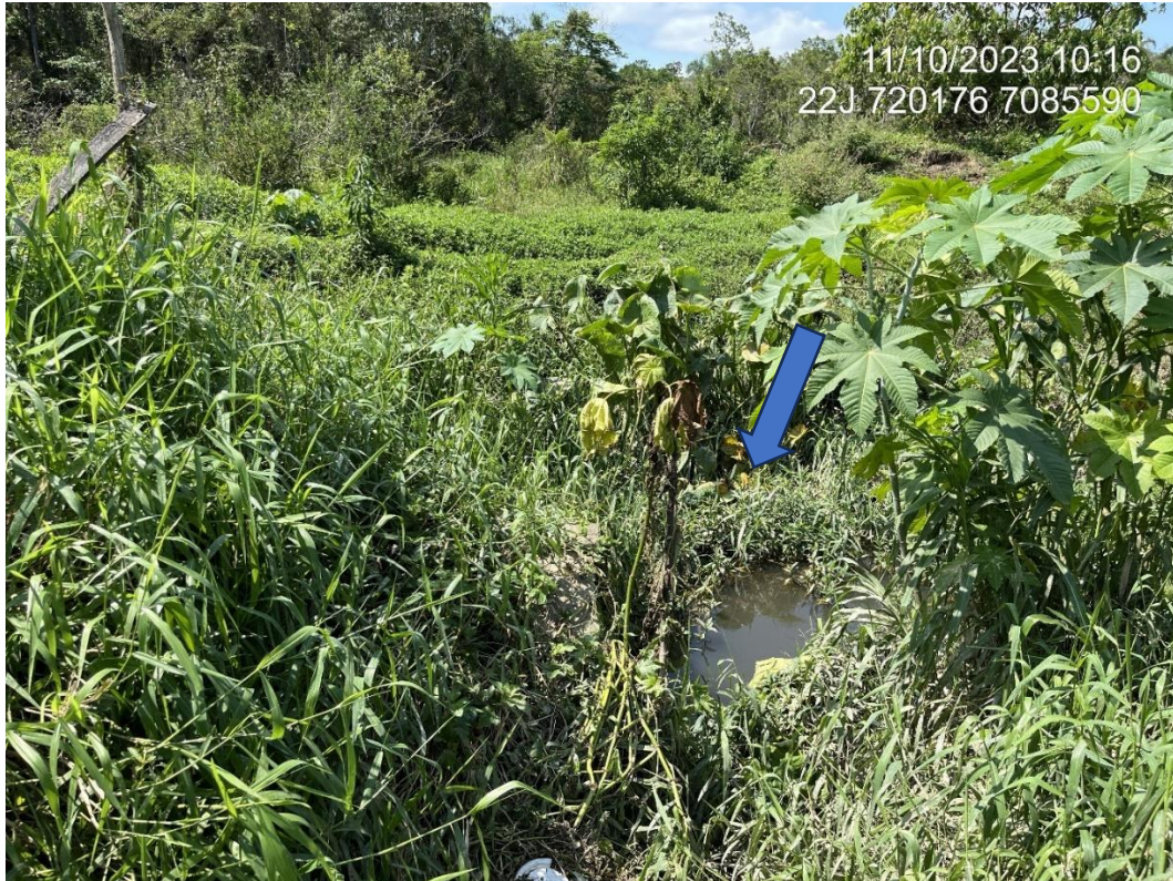
Figura 27: Trecho 3E, aberto, para trecho 4, tubulado. Fonte: Autores.
