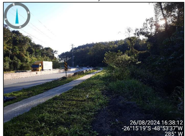
Figura 15: (R6) Vista para o trecho 16 com destaque para a vegetação nas margens a proximidade com a via (Fonte: Carbono Engenharia, 2024).
