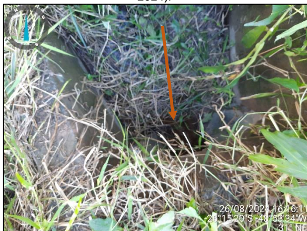
Figura 16 - (R7) Vista do início do trecho 19, na entrada da tubulação, com presença de vegetação no entorno. (Fonte: Carbono Engenharia, 2024).
