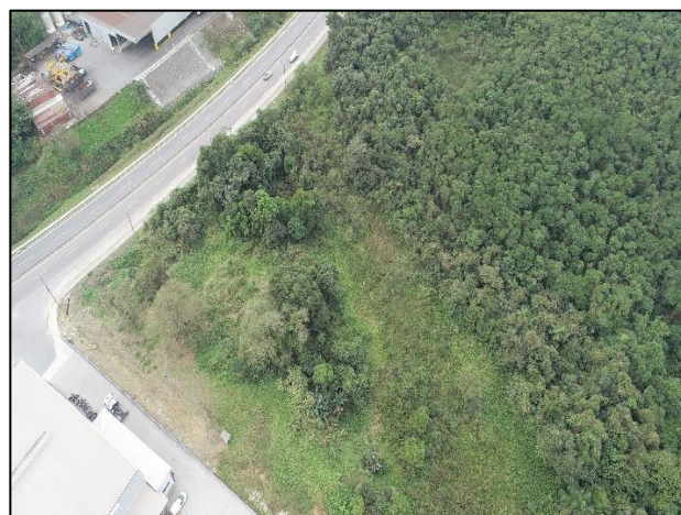
Figura 45: (R32) Vista aérea geral com destaque da proximidade dos trechos com a via (Fonte: Carbono Engenharia, 2024).
