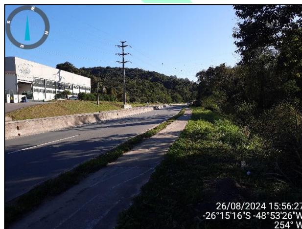
Figura 22: (R12) Vista para trecho 35-a com destaque para a vegetação presente nas margens e proximidade com a via (Fonte: Carbono Engenharia, 2024).
