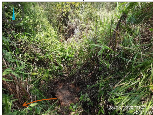
Figura 36 – (R25) Vista para a saída da tubulação fechada sob via, do trecho 39 (Fonte: Carbono Engenharia, 2024).
