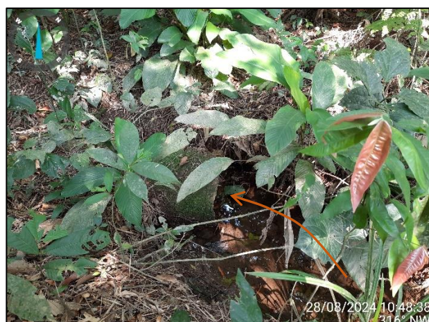
Figura 33: (R22) Vista para o início da tubulação fechada sob via do trecho 55 com destaque para a presença de vegetação no entorno (Fonte: Carbono Engenharia, 2024).
