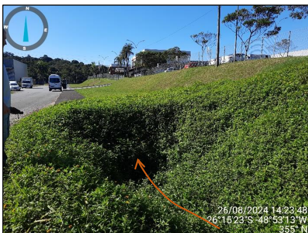
Figura 30: (R19) Vista para o início da tubulação fechada sob via do trecho 60, com destaque para a antropização presente nas margens (Fonte: Carbono Engenharia 2024).
