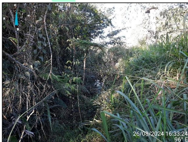
Figura 21: (R11) Vista para o trecho 20-a com destaque para a vegetação presente nas margens (Fonte: Carbono Engenharia, 2024).
