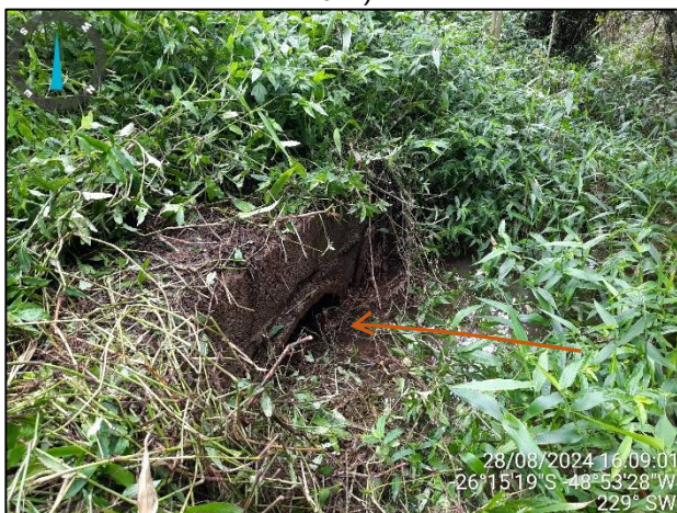
Figura 25: (R15) Vista para a saída da tubulação no trecho 33 com destaque para a presença de vegetação no entorno (Fonte: Carbono Engenharia, 2024).
