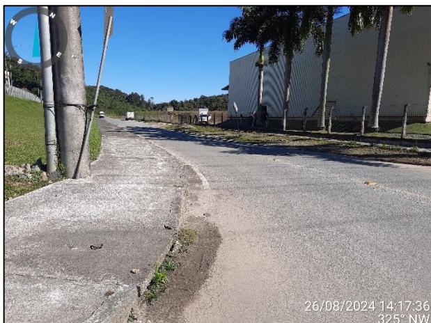
Figura 28: (R17) Vista para trecho 62, trecho tubulado sob via (Fonte: Carbono Engenharia, 2024).
