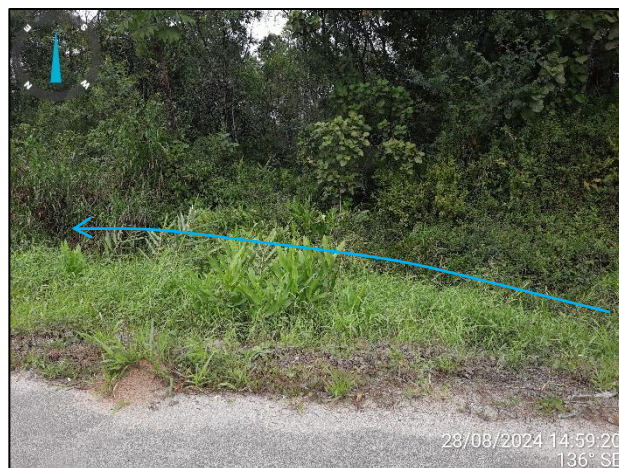
Figura 43: (R30) Vista para ponto jusante do trecho 71 com destaque para vegetação próxima a via (Fonte: Carbono Engenharia, 2024).
