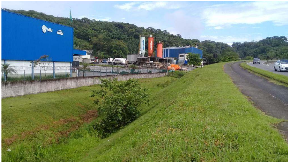
Figura 29: Margens do trecho 3, tubulado, vista para montante. Fonte: Autores.
