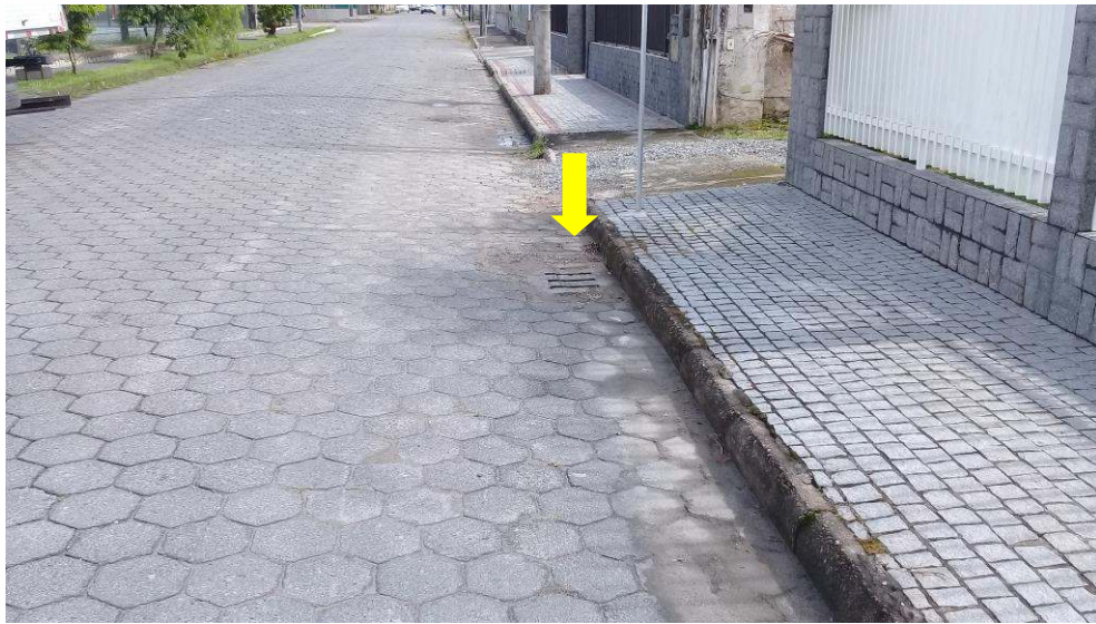
Figura 9: Boca de lobo na rua Guaporé. Fonte: Autores.
