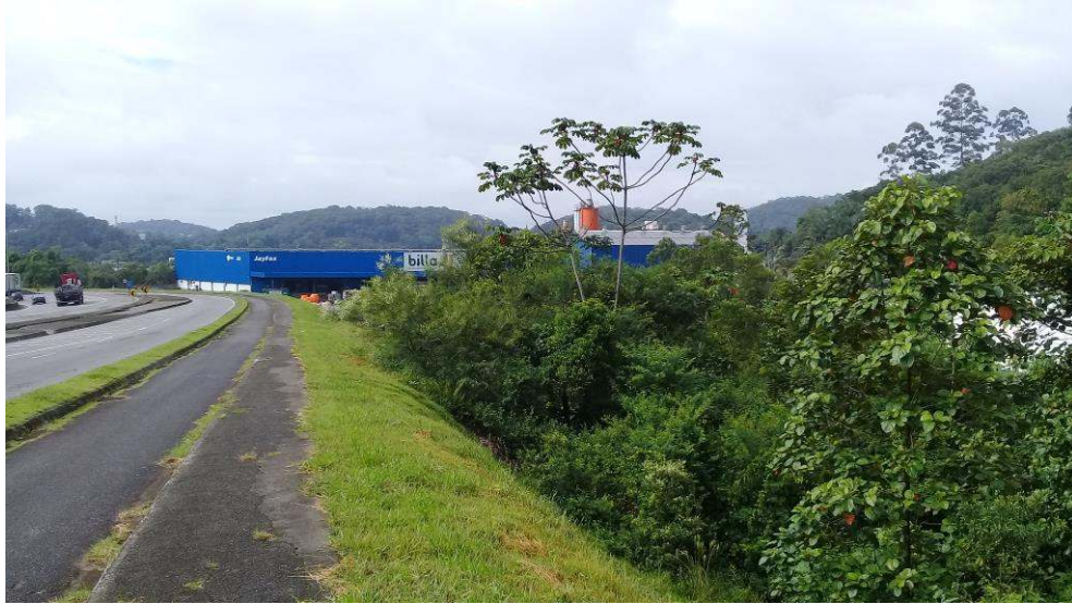
Figura 27: Margem esquerda do trecho 2, vista para jusante. Fonte: Autores.
