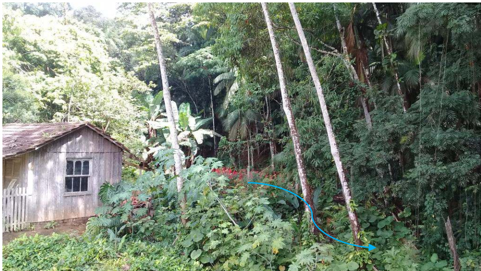
Figura 20: Margens do trecho 1E, vista para montante. Fonte: Autores.
