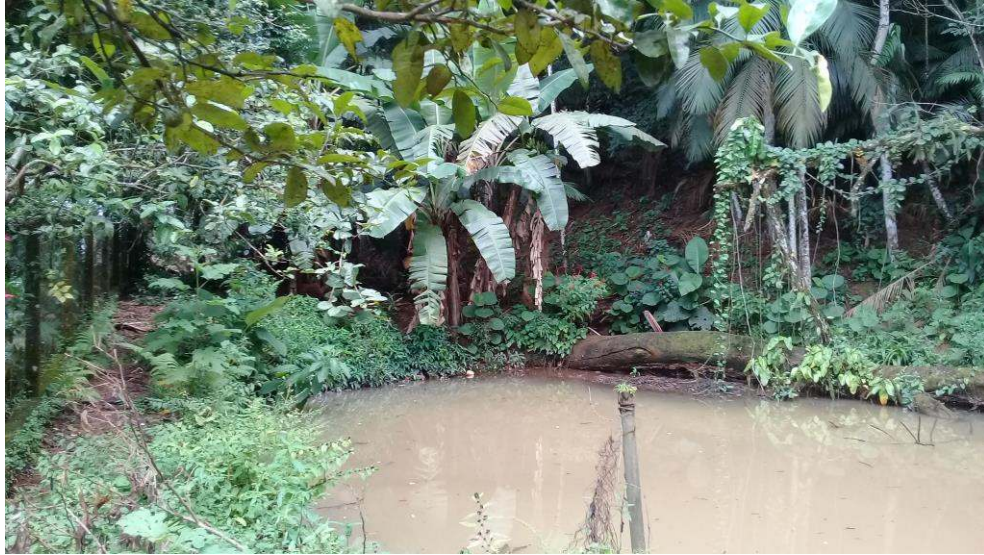
Figura 19: Reservatório, trecho 1D. Fonte: Autores.
