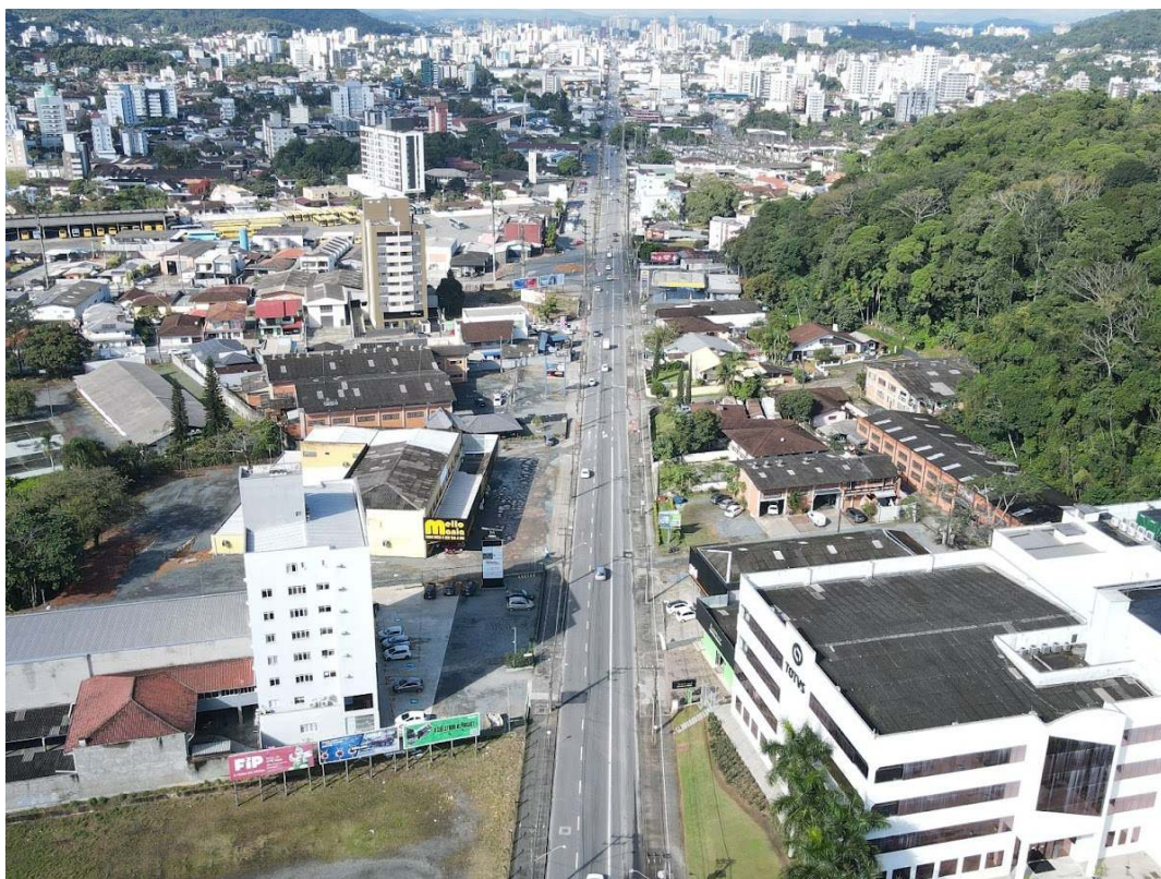
Figura 22: Vista aérea do Trecho 9. Fonte: Asteka Ambiental, 2024.
