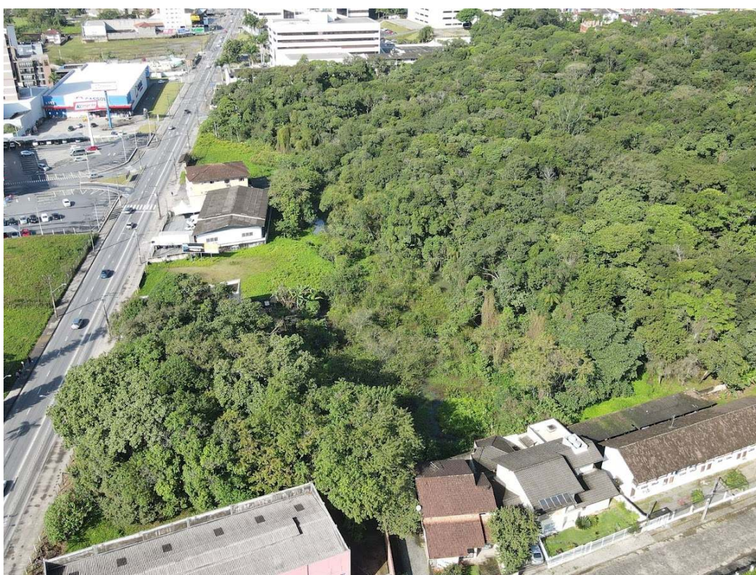
Figura 15: Vista aérea dos Trechos 1 e 7. Fonte: Asteka Ambiental, 2024.
