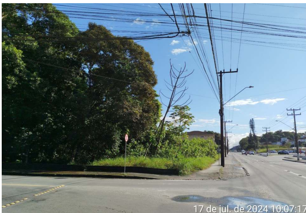
Figura 19: Vista do início do Trecho 8. Fonte: Asteka Ambiental, 2024.
