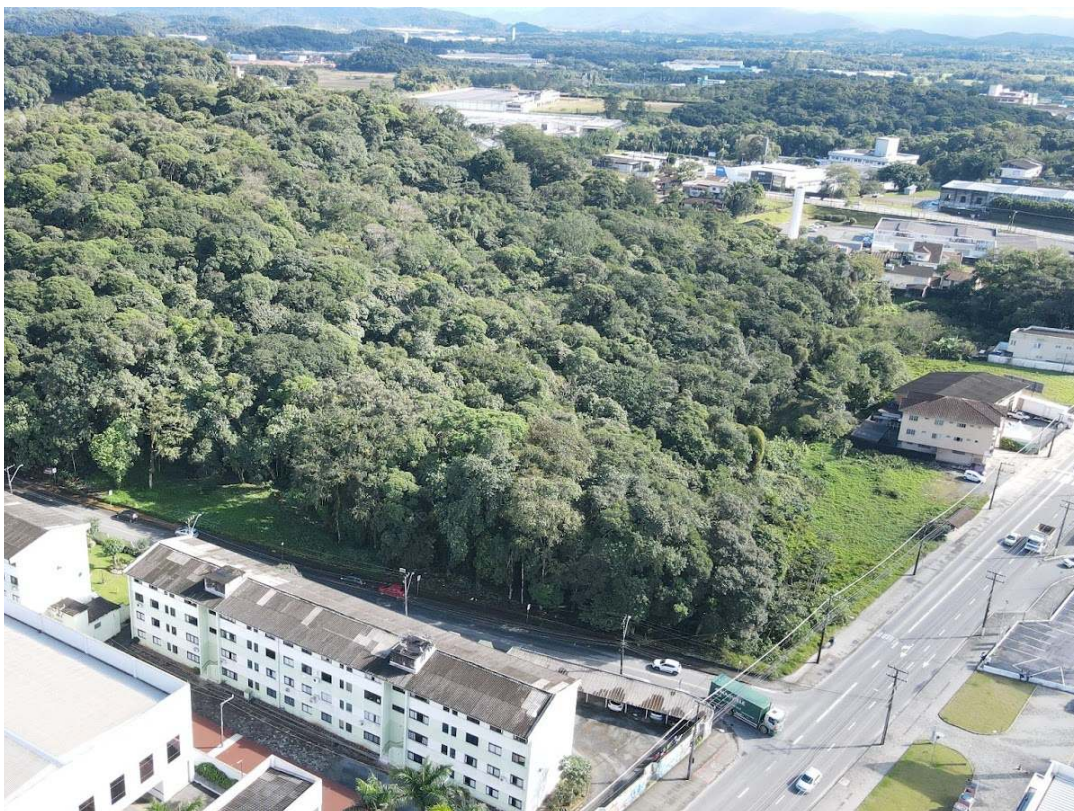
Figura 14: Vista aérea dos Trechos 2, 3, 4, 5 e 6. Fonte: Asteka Ambiental, 2024.
