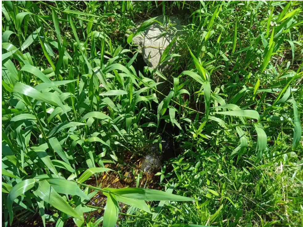
Figura 49: Detalha da tubulação, início do trecho 11. Fonte: Autores.
