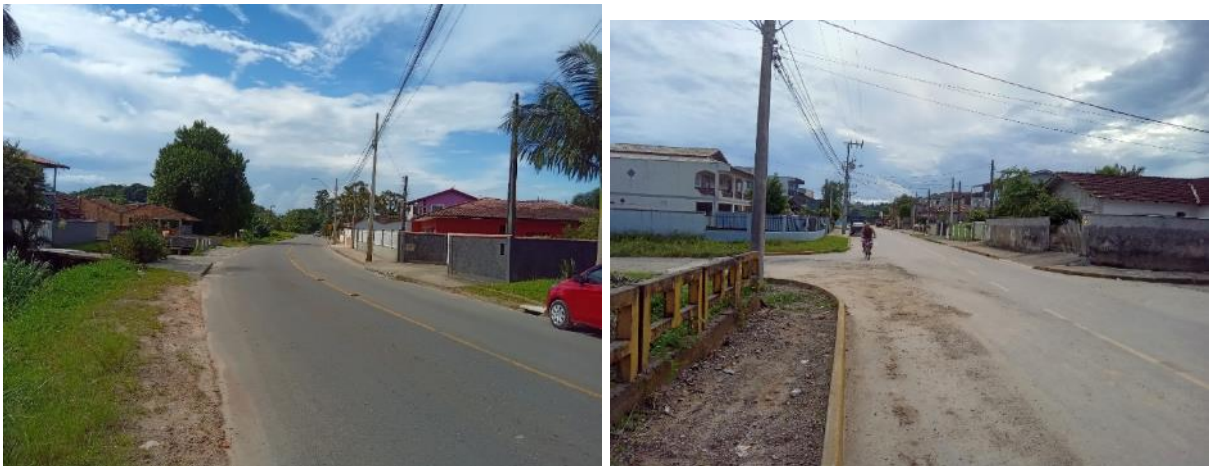
Figura 18: Rua Niralci de Oliveira Sant'ana, margem direita do trecho 51 (esq.) e rua Passo Fundo, trecho 82 (dir.), pavimentadas. Fonte: Autores.
