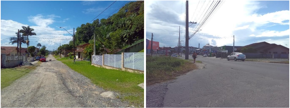
Figura 17: Rua Santo Amaro da Purificação, trecho 11, não pavimentada (esq.) e rua Boehmerwald esquina com rua São Francisco de Assis, trecho 12 (dir.), pavimentada. Fonte: Autores.
