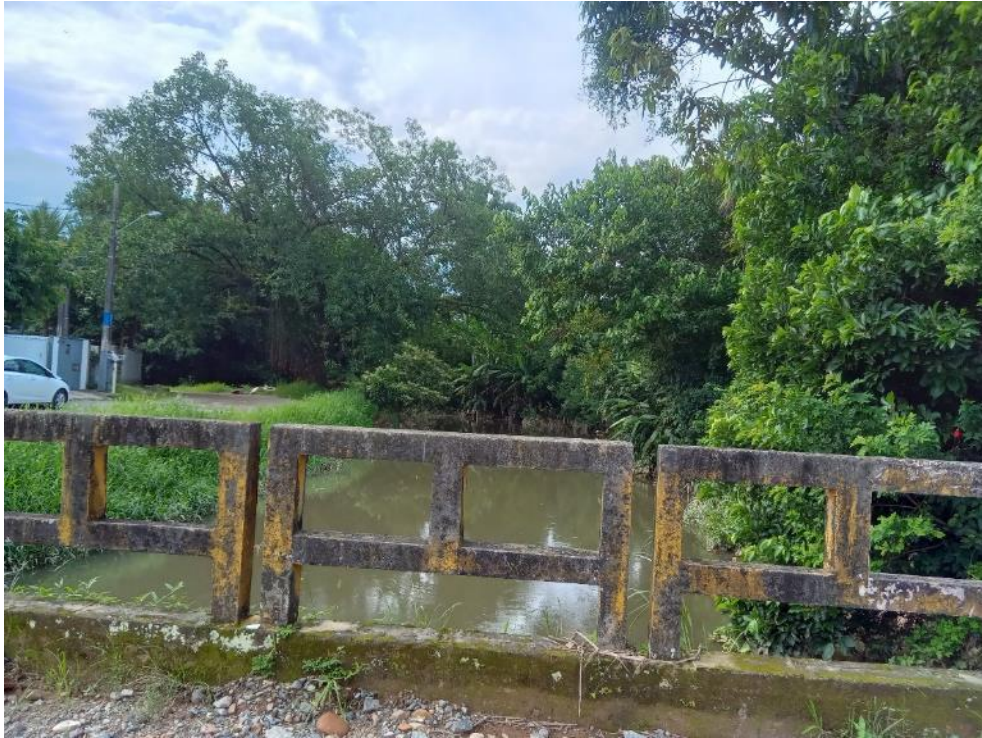
Figura 88: Trecho 83, vista para jusante a partir do trecho 82. Fonte: Autores.
