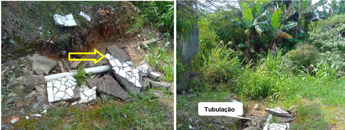
Figura 15: Lançamento de águas residuais em corpo d'água, trecho 49, rua Maria Pires Gomes dos Santos. Fonte: Autores.
