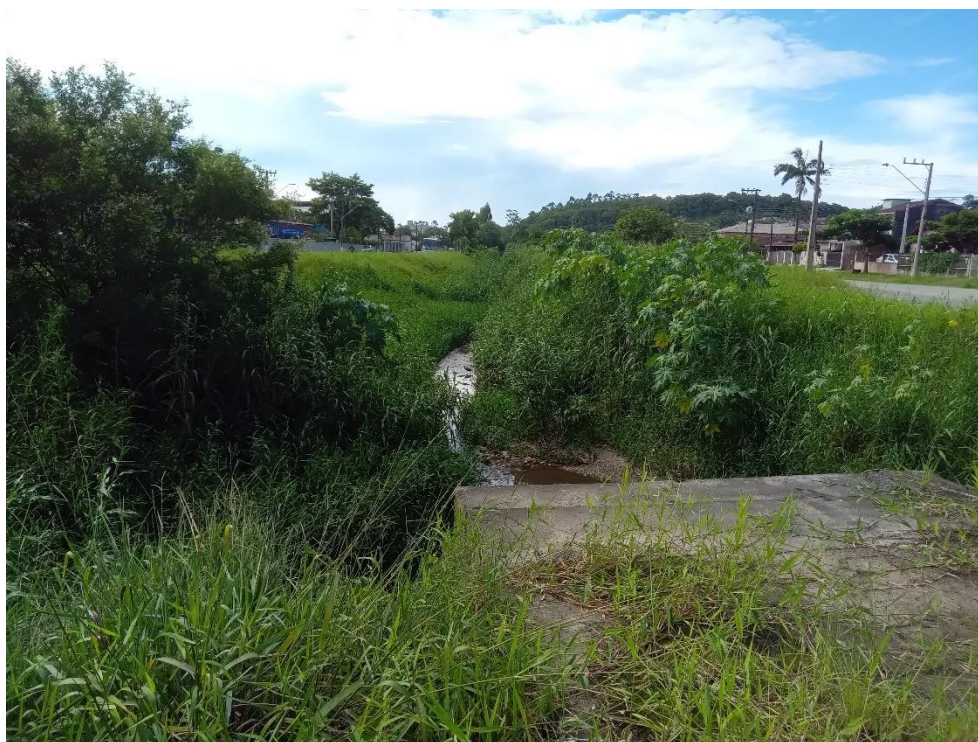
Figura 66: Trecho 39, com vista para jusante, a partir do trecho 38. Fonte: Autores.
