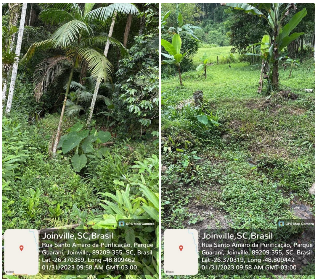
Figura 31: Trecho 5a, vista para montante (esq.) e para jusante (dir.). Localização: 718564.43 m E; 7081443.80 m S. Fonte: Arquivo.
