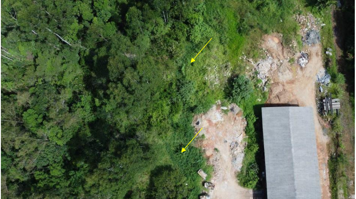
Figura 55: Entorno dos trechos 23 e 24. Fonte: Autores.
