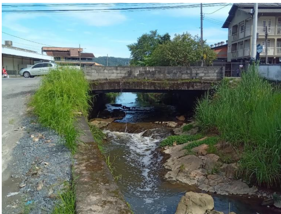
Figura 79: Trecho 67, margem direita, vista para montante (trecho 66, sob via). Fonte: Autores.
