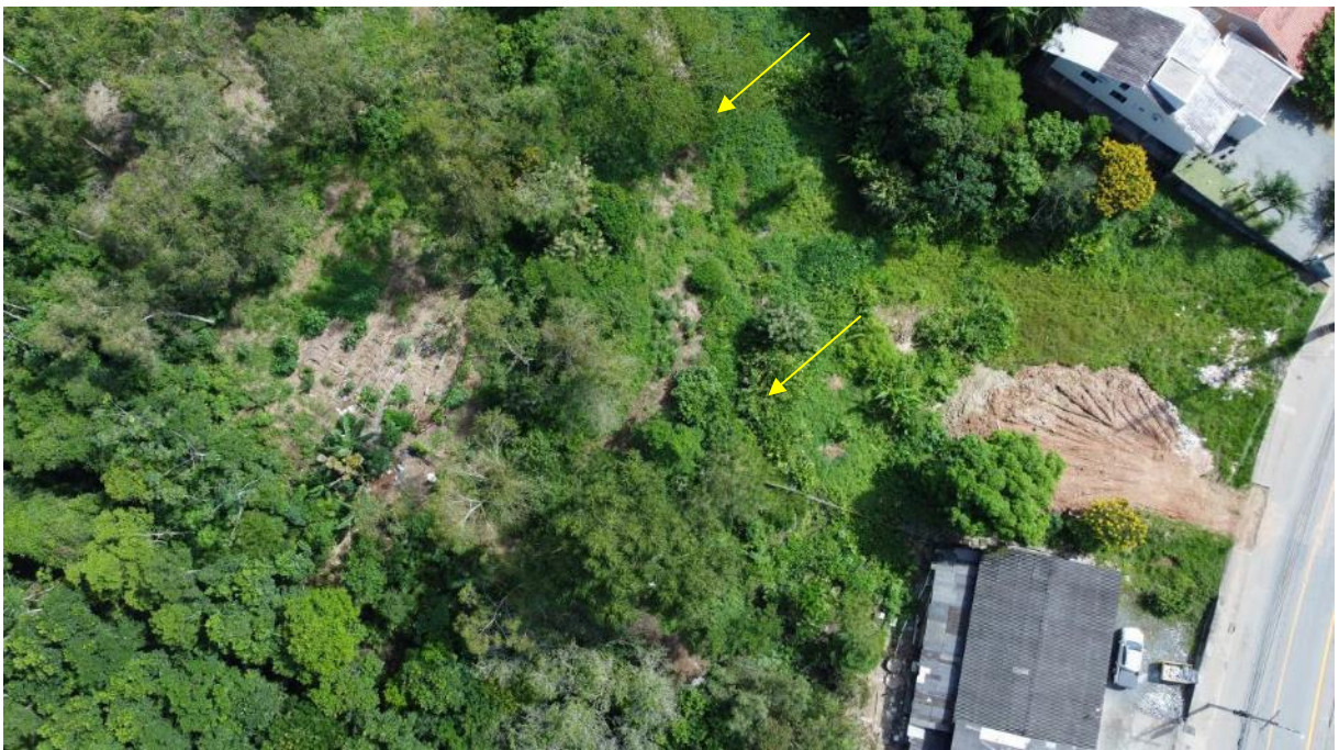
Figura 58: Entorno dos trechos 24 e 25. Indicação do trecho na figura. Fonte: Autores.
