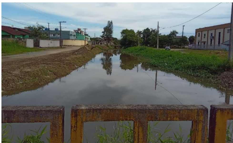
Figura 87: Trecho 81, vista para montante a partir do trecho 82. Fonte: Autores.
