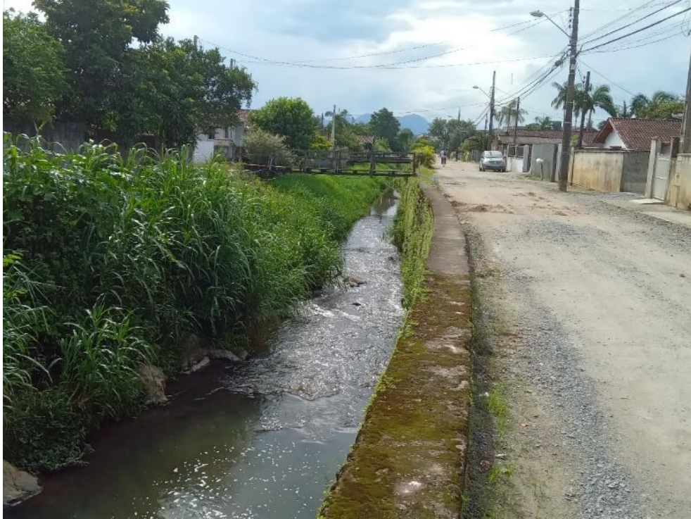
Figura 80: Trecho 67, margem direita, vista para jusante. Fonte: Autores.
