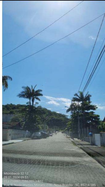
Figura 37: Área sobre o trecho 29 (tubulado). Fonte: Autor, 2024.
