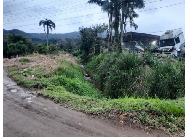
Figura 23: Trecho 25 (R5), vista para ocupação urbana – edificações e via pública (Fonte: Carbono Engenharia, 2023).
