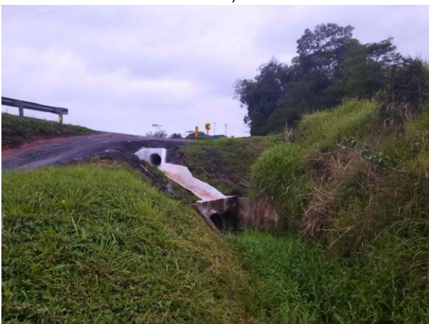
Figura 32: Trecho 45 e 46 (R9), vista para ocupação urbana – via pública (Fonte: Carbono Engenharia, 2023).
