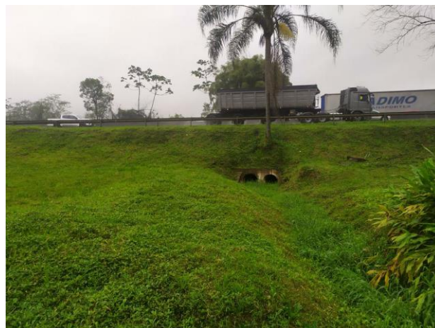
Figura 35: Trecho 48-2 e 49 (R11), vista para ocupação urbana – via pública (Fonte: Carbono Engenharia, 2023).
