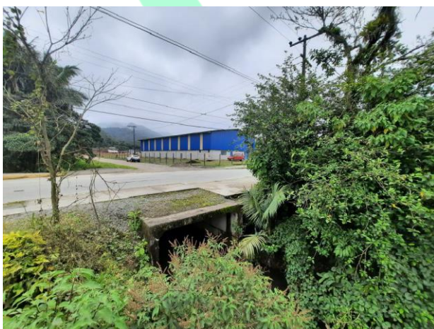
Figura 50: Trecho 69 (R18), vista para ocupação urbana (Fonte: Carbono Engenharia, 2023).
