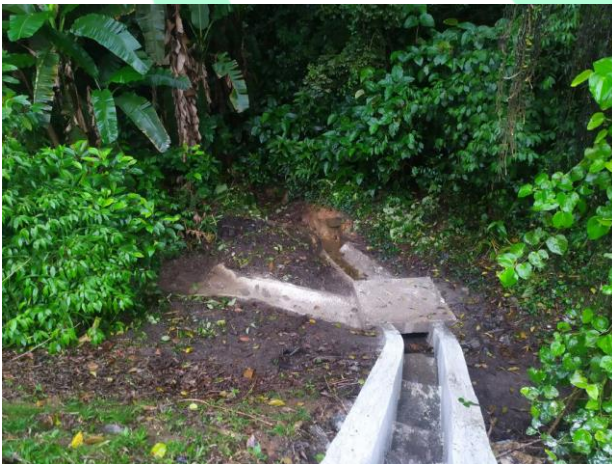
Figura 38: Trecho 55-3 e 56 (R13), vista para região de transição entre vegetação e ocupação urbana – via pública (Fonte: Carbono Engenharia, 2023).
