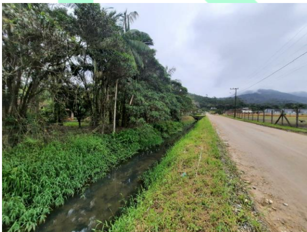
Figura 48: Trecho 68 (R18), vista para ocupação urbana (Fonte: Carbono Engenharia, 2023).
