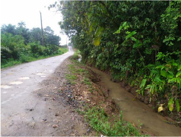
Figura 28: Trecho 39 e 40 (R7), vista para vegetação e ocupação urbana – via pública (Fonte: Carbono Engenharia, 2023).
