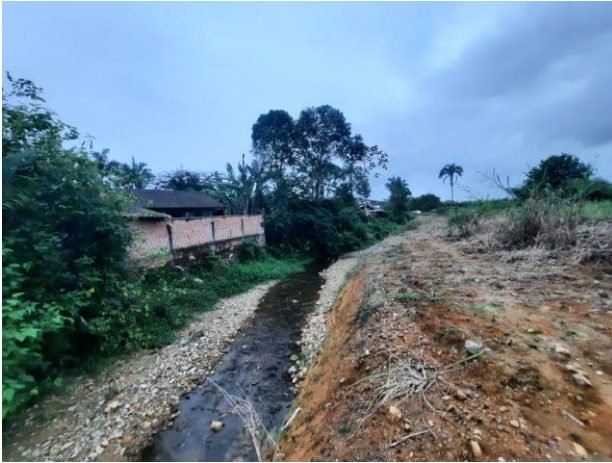
Figura 22: Trecho 25 (R4), vista para ocupação – edificações e atividades rurais (Fonte: Carbono Engenharia, 2023).
