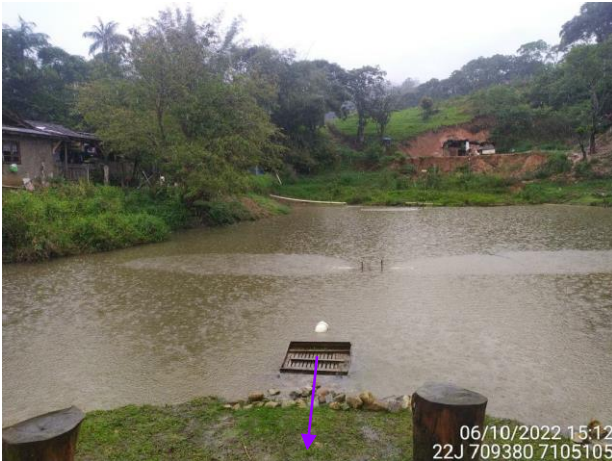
Figura 55: Trecho 76-2 e 77 (R20), vista para ocupação urbana (Fonte: Carbano Engenharia, 2023).
