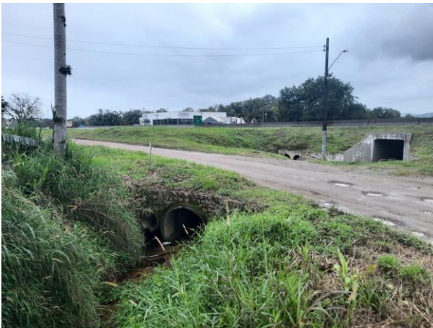
Figura 24: Trecho 25, 26 e 27 (R6), vista para ocupação urbana – vias públicas (Fonte: Carbono Engenharia, 2023).
