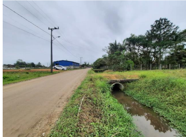
Figura 47: Trecho 68 (R17-2), vista para ocupação urbana (Fonte: Carbono Engenharia, 2023).
