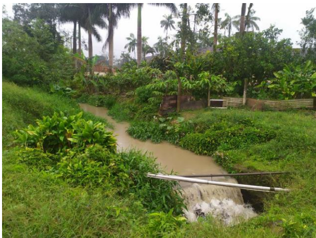
Figura 52: Trecho 70 (R19), vista para ocupação urbana (Fonte: Carbono Engenharia, 2023).
