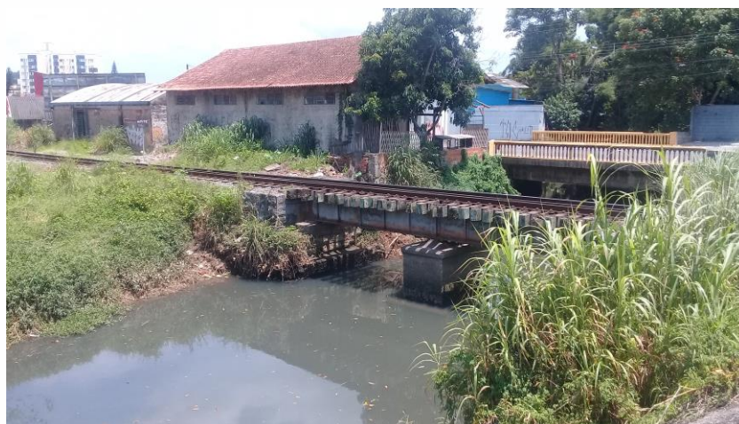
Figura 65: Trecho 106, vista o trecho 105. Fonte: Autores.
