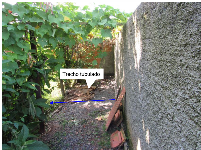
Figura 35: Trecho 36, parte tubulada devido ao muro. Fonte: Autores.
