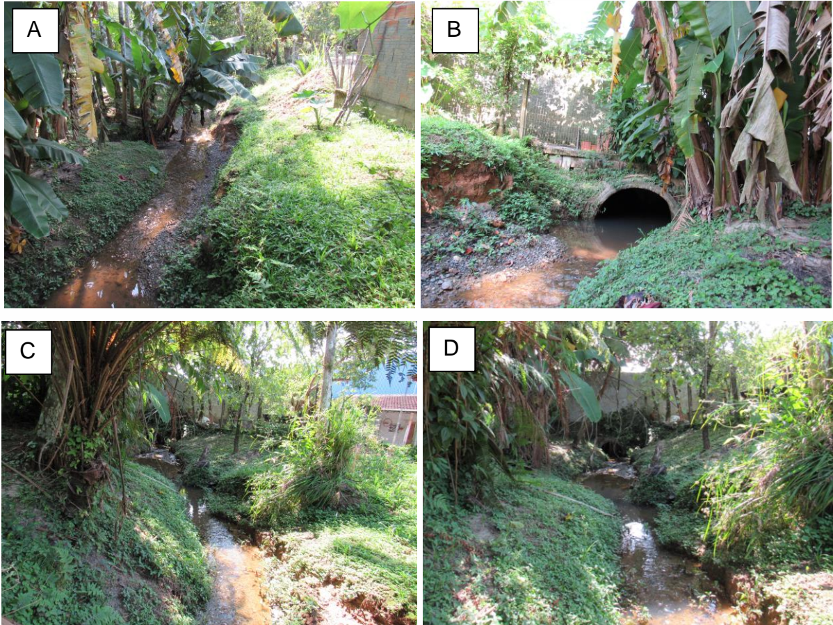
Figura 36: A: Início do trecho 36, vista para jusante; B: Trecho 36, vista para montante; C: Trecho 36, margem com edificações. D: Final do trecho 36, com vista para jusante (trecho 37, tubulado). Fonte: Autores.
