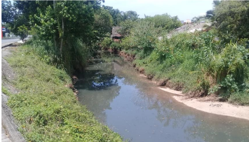
Figura 66: Trecho 106, vista para jusante, a partir da margem esquerda, próximo ao trilho de trem. Fonte: Autores.
