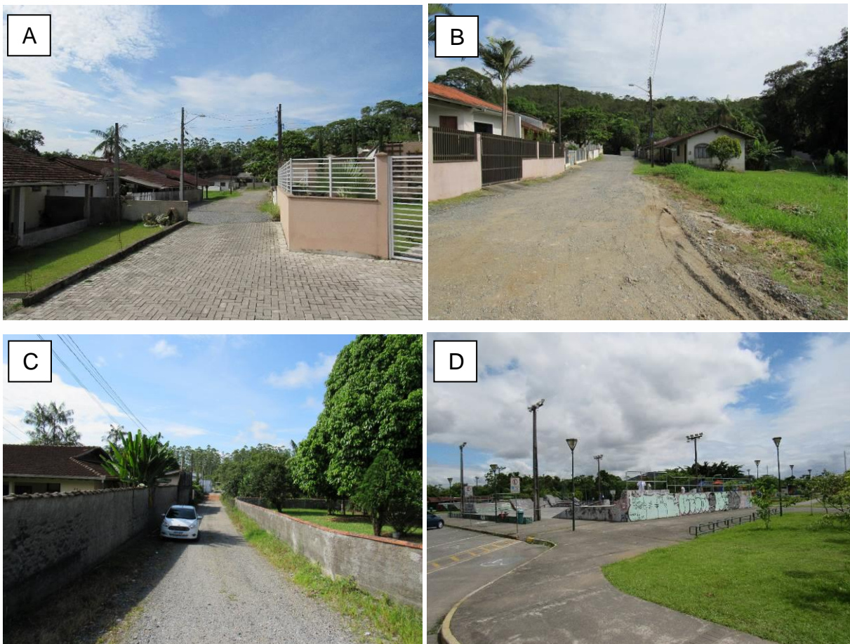
Figura 13: A: Infraestruturas: Servidão São Bartolomeu, próximo trecho 5; B: Rua Othon Mader, trecho 15; C: Rua Servidão Neelson Danker, trecho 24; D: Área de Lazer Parque da Cidade, setor Guanabara. Fonte: Autores.
