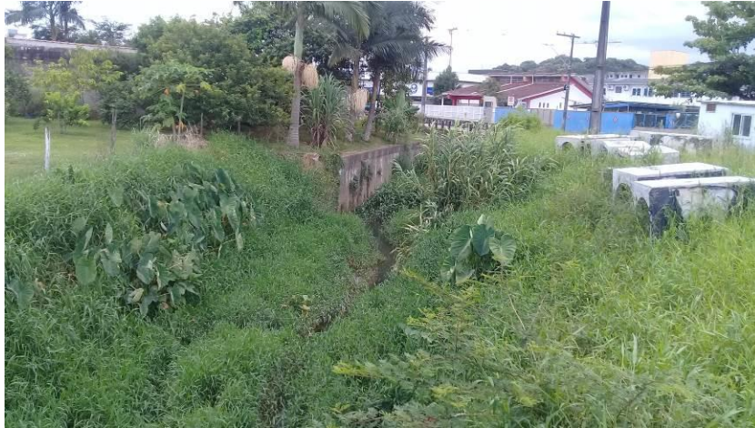
Figura 48: Trecho 50, vista para montante. Fonte: Autores.
