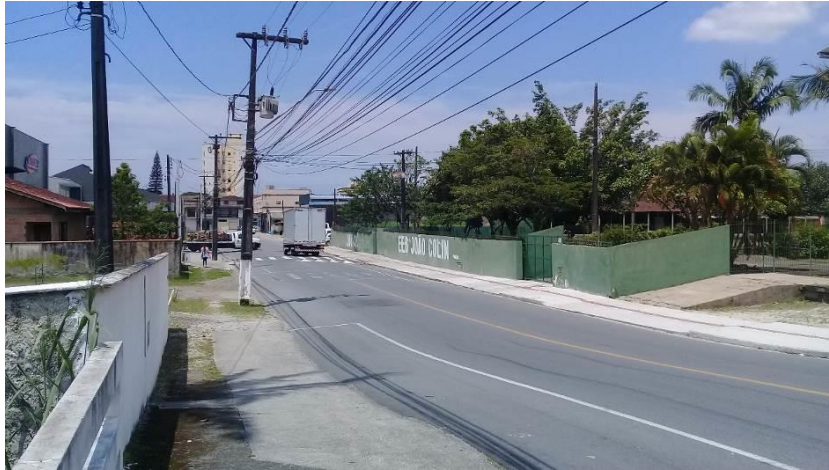
Figura 16: EBB João Colin, rua Botafogo, próximo ao trecho 99. Fonte: Autores.
