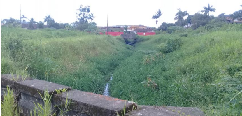
Figura 46: Trecho 44, vista para jusante, a partir do trecho 43. Fonte: Autores.
