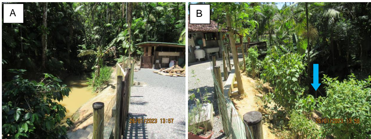
Figura 28: A: Trecho 10, vista para montante, a partir da margem esquerda. B: Margem esquerda dos trechos 10 e 11, vista para jusante. Fonte: Autores.
