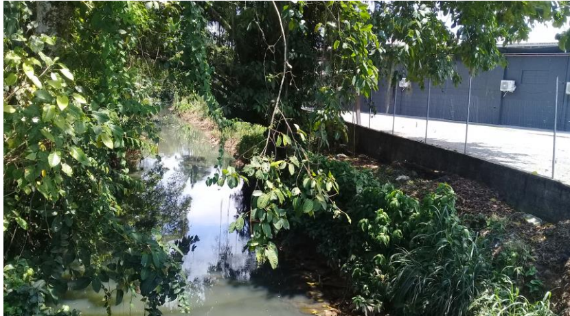
Figura 58: Trecho 98, vista para montante. Fonte: Autores.
