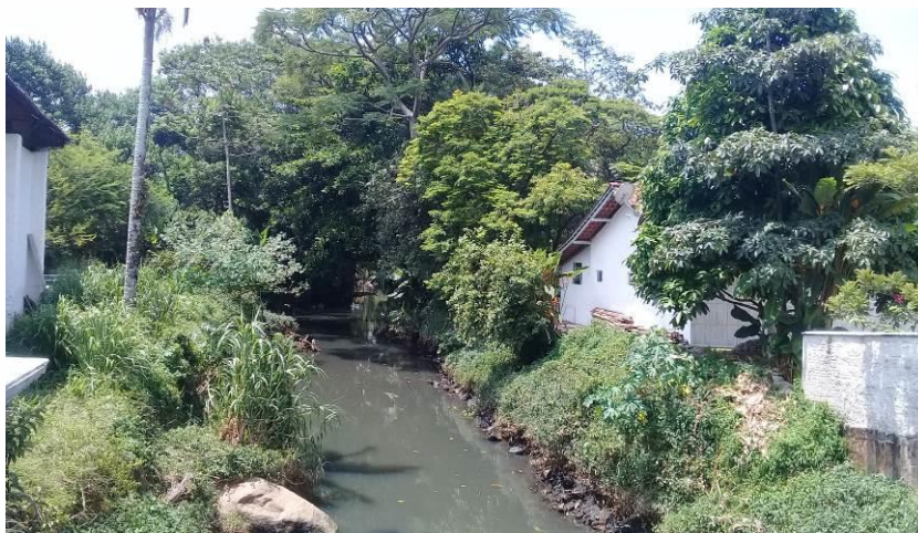
Figura 60: Trecho 100, vista para jusante, a partir do trecho 99. Fonte: Autores.
