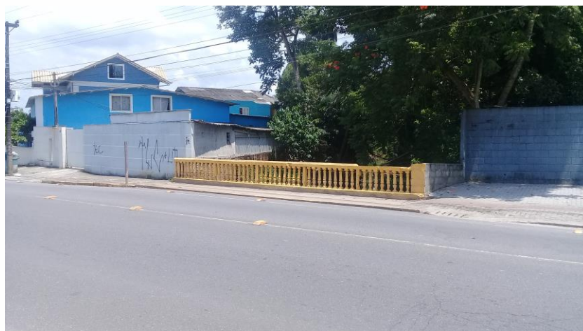
Figura 62: Vista para trecho 103, a partir da rua Monsenhor Gercino (trecho 104). Fonte: Autores.
