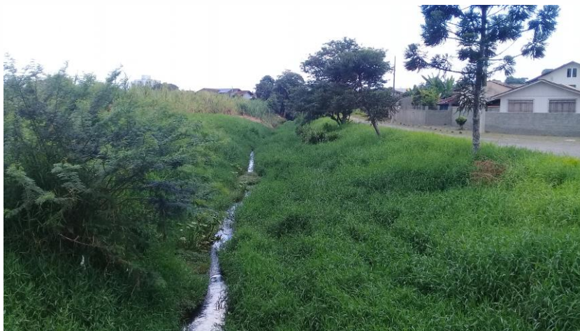
Figura 50: Trecho 50, vista para jusante, próximo à rua Ipira. Fonte: Autores.
