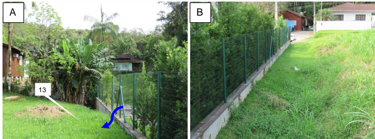
Figura 30: A: Contexto do trecho 13 (tubulado), vista para montante (12); B: trecho 13 (tubulado), vista para jusante, trecho 14. Fonte: Autores.
