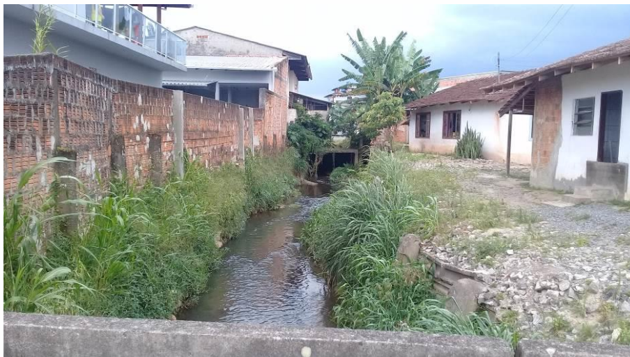
Figura 52: Trecho 67, vista para jusante, a partir do trecho 68. Fonte: Autores.
