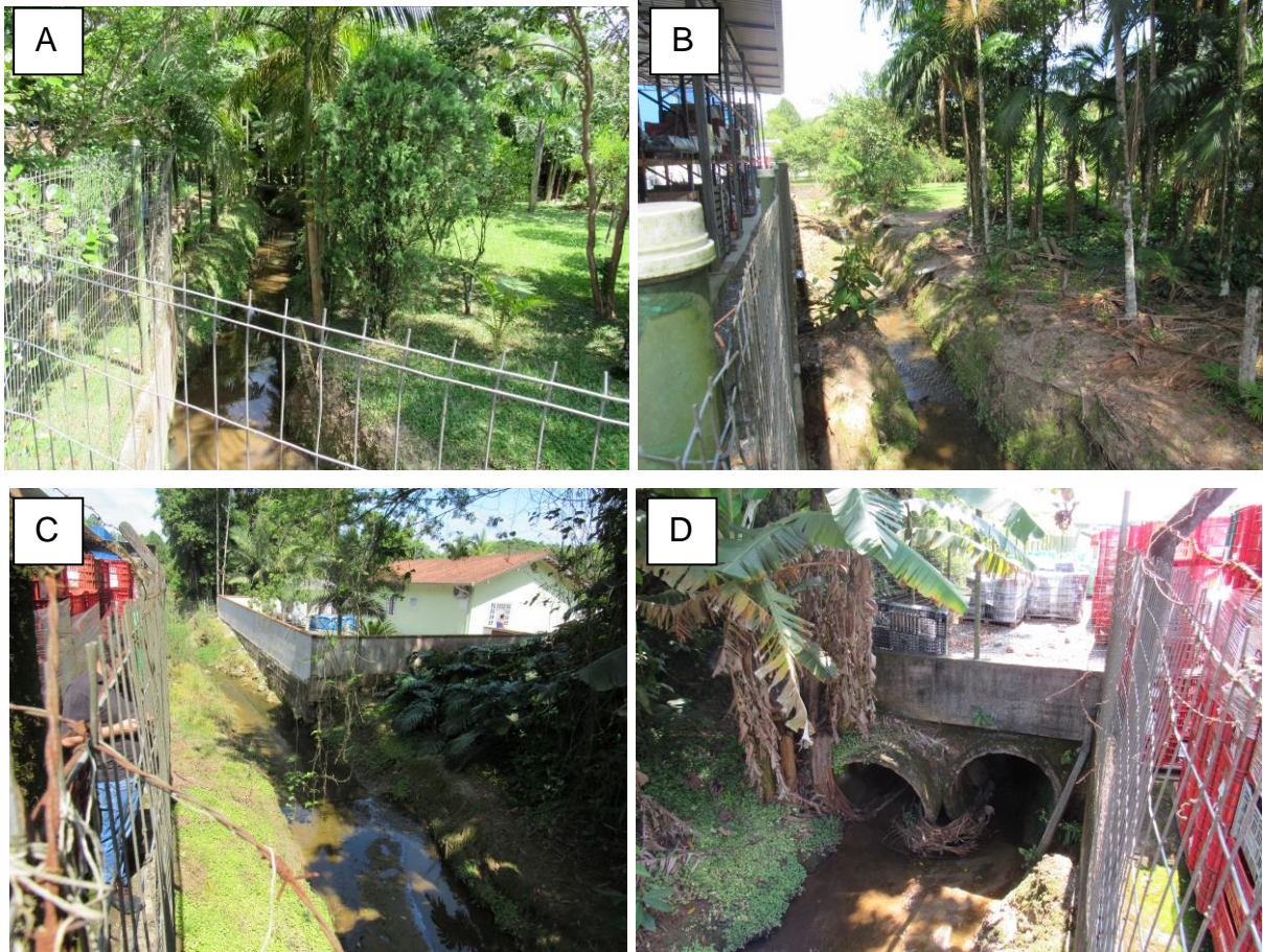
Figura 37: A: Início do trecho 38 no terreno da empresa Viqua, vista para montante; B: Trecho 38, vista para montante; C: Trecho 38, vista para montante, a partir do trecho 39; D: Trecho 38 para trecho 39 (tubulado). Fonte: Autores.
