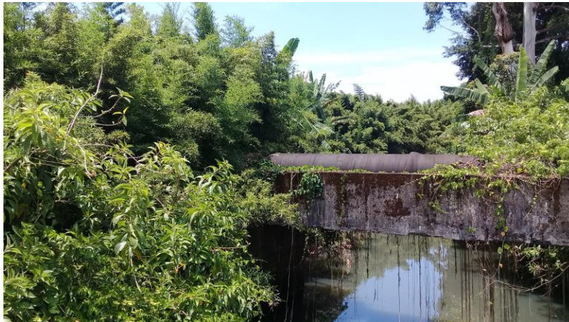
Figura 72: Trecho 108, vista para jusante a partir do trecho 107. Fonte: Autores.
