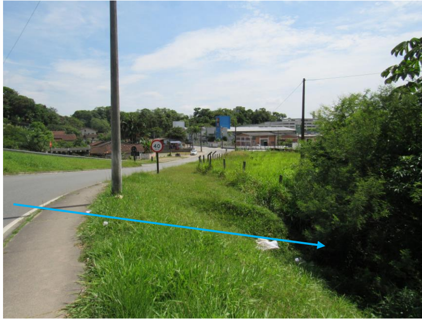
Figura 40: Contexto do trecho 40, tubulado sob via, para trecho 41, aberto. Fonte: Autores.
