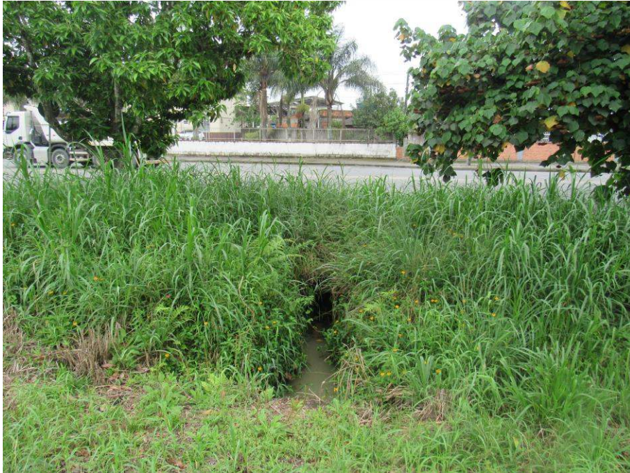
Figura 29: Trecho 04 (aberto), para trecho 05 (fechado, sob via). Fonte: Autores.
