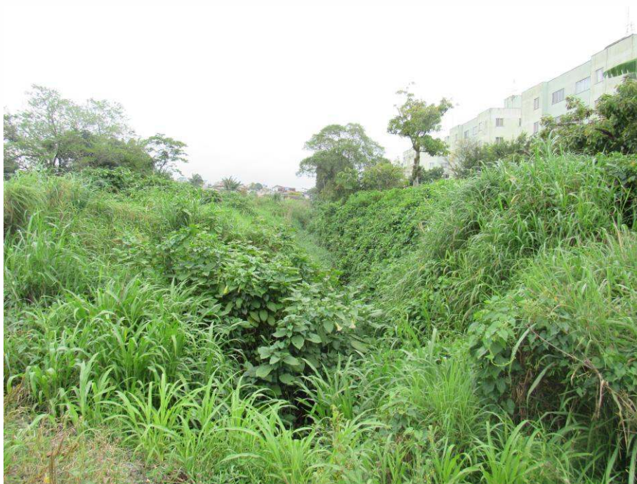
Figura 28: Trecho 04 (aberto). Vista para montante, a partir do trecho 05 (sob via). Fonte: Autores.
