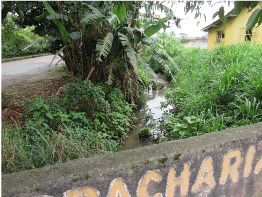
Figura 25: Início do trecho 04 (aberto), com vista a partir do trecho 03B (sob via), rua Monsenhor Gercino. Fonte: Autores.
