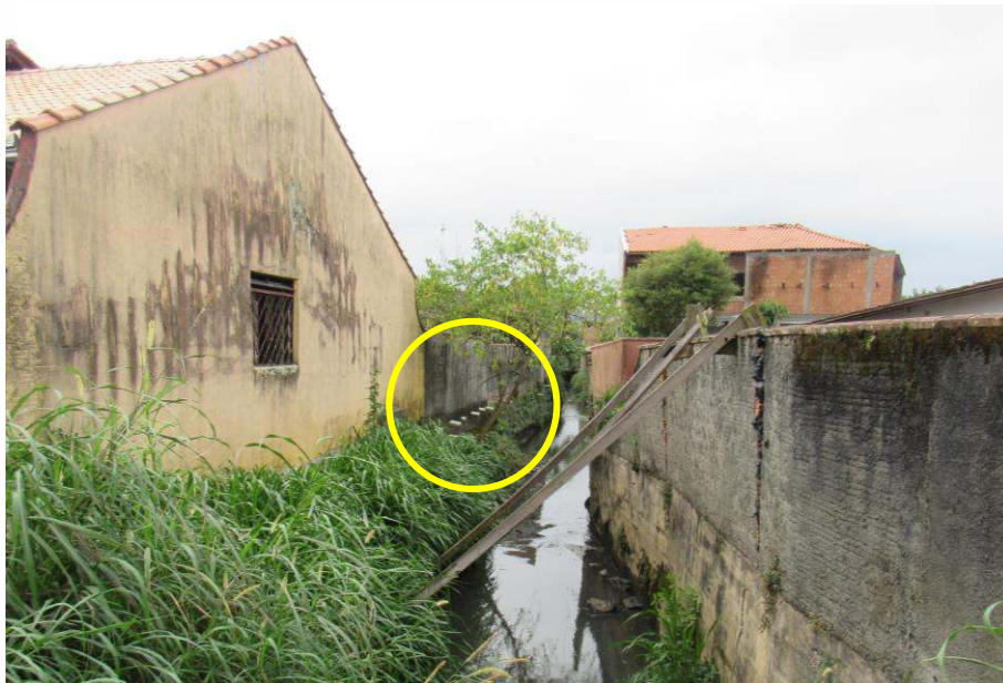
Figura 10: Tubulação para lançamento de águas servidas.
