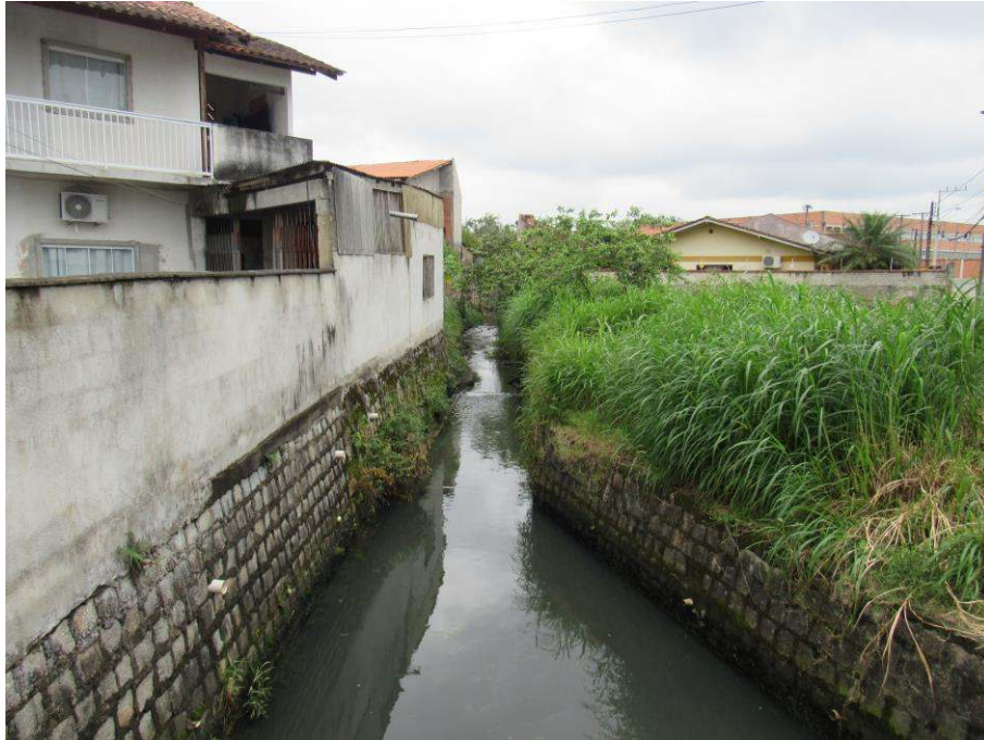
Figura 38: Final do trecho 14, vista a partir do trecho 15. Fonte: Autores.
