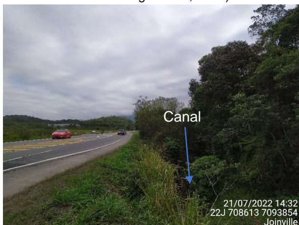
Figura 29: Trecho 88 (R3-2), vista para ocupação, trecho aberto misto (Fonte: Carbono Engenharia, 2022).
