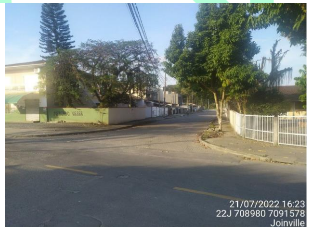
Figura 53: Trecho 157 (R14), vista para ocupação em trecho fechado sob via (Fonte: Carbono Engenharia, 2022).
