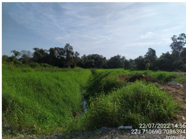
Figura 75: (R24) vista para faixas marginais do trecho 219 (Fonte: Carbono Engenharia, 2022).
