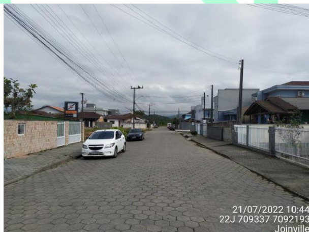
Figura 41: Trecho 124 (R6), vista E-O para ocupação, trecho fechado sob via (Fonte: Carbono Engenharia, 2022).
