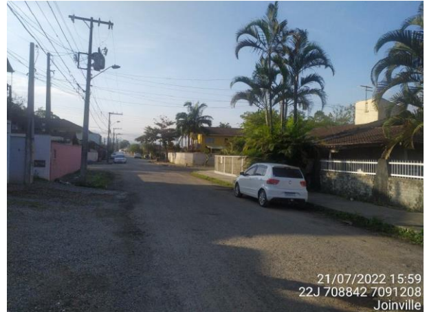
Figura 51: Trecho 154 (R12), vista para ocupação em trecho fechado sob via (Fonte: Carbono Engenharia, 2022).
