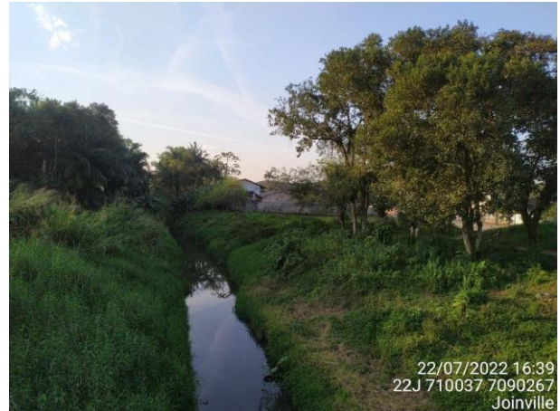
Figura 61: Trecho 160 (R18), vista S-N para ocupação em trecho aberto misto (Fonte: Carbono Engenharia, 2022).
