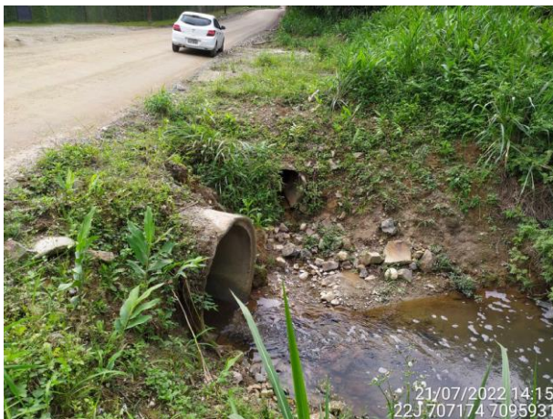
Figura 18: Trecho 1 (R1), vista para travessia da Estrada Anaburgo sob o corpo d'água (Fonte: Carbono Engenharia, 2022).
