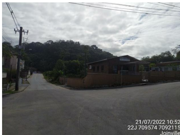
Figura 39: Trecho 120 (R5), vista para ocupação urbana, trecho fechado sob via (Fonte: Carbono Engenharia, 2022).
