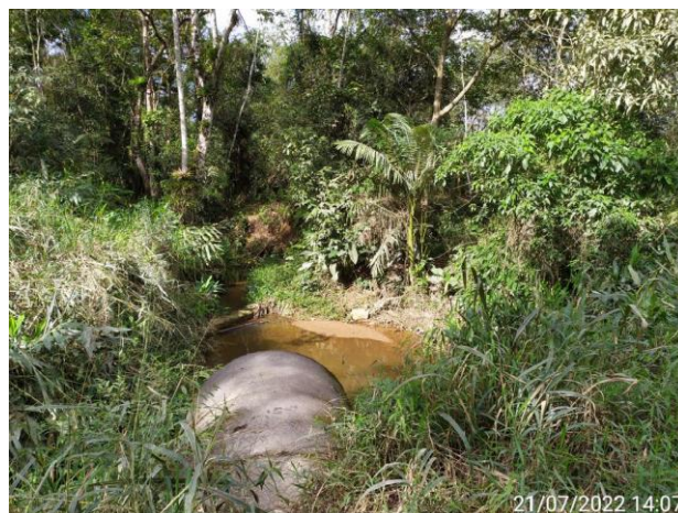
Figura 21: Trecho 39-1 (R2), vista geral para faixas marginais ao trecho 39 (Fonte: Carbono Engenharia, 2022).
