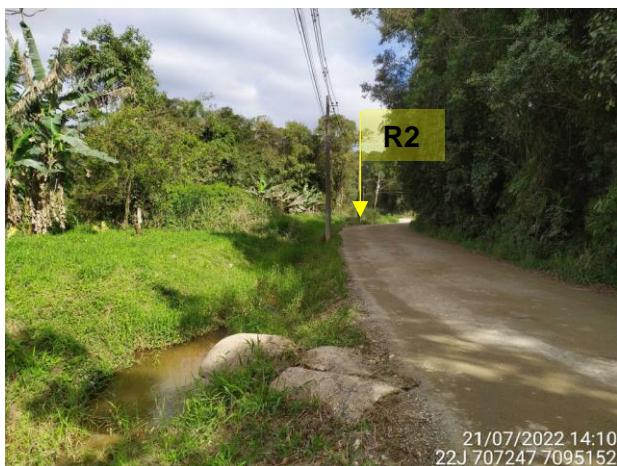
Figura 20: Trecho 38-3 (R2), vista geral para faixas marginais ao trecho 38 (Fonte: Carbono Engenharia, 2022).
