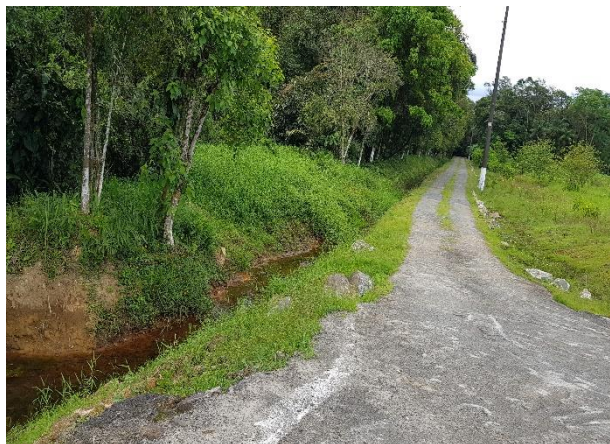
Figura 31: Trecho 84 (R3-4), vista para ocupação urbana, trecho aberto misto (Fonte: Carbono Engenharia, 2022).
