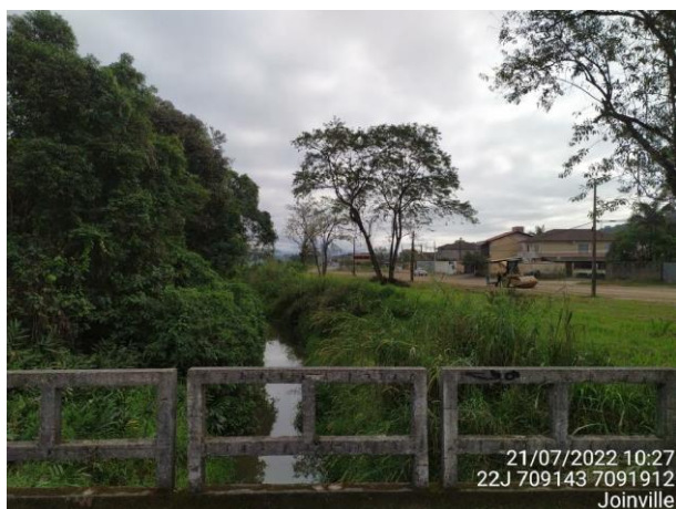
Figura 48: Trecho 150 (R10), vista S-N para ocupação em trecho aberto misto (Fonte: Carbono Engenharia, 2022).
