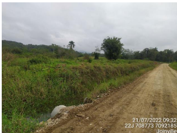
Figura 44: Trecho 132 (R8), vista S-N para ocupação em trecho aberto em meio antropizado (Fonte: Carbono Engenharia, 2022).
