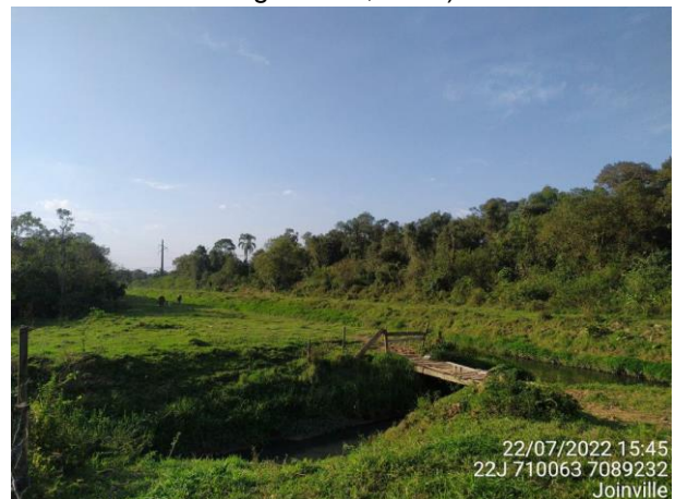
Figura 65: Trecho 180 (R20), trecho aberto sob lotes (Fonte: Carbono Engenharia, 2022).
