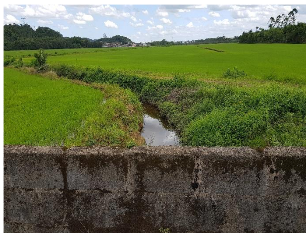
Figura 34: Trecho 107 (R3-7), vista para área antropizada, trecho aberto em meio antropizado (Fonte: Carbono Engenharia, 2022).
