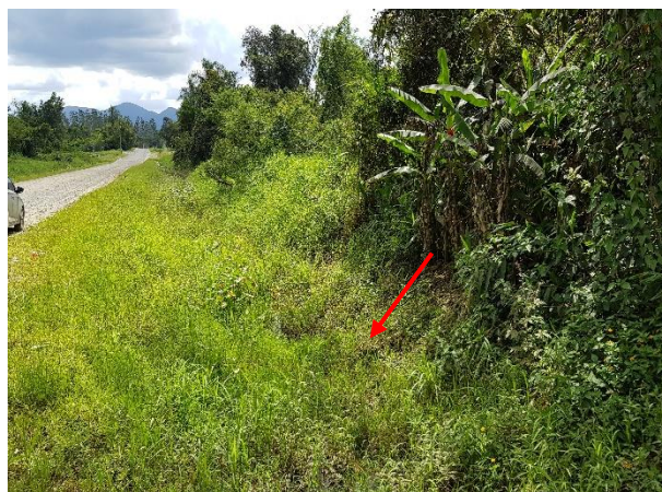
Figura 73: Trecho 206 (R23), vista para ocupação externa a AUC, vista L-O para trecho aberto misto (Fonte: Carbono Engenharia, 2022).
