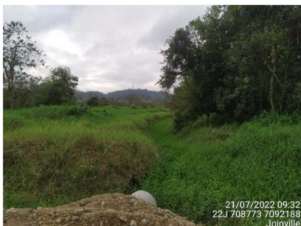
Figura 46: Trecho 140 e 141 (R8), vista para área antropizada em trecho aberto misto após trecho tubulado (Fonte: Carbono Engenharia, 2022).
